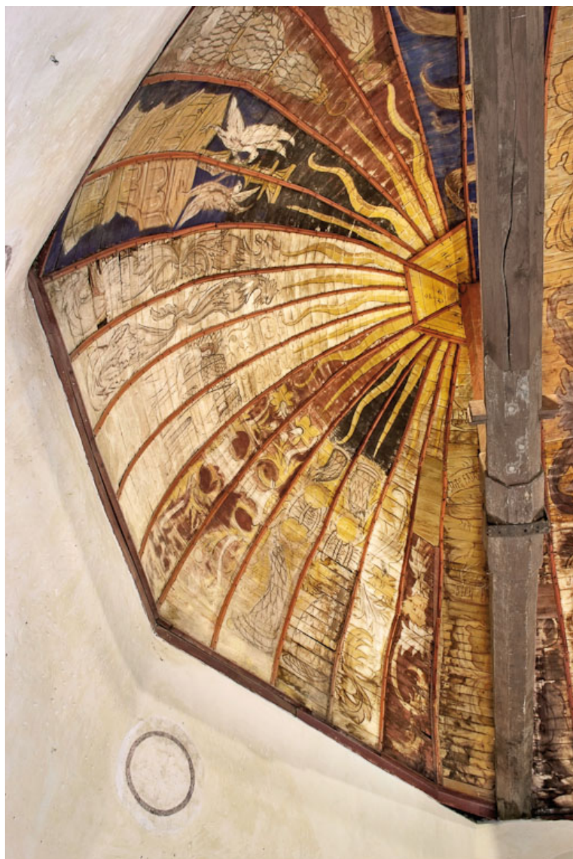
Détail de la voûte lambrissée et de son décor peint.
