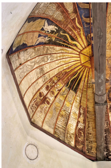
Détail de la voûte lambrissée et de son décor peint. IVR26_20098900136NUC2A
