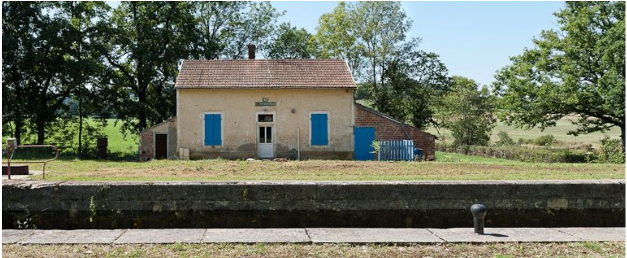
Vue de face de la maison éclusière.
