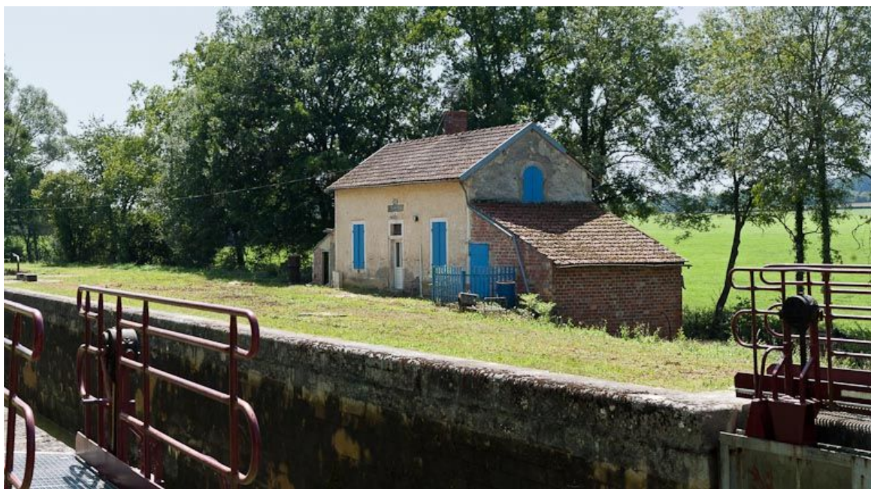
Vue d'ensemble du site d'écluse.
