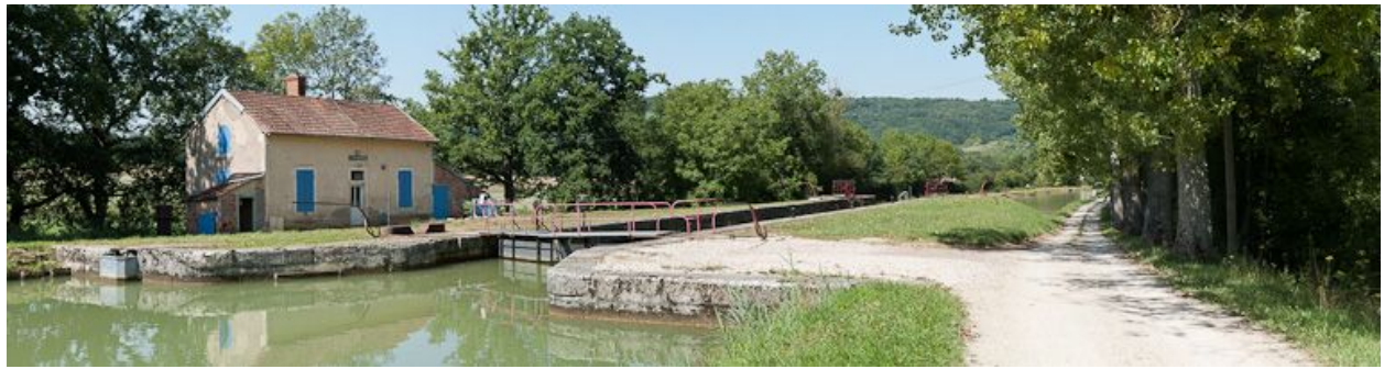
Vue du site d'écluse depuis l'amont.
