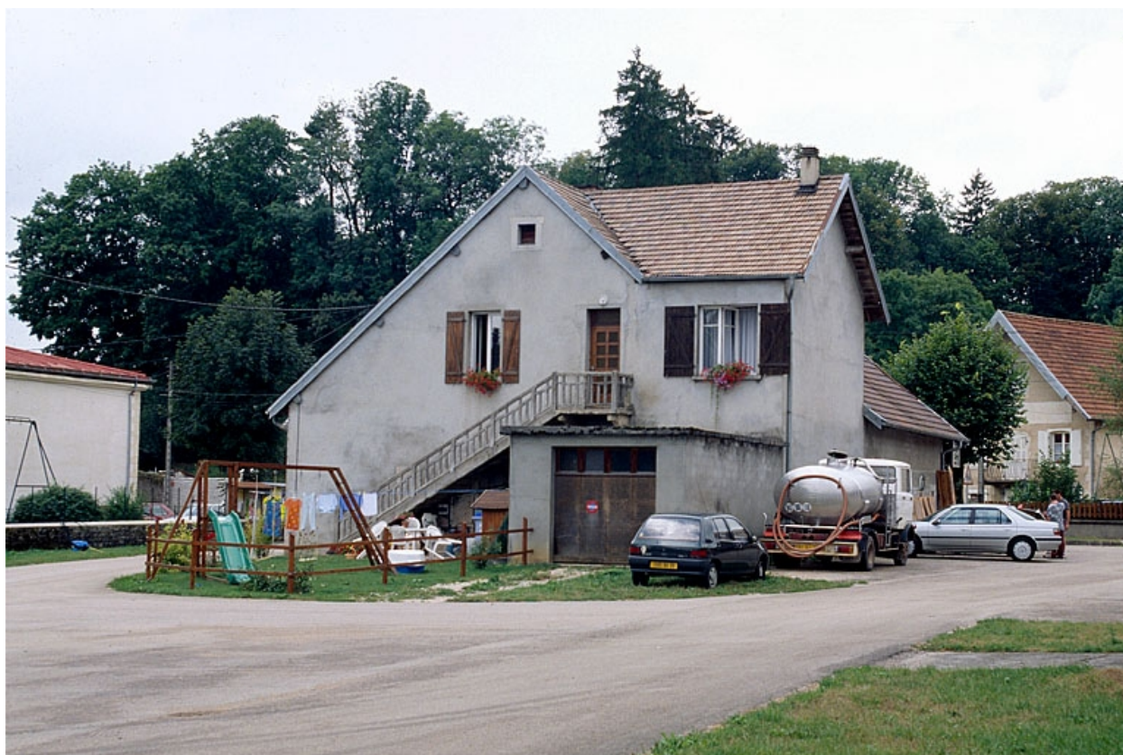
Logement sur façade postérieure.
