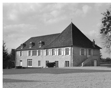
L'ancienne orangerie. Phot. Jérôme Mongreville IVR43_19853900096X
