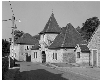
Pavillon d'entrée, élévation sur la rue. Phot. Yves Sancey IVR43_19843900189X
