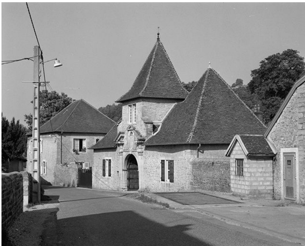
Pavillon d'entrée, élévation sur la rue.
