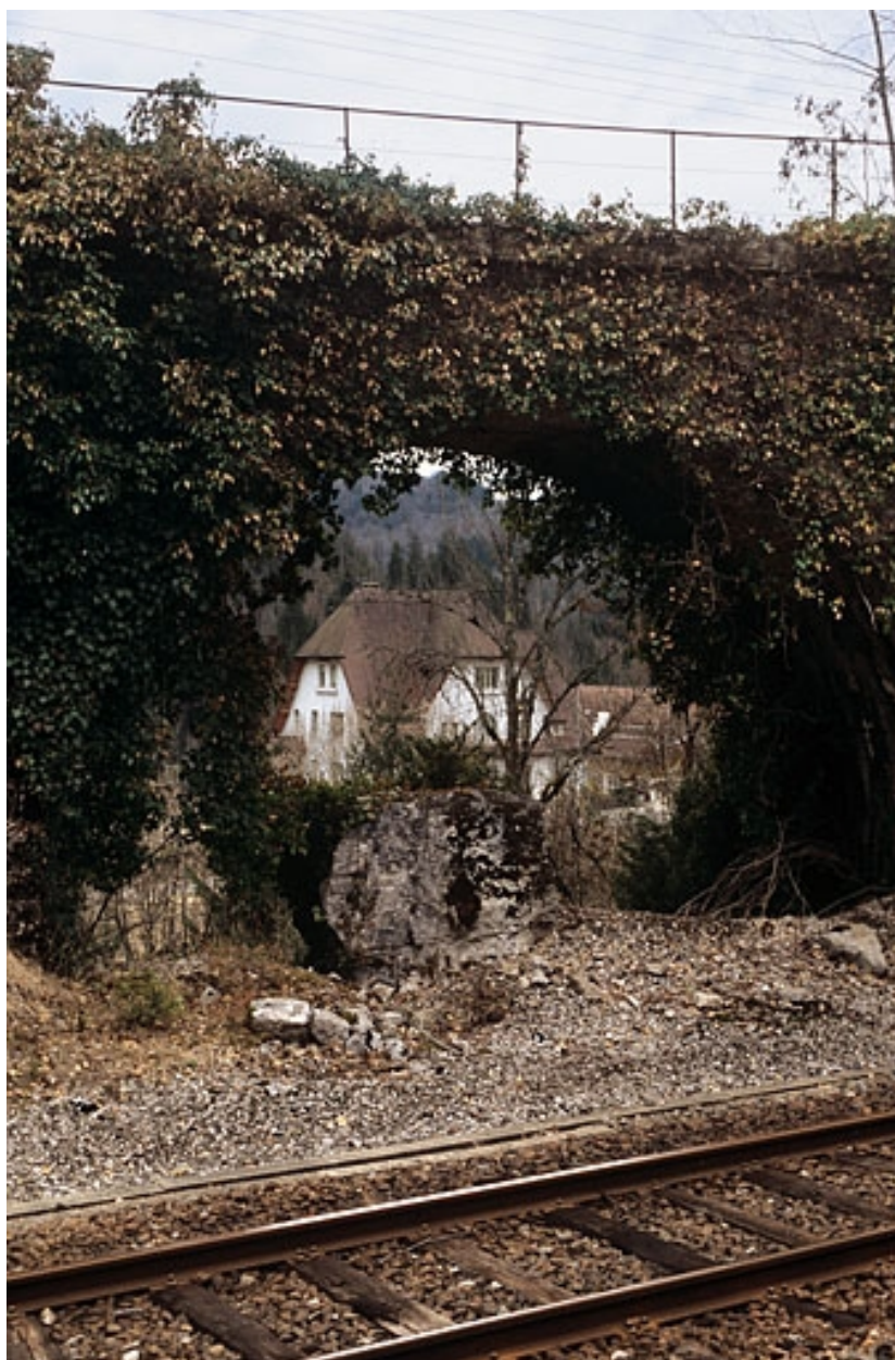
Pont du tacot : arche en plein-cintre.
