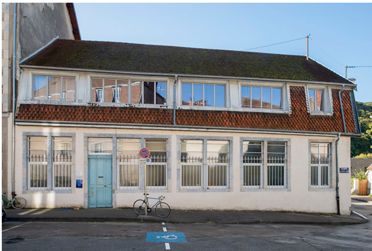
Façade nord de l'atelier.
