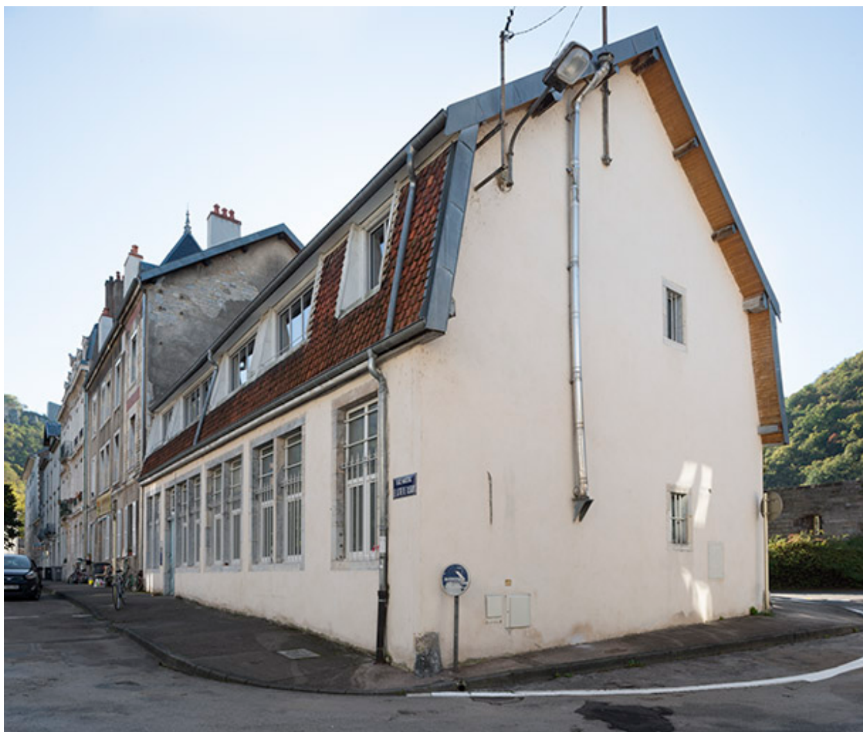
Façade et pignon ouest.
