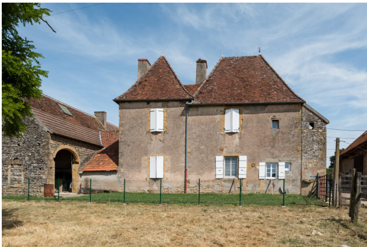
Façade postérieure de la maison
