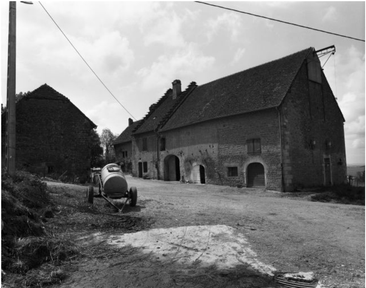
Ferme située chemin du Château : vue d'ensemble.
