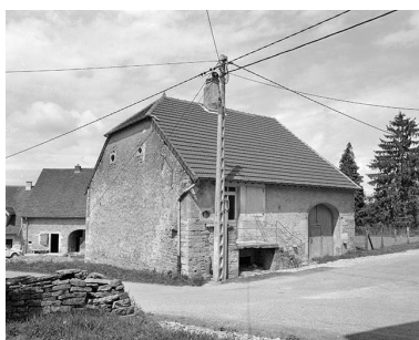
Ferme située le long du CD n° 208 du Pin à Lons-le- Saunier : vue d'ensemble. Phot. Yves Sancey IVR43_19813900231X
