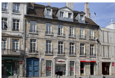
Vue d'ensemble de face depuis la rue.
