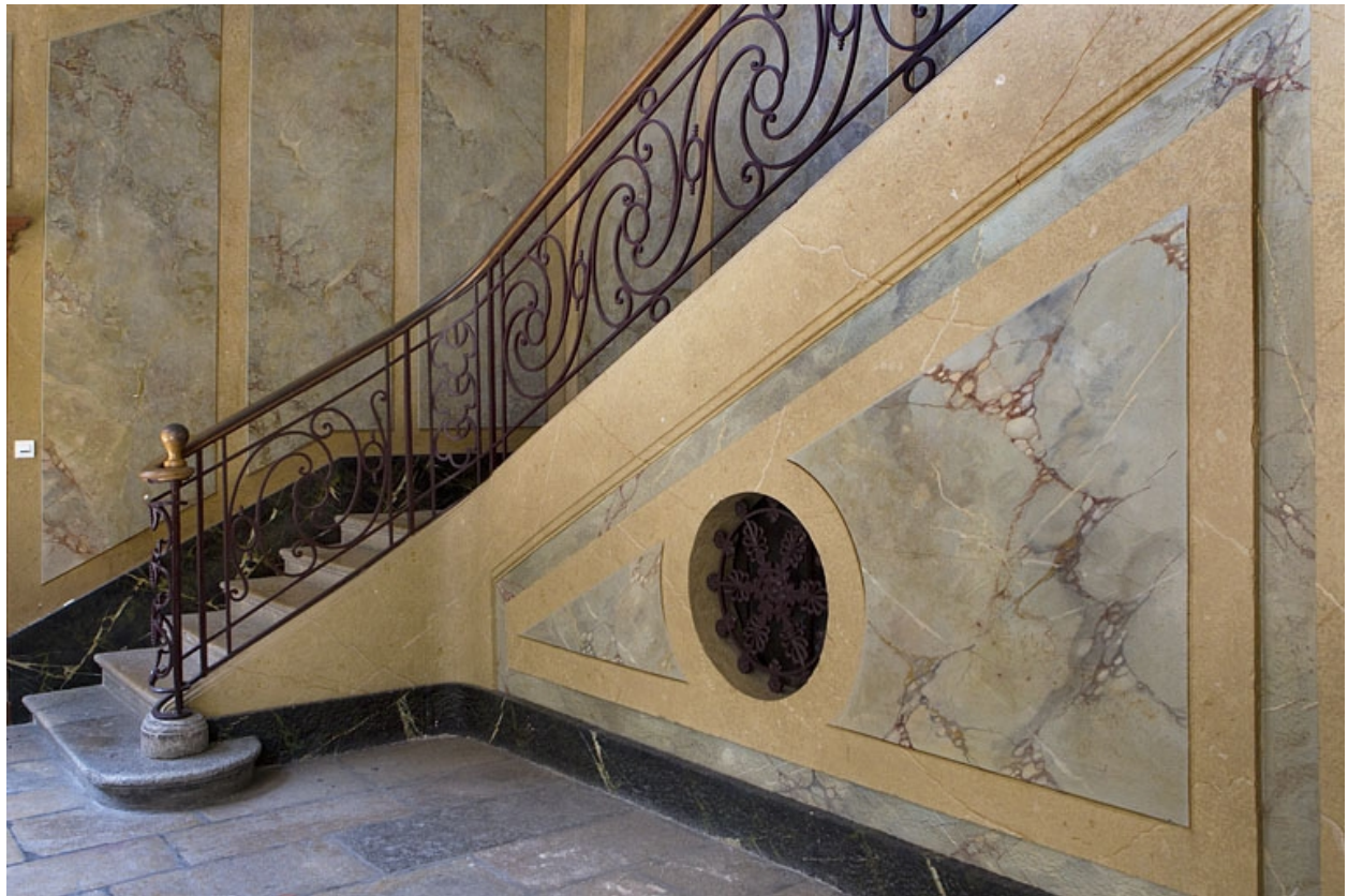
Logis principal, escalier : détail du mur d'échiffre.
