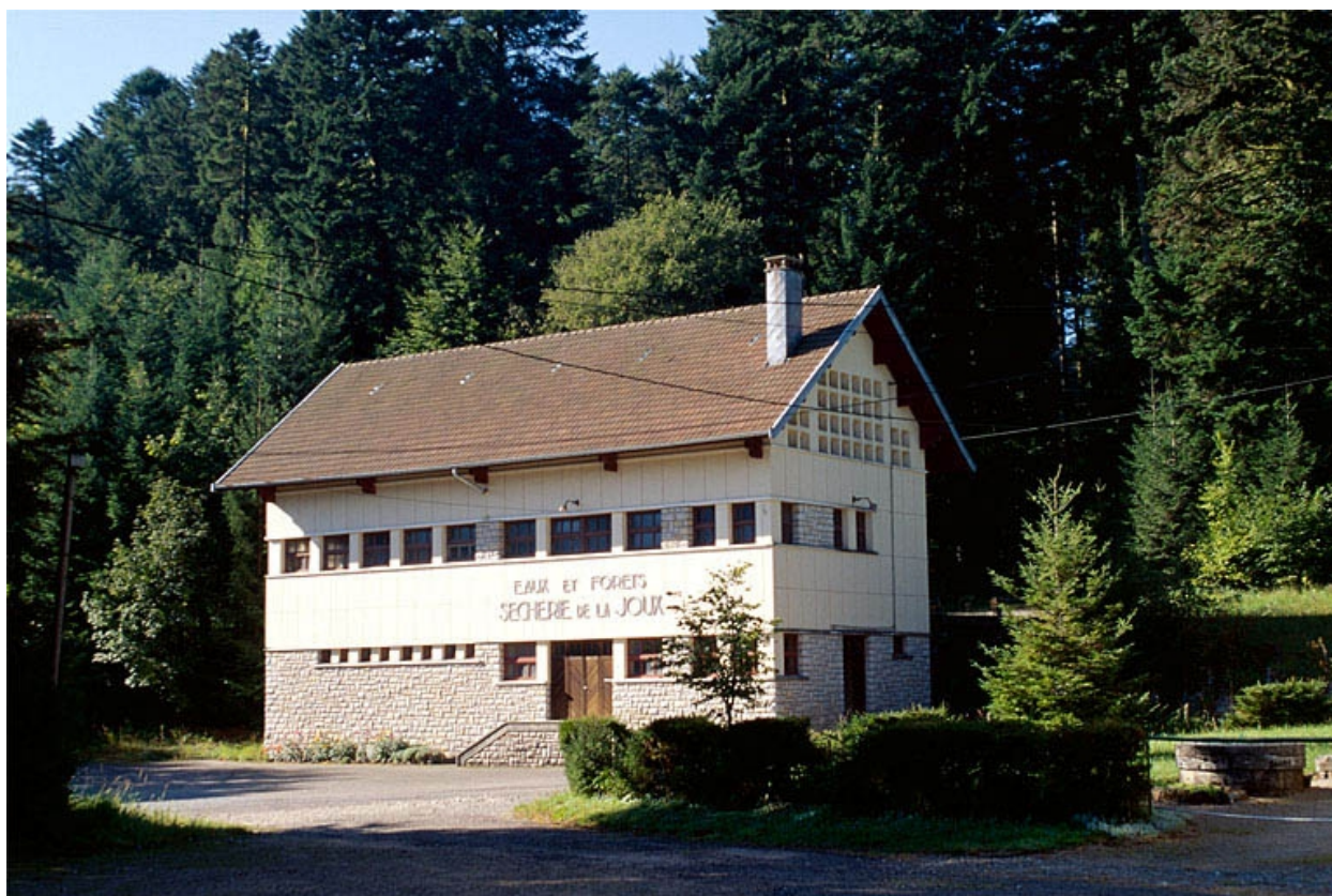
Vue d'ensemble de la sécherie résineuse.
