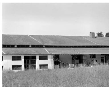
Séchoir : détail de la façade antérieure. Phot. Yves Sancey IVR43_19973901254X
