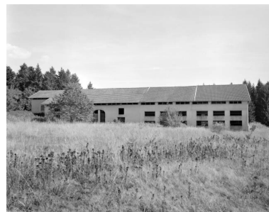
Façade postérieure du séchoir.
