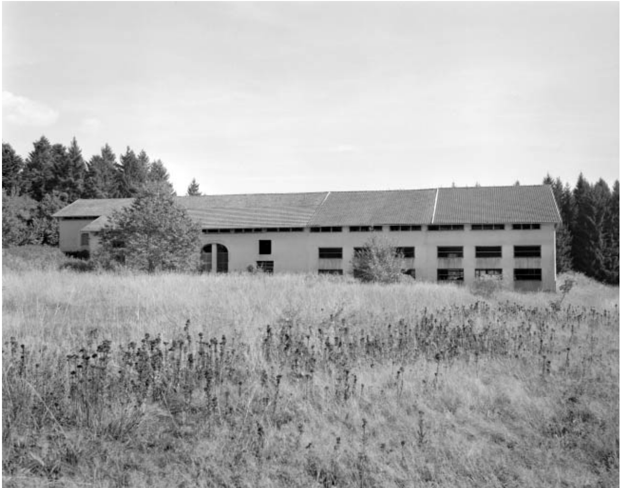
Façade postérieure du séchoir.
