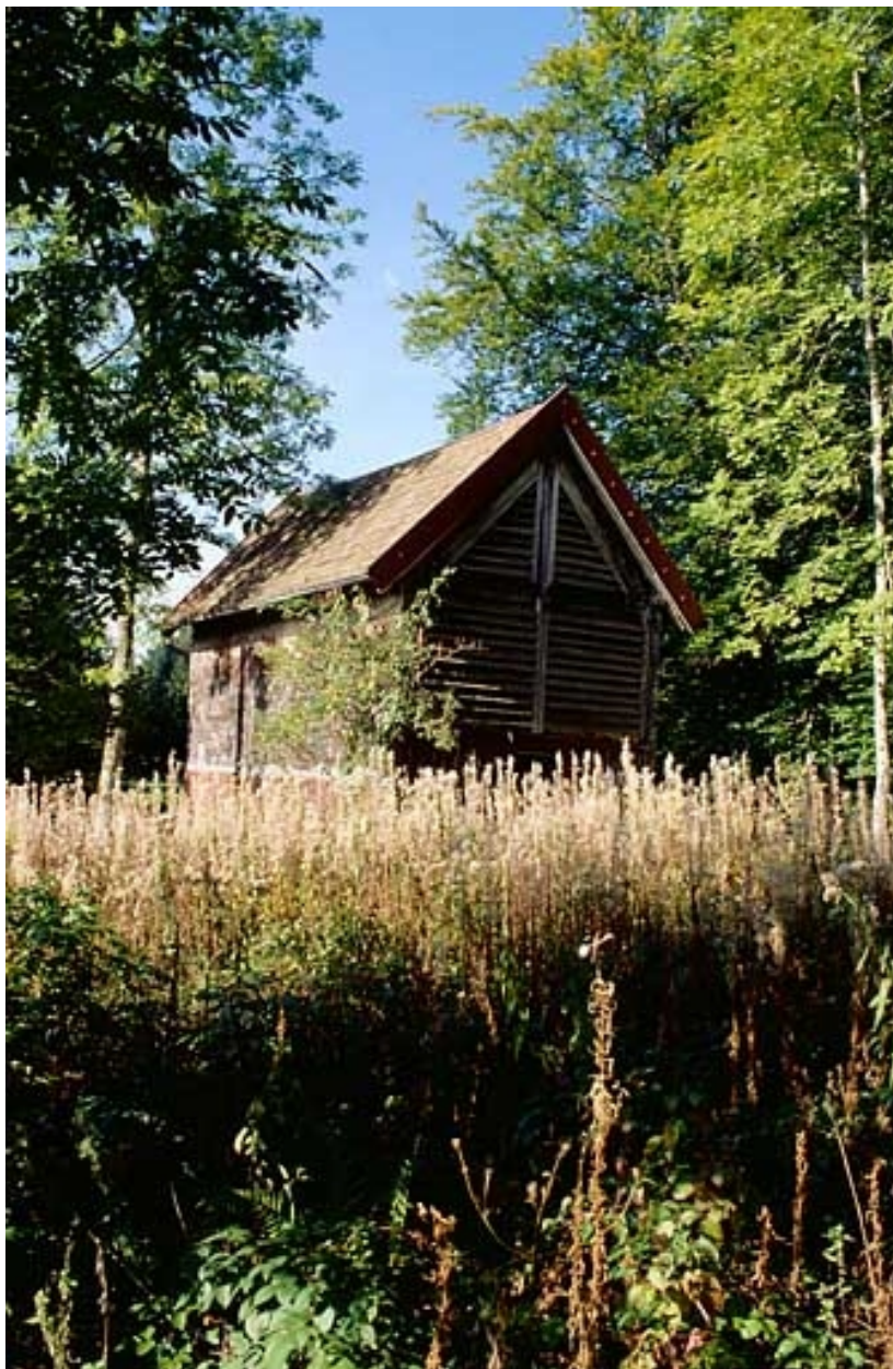
Vue de trois quarts du hangar séchoir.
