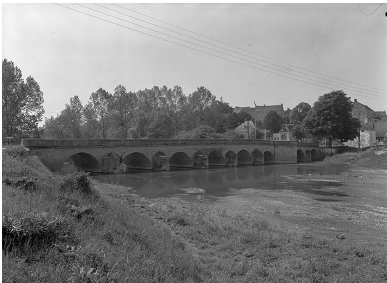
Pont sur l'Armançon (pont routier).
