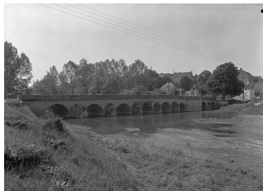
Pont sur l'Armançon (pont routier).
