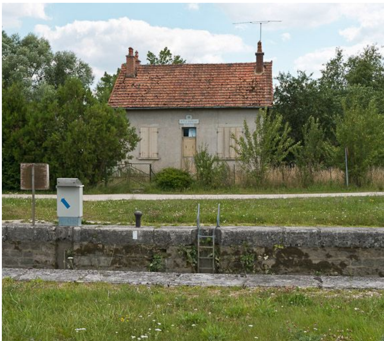
Vue de face de la maison éclusière.
