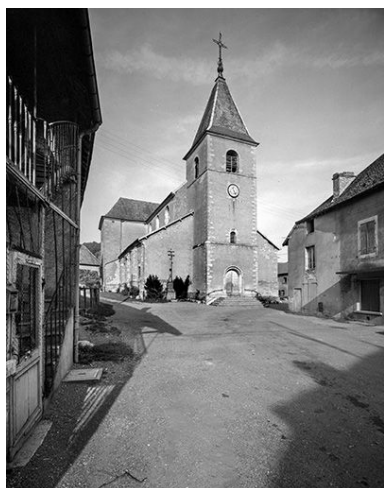
Façade antérieure. Phot. Yves Sancey IVR43_19757000241V
