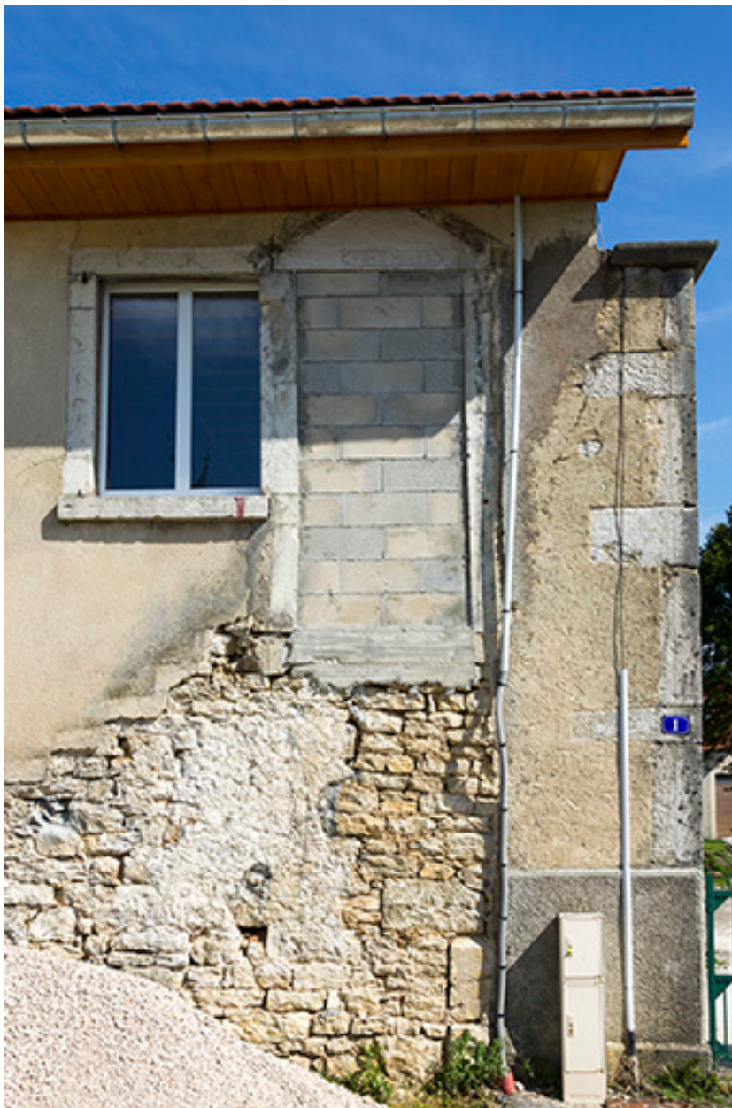
Façade latérale gauche : porte murée à l'étage.
