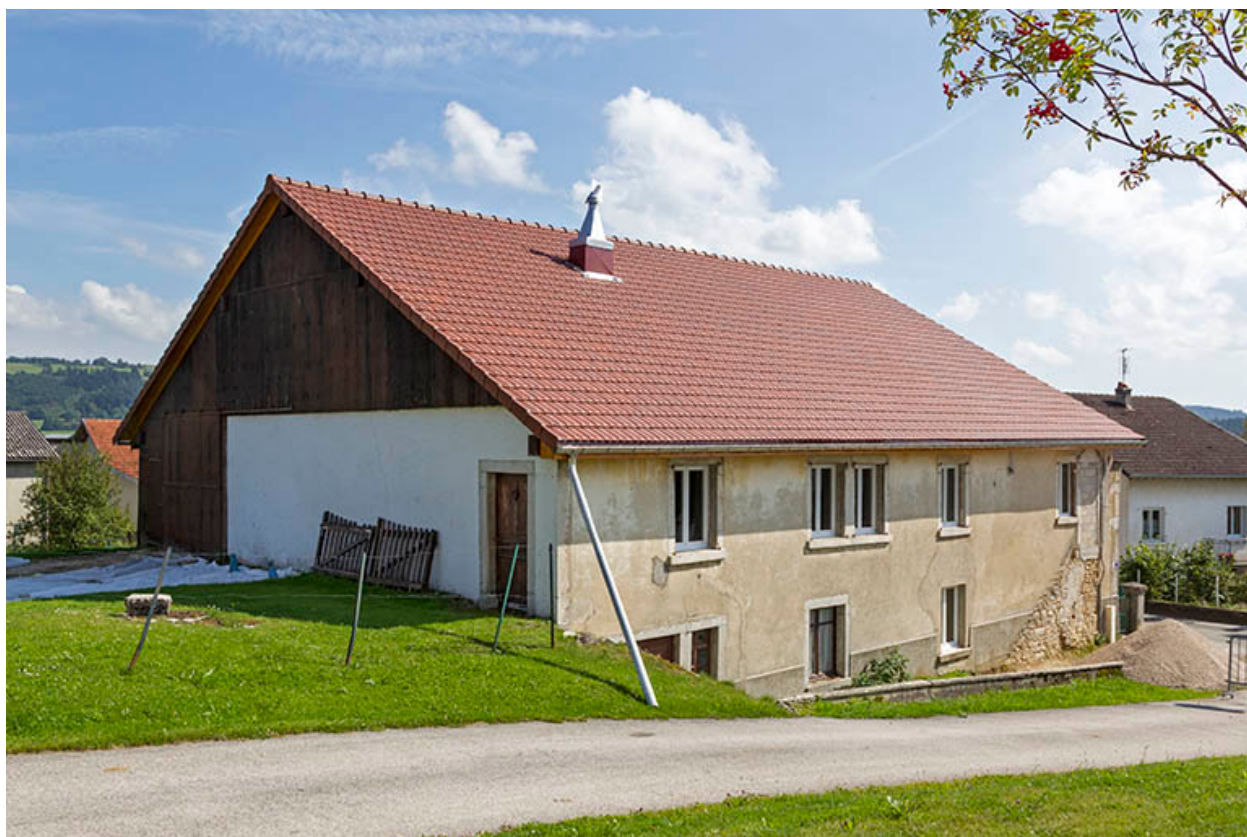
Façades postérieure et latérale gauche.
