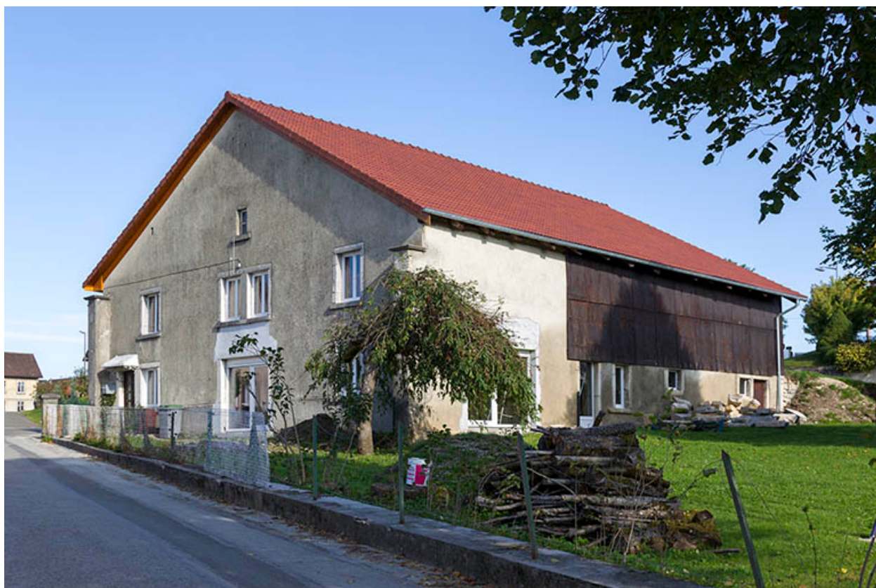
Façades antérieure et latérale droite.
