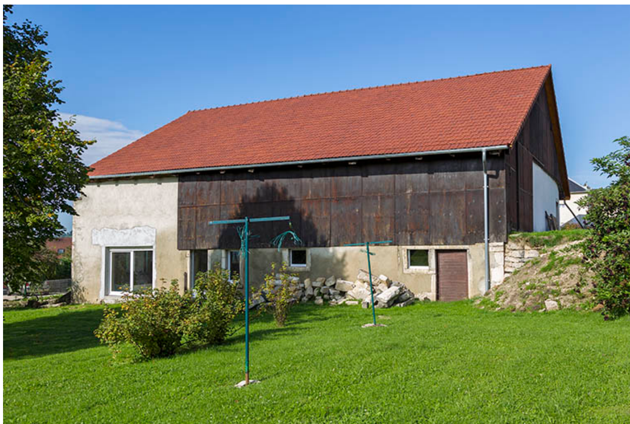
Façade latérale droite, de trois quarts droite.
