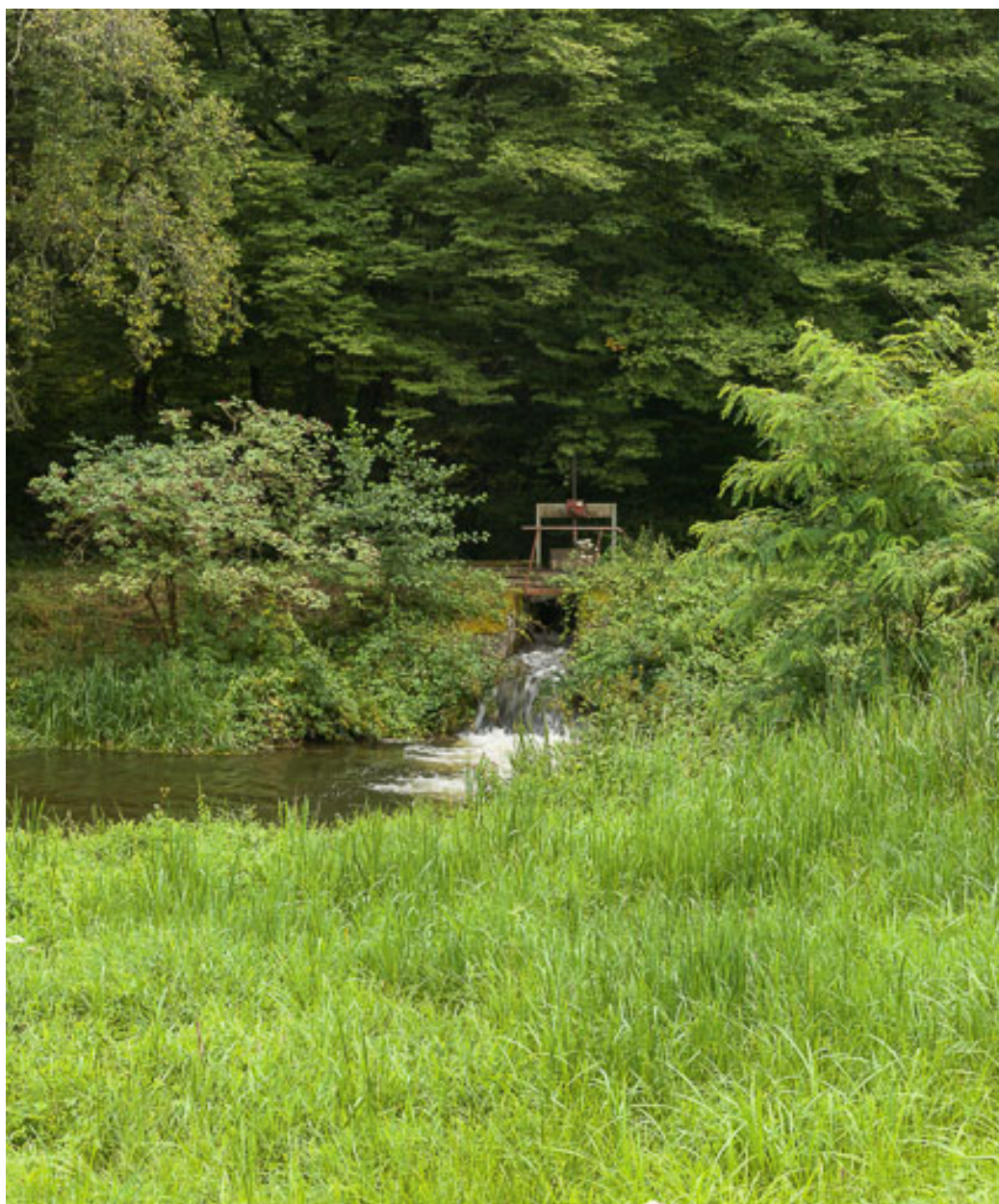
Vue des prises d'eau.
