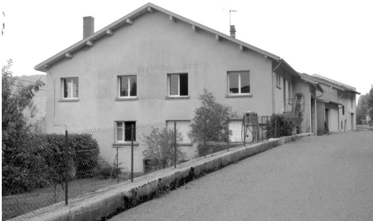
Façades latérale droite et postérieure.
