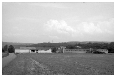
Cave d'affinage et porcherie, vues de l'ouest. Phot. Laurent Poupard IVR43_19923901274Z
