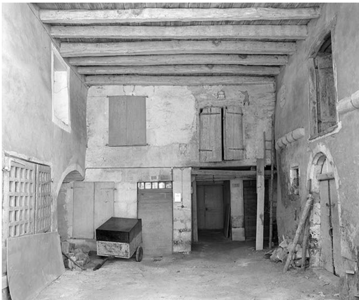
Façade antérieure : le passage plafonné.
