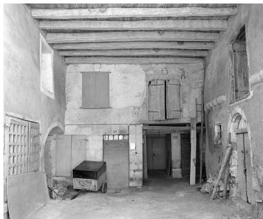
Façade antérieure : le passage plafonné. Phot. Yves Sancey IVR43_19802501089X
