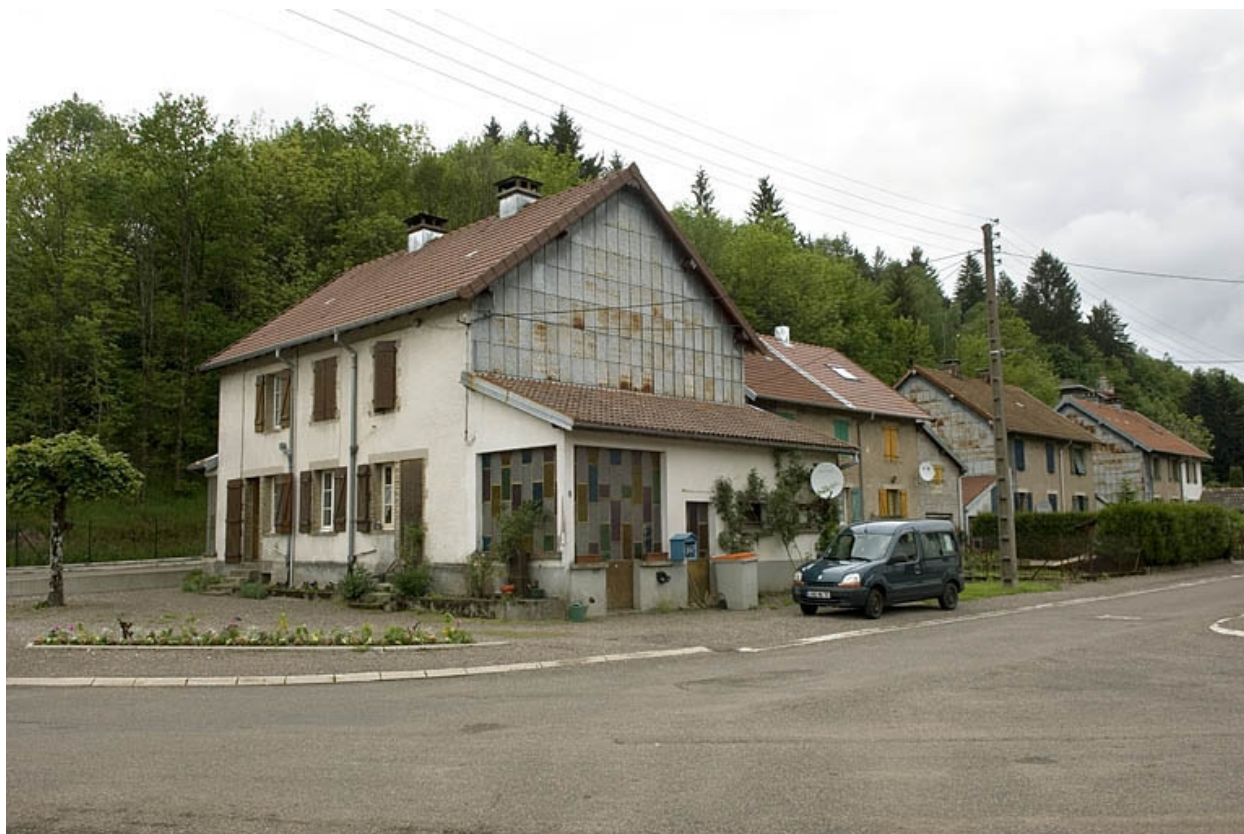
Logements ouvriers (rue des Cités).
