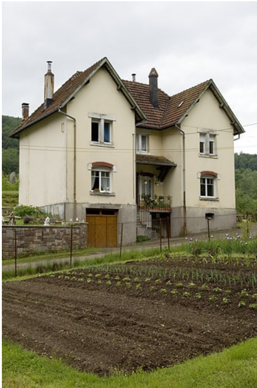
Logement patronal (rue du Barrage).
