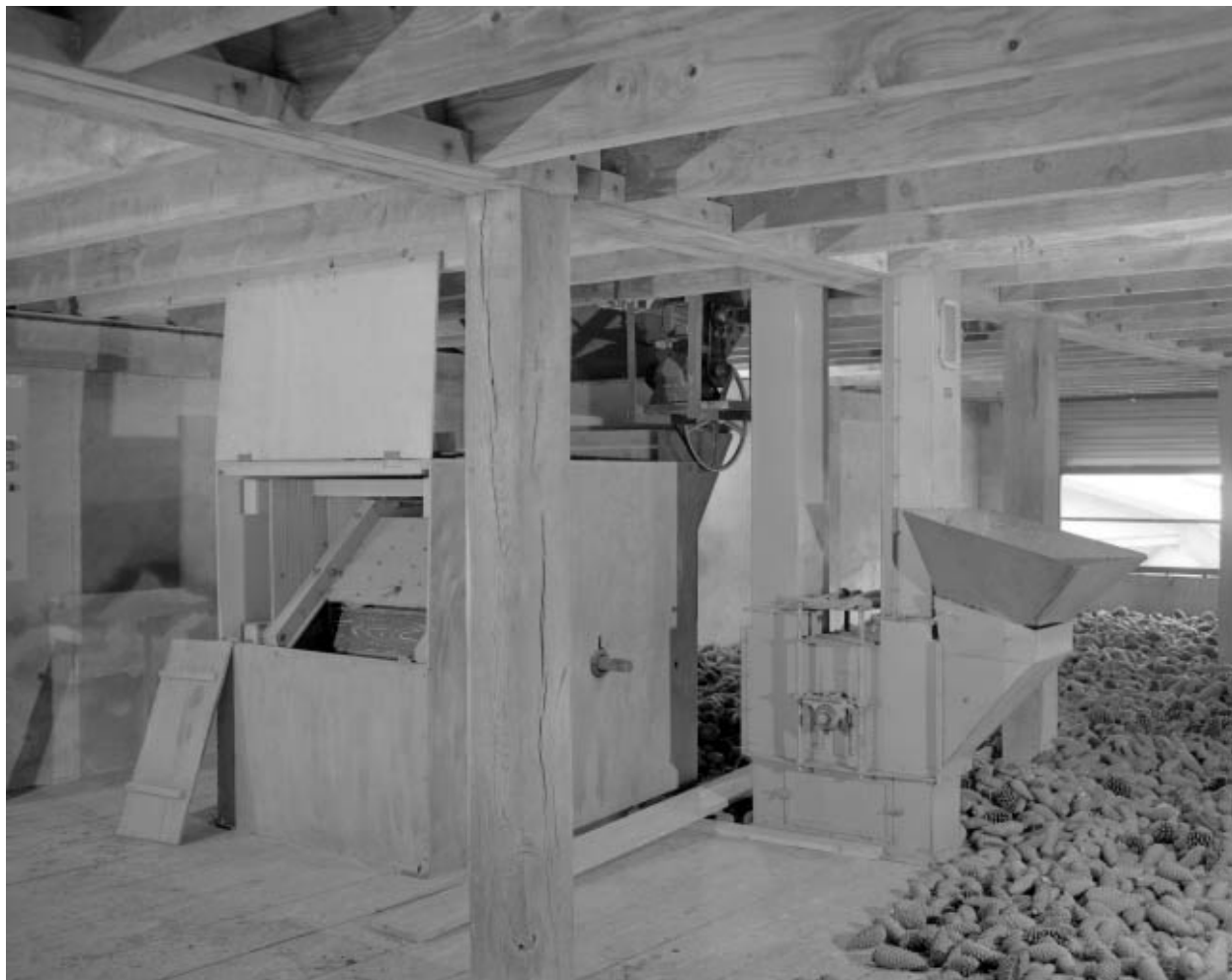
Vue d'ensemble. Batteur et élévateur à godets.
