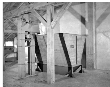
Module de chargement ou distributeur vibrant. Phot. Jérôme Mongreville IVR43_19973900297X
