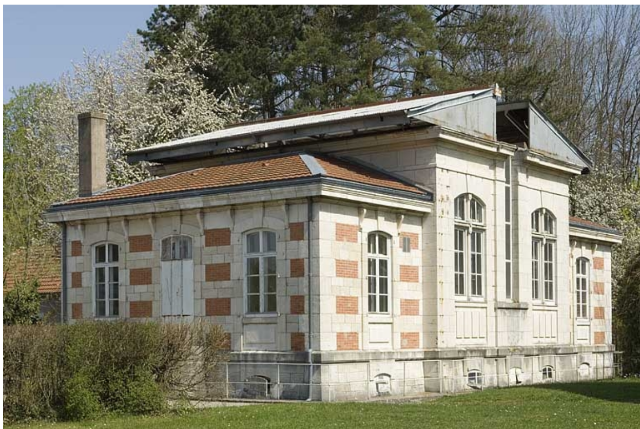
Pavillon de la méridienne, toiture ouverte.
