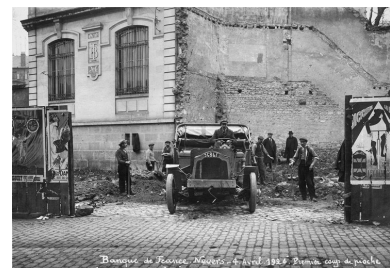
Chantier de construction (4 avril 1924).
