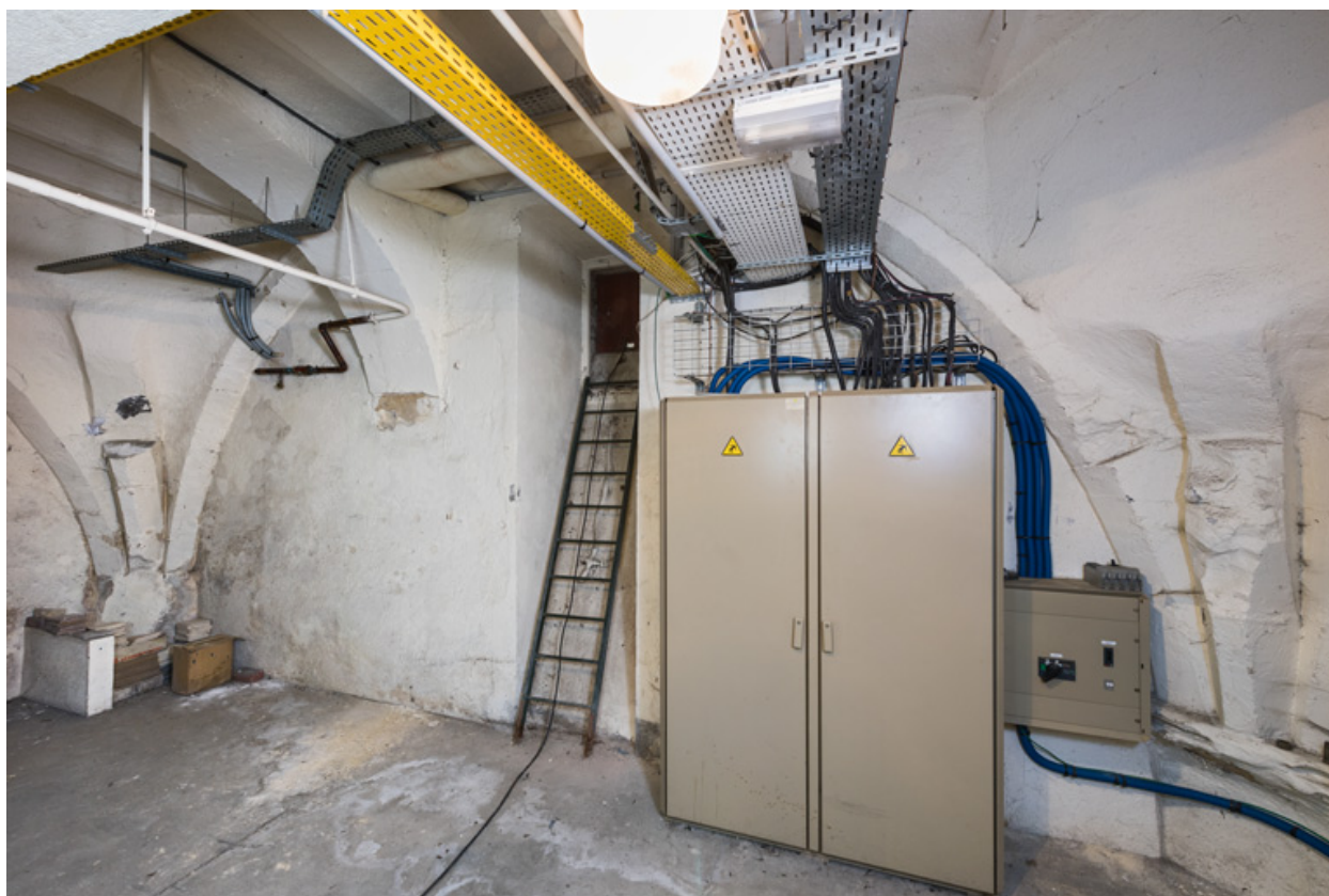
Salle du sous-sol, vestige d'une voûte.
