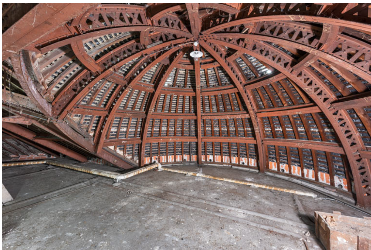
Charpente métallique.
