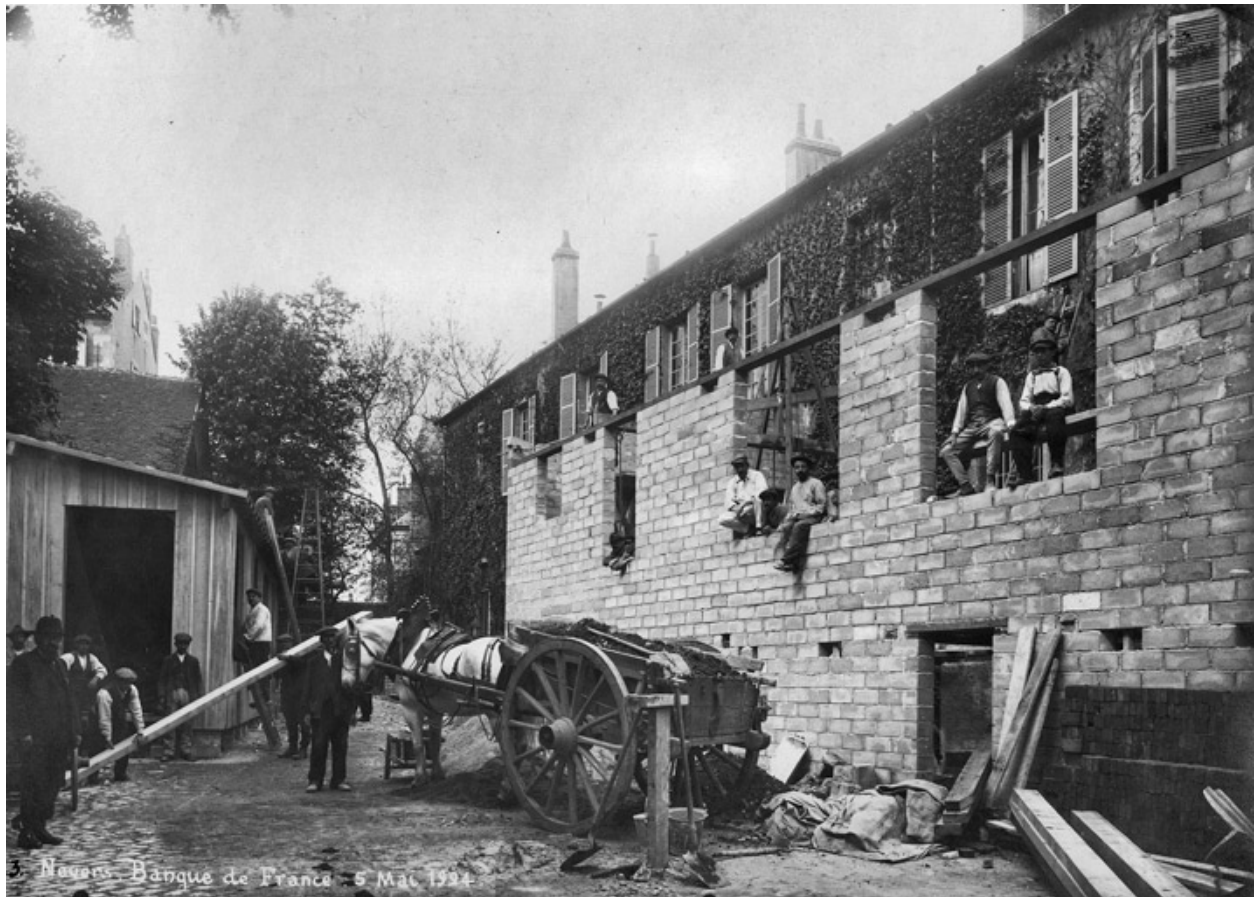
Chantier de construction (5 mai 1924).
