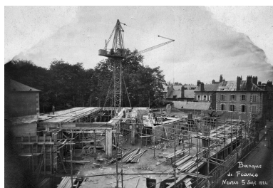
Chantier de construction (5 septembre 1924).
