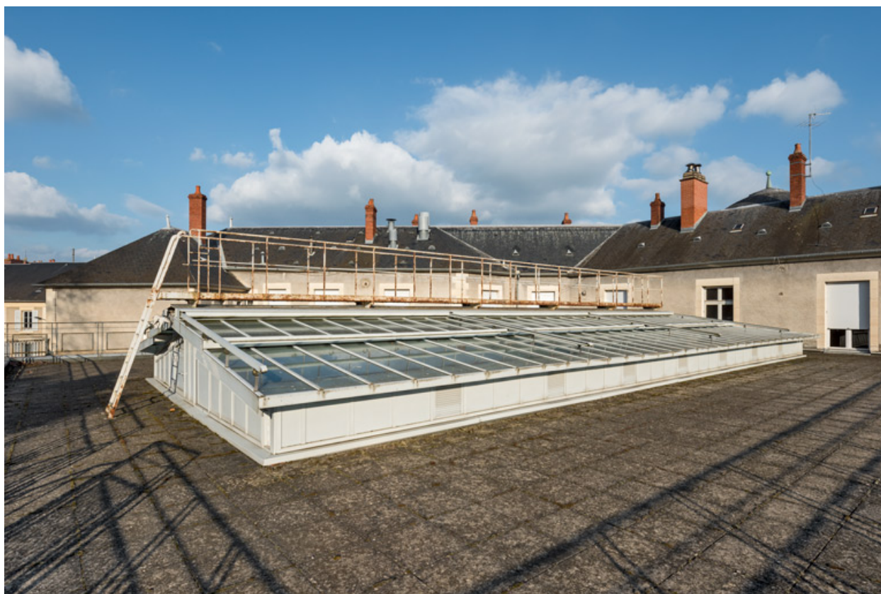
Verrière en toiture du hall du public.
