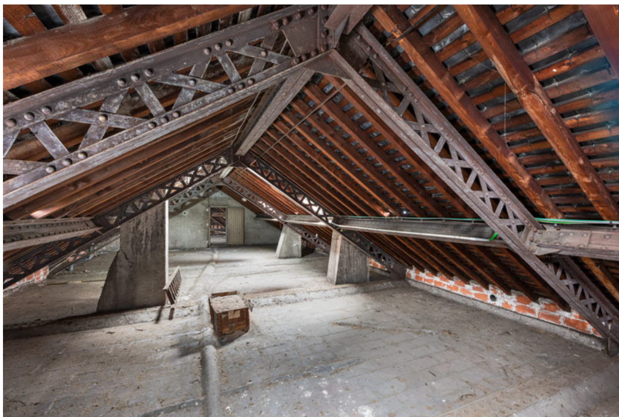
Charpente métallique.
