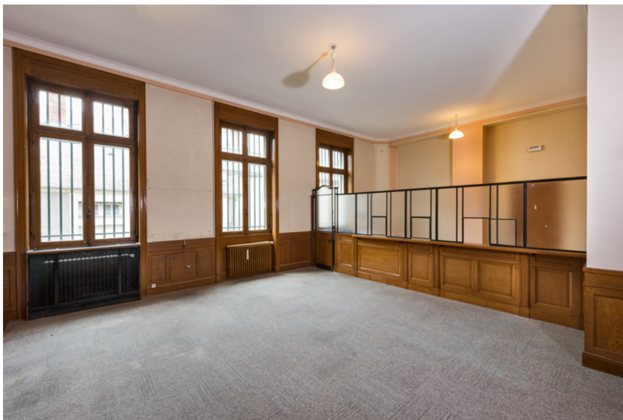
Rez-de-chaussée, salle de tri-vérification.
