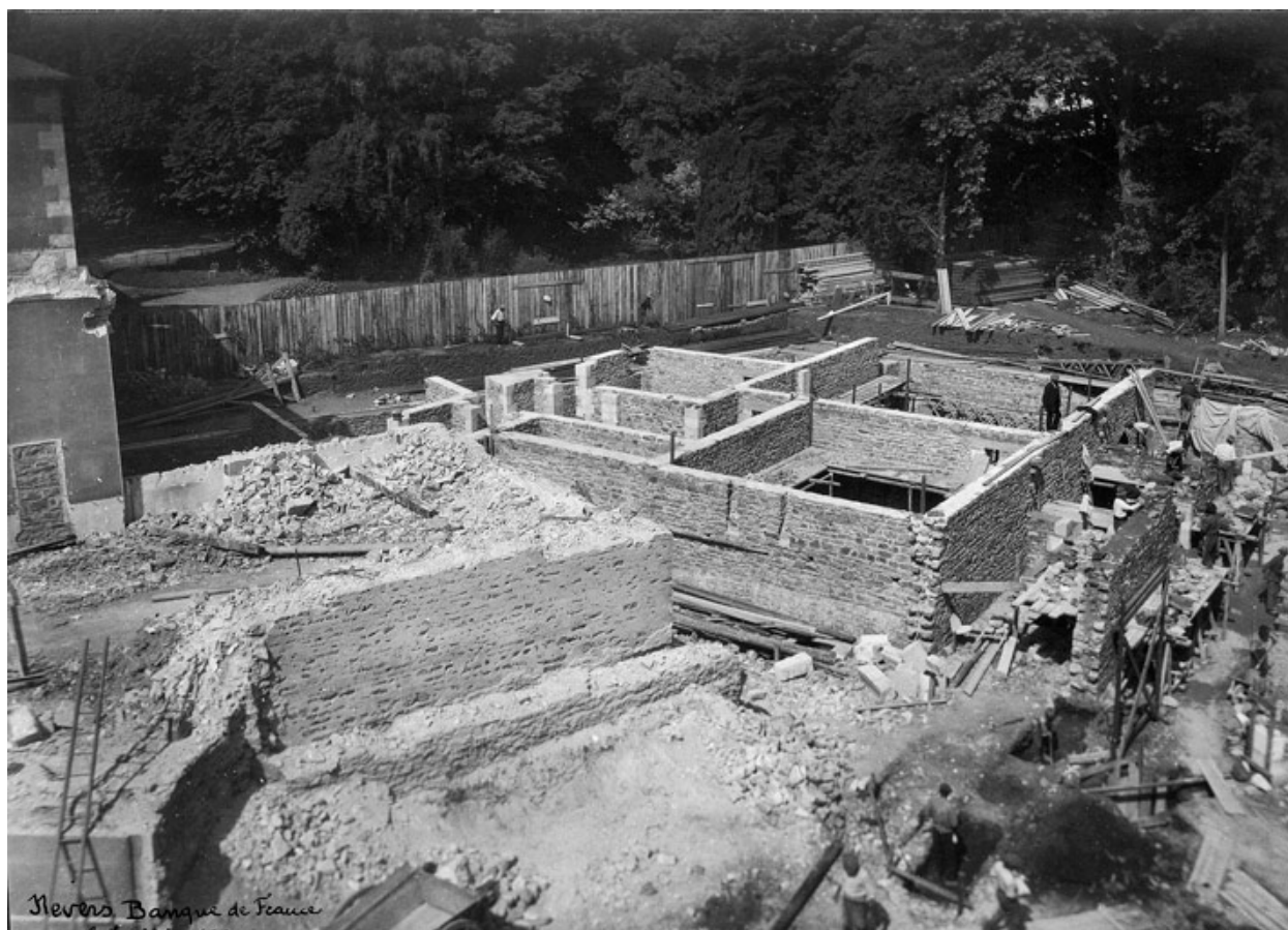
Chantier de construction (8 juin 1924).
