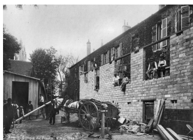
Chantier de construction (5 mai 1924).
