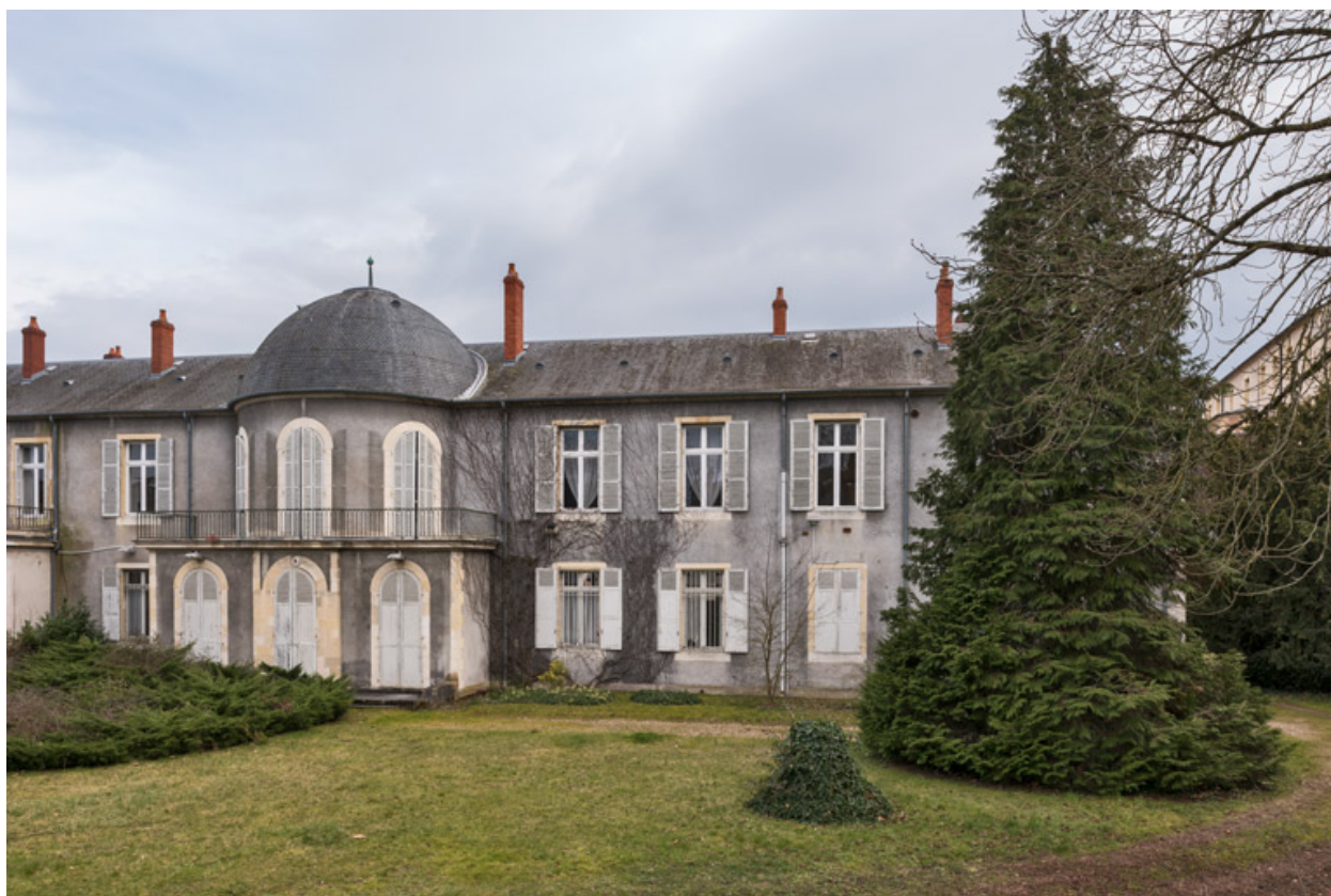
Façade sur le jardin, partie ouest.
