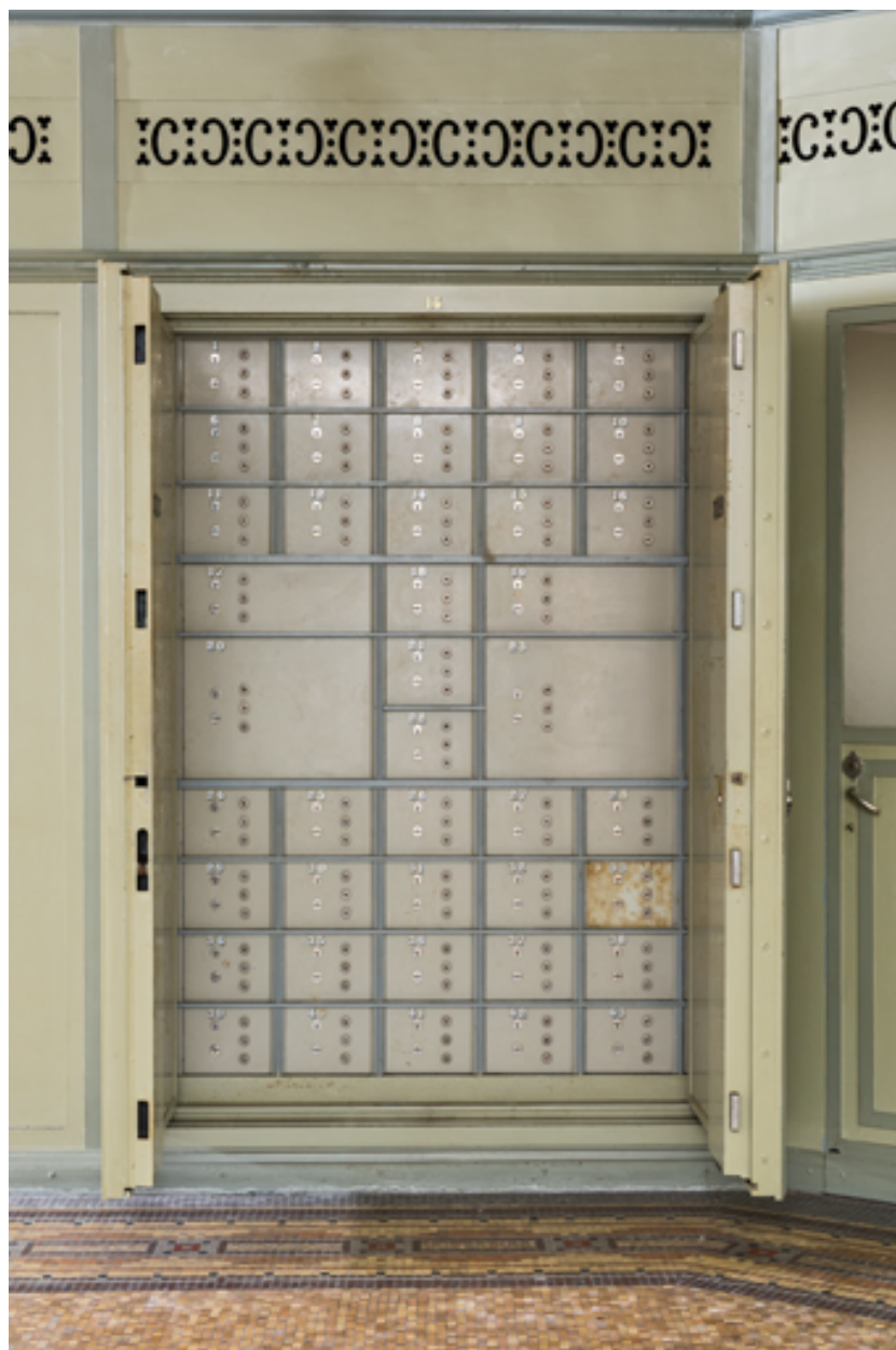
Sous-sol, salle des coffres, armoire coffre-fort.
