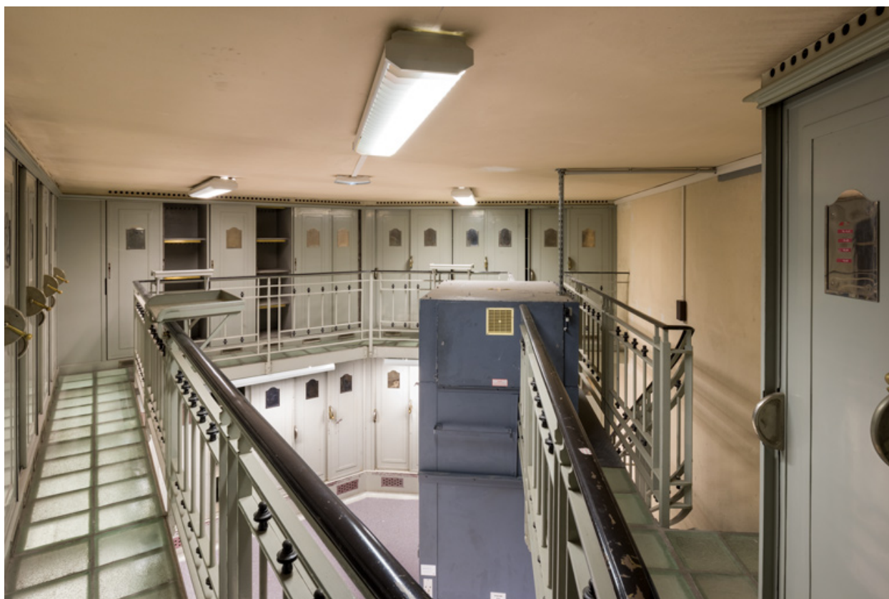
Rez-de-chaussée, caisse auxiliaire, galerie.
