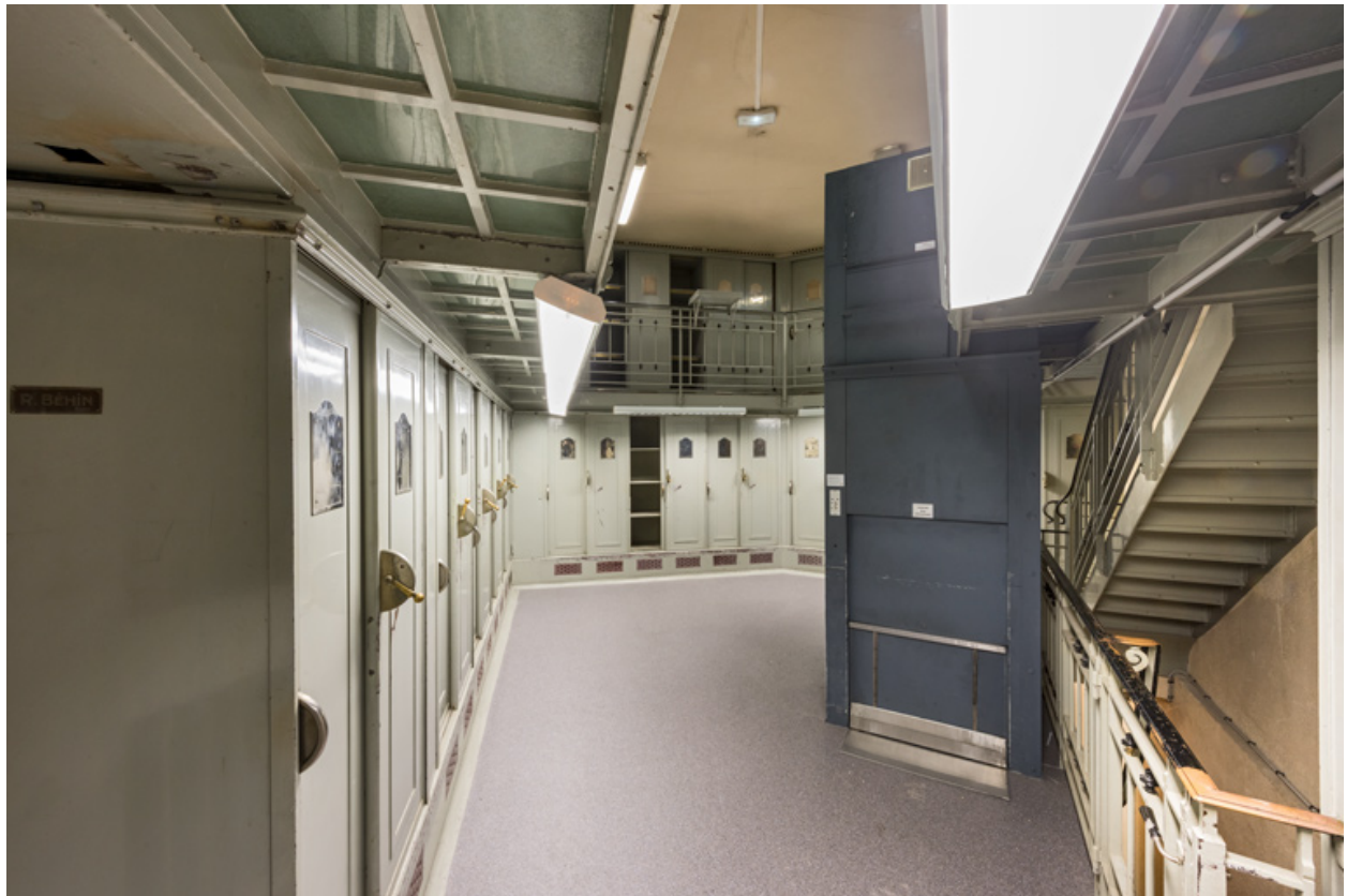
Rez-de-chaussée, caisse auxiliaire.
