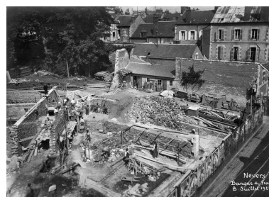
Chantier de construction (8 juillet 1924).
