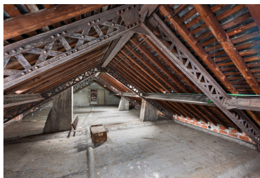
Charpente métallique. Phot. Pierre-Marie Barbe-Richaud IVR26_20235800040NUC4A
