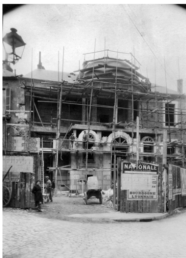
Chantier de construction (vers 1925).
