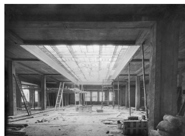
Chantier de construction (vers 1925).
