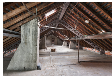
Charpente métallique. Phot. Pierre-Marie Barbe-Richaud IVR26_20235800039NUC4A
