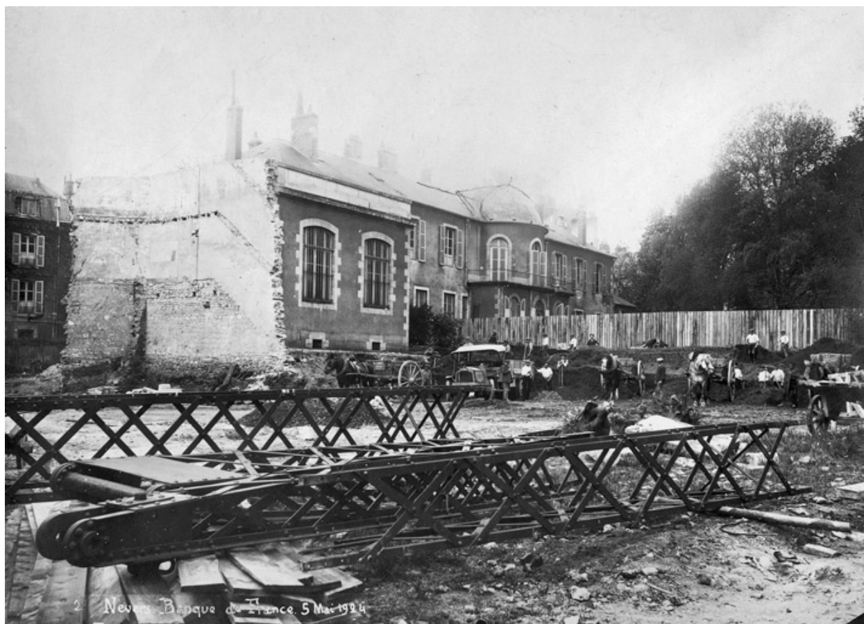
Chantier de construction (5 mai 1924).
