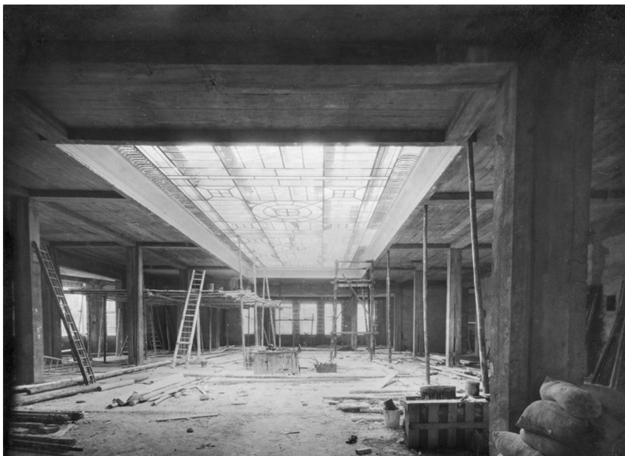
Chantier de construction (vers 1925).
