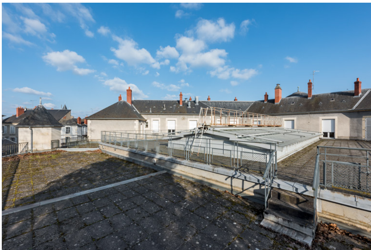
Verrière en toiture du hall du public.
