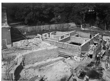
Chantier de construction (8 juin 1924).
