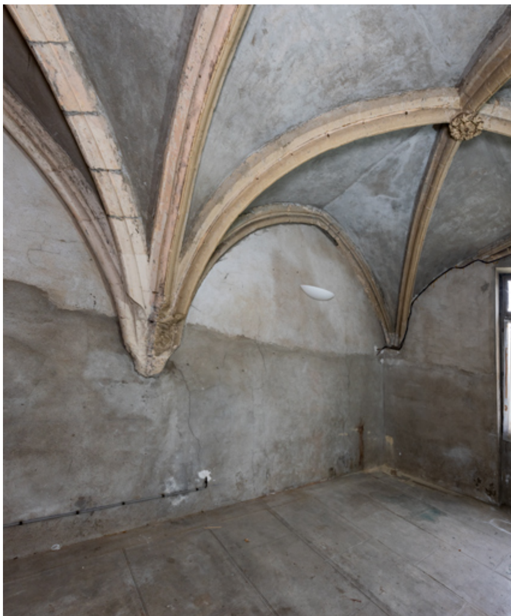
Salle du sous-sol couverte de croisées d'ogives.
