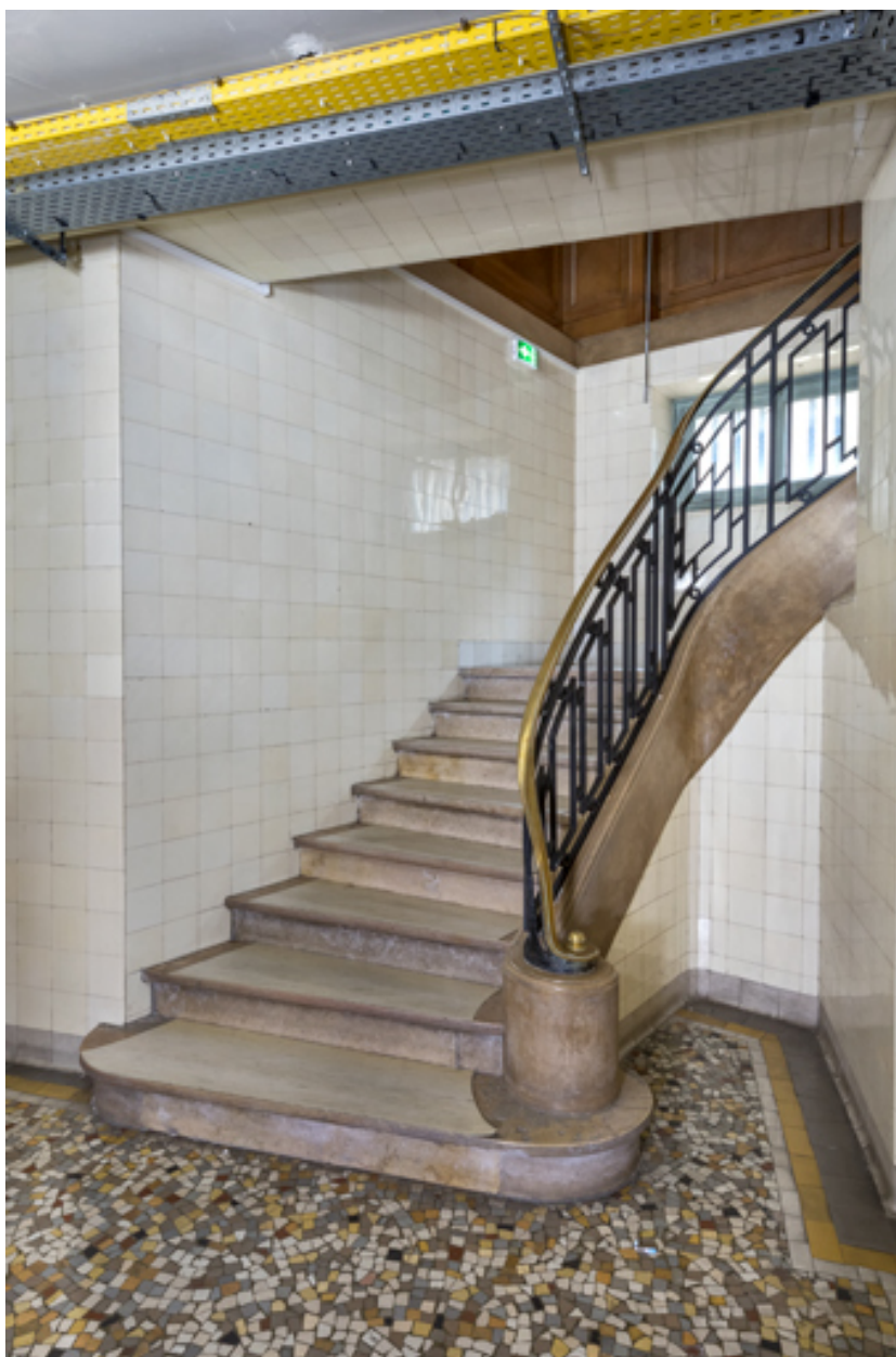
Escalier d'accès au vestiaire (au sous-sol).
