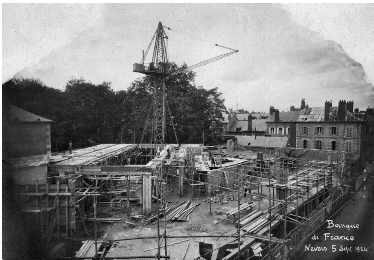
Chantier de construction (5 septembre 1924).
