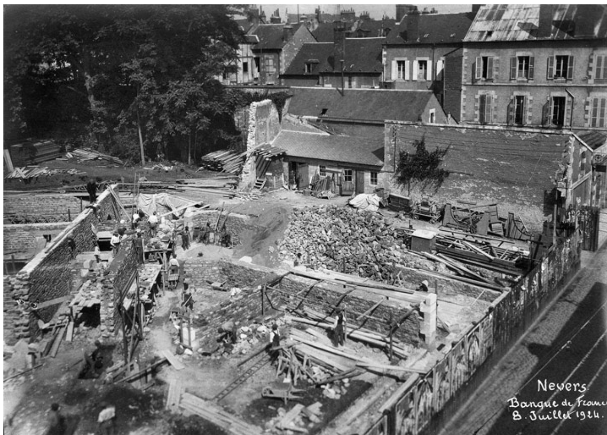
Chantier de construction (8 juillet 1924).
