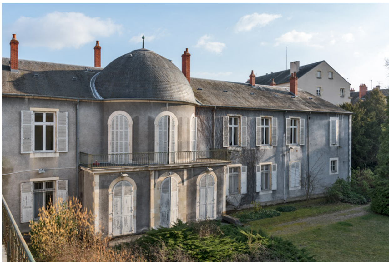
Façade sur le jardin, partie ouest.
