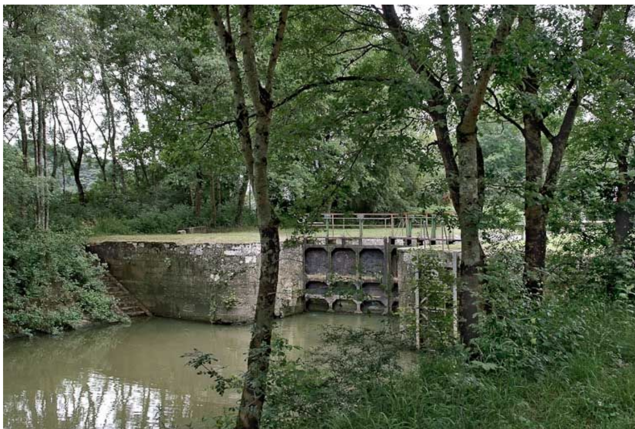
La tête aval de l'écluse.
