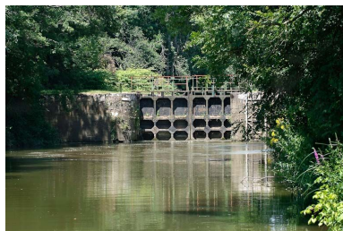
Le sas de l'écluse, vu d'aval. Phot. Jean-Luc Duthu IVR26_20107100382NUC2A
