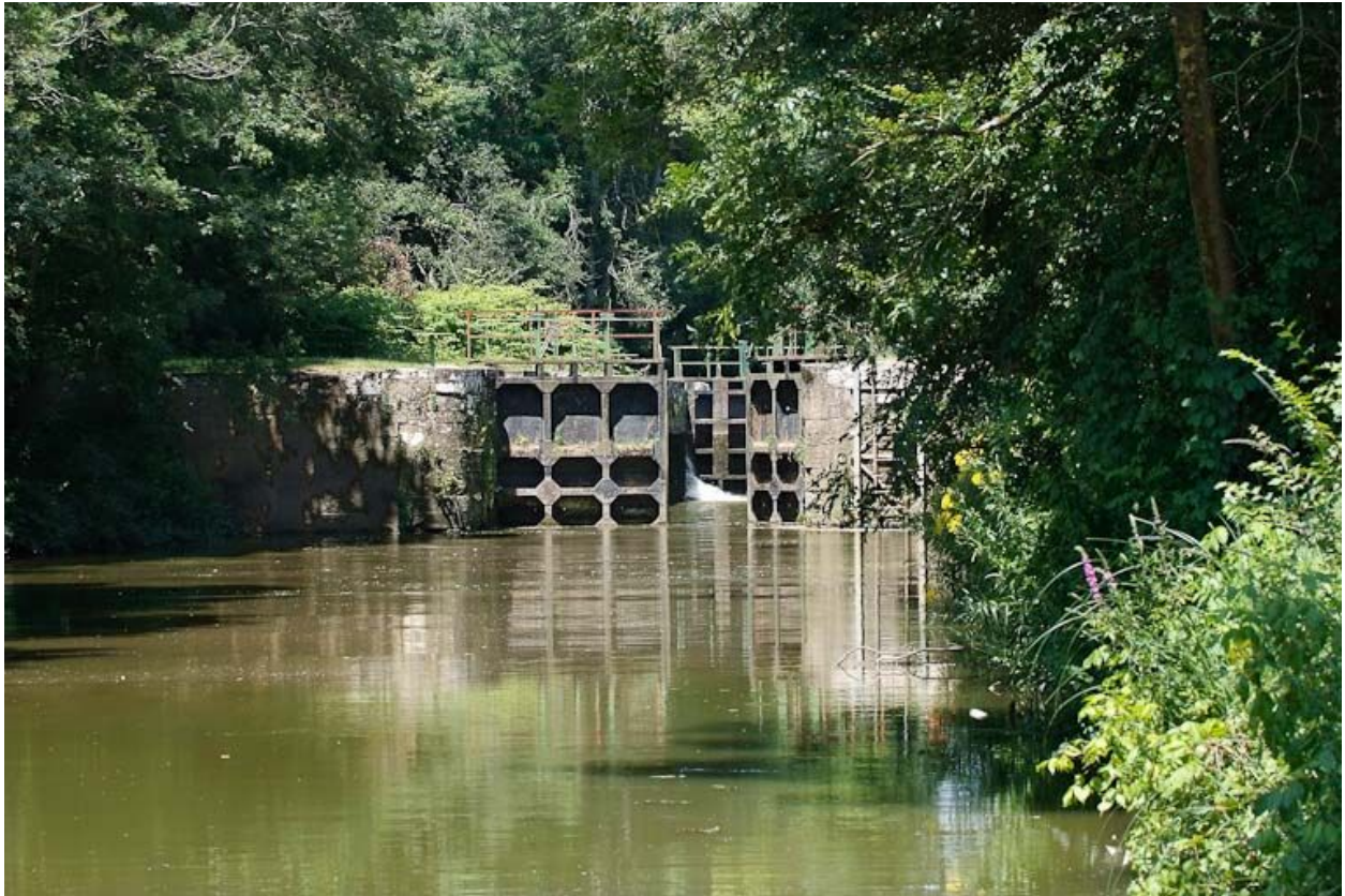
Le sas de l'écluse, vu d'aval.
