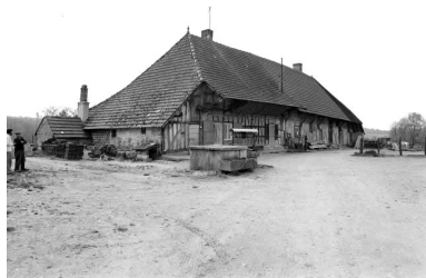
Bâtiment d'habitation : vue d'ensemble. Phot. Bernard Lardière IVR43_19793900302X
