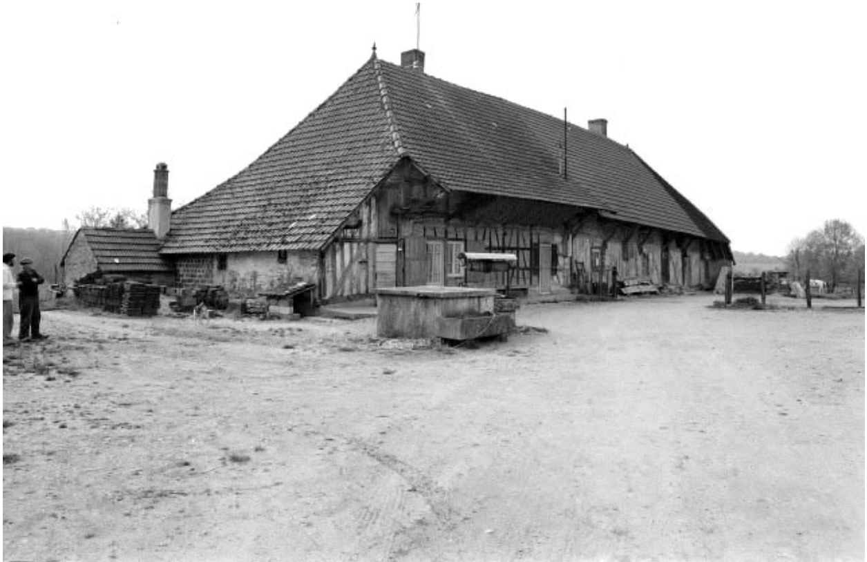
Bâtiment d'habitation : vue d'ensemble.
