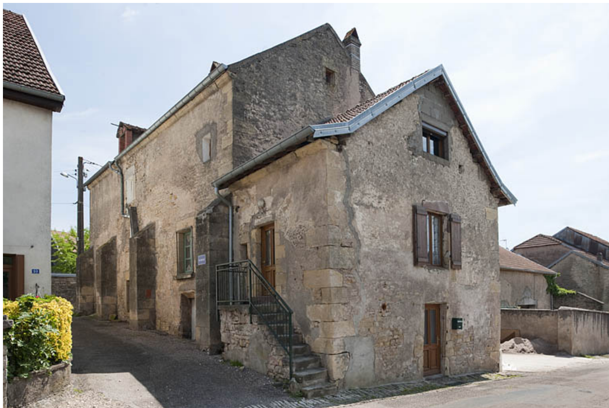
Vue générale depuis la rue Catinat.
