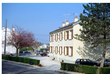
Immeubles semblables, 32 rue des Verneaux. Phot. Laurent Poupard IVR43_19893900567ZA
