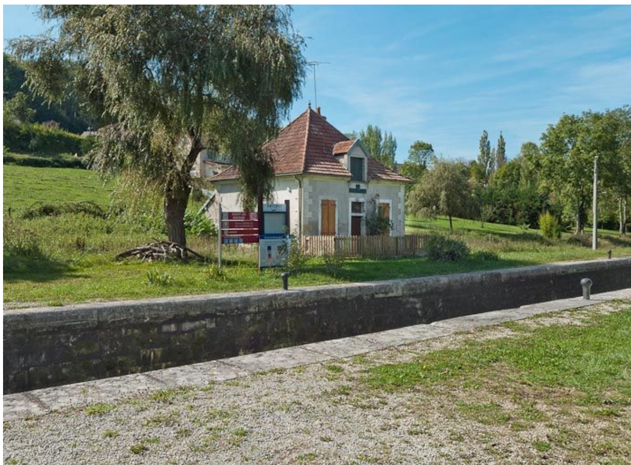
Vue d'ensemble du site d'écluse.
