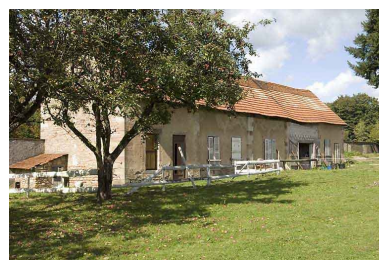
Logement ouest et parties agricoles. Phot. Jérôme Mongreville IVR43_20077000508NUCA
