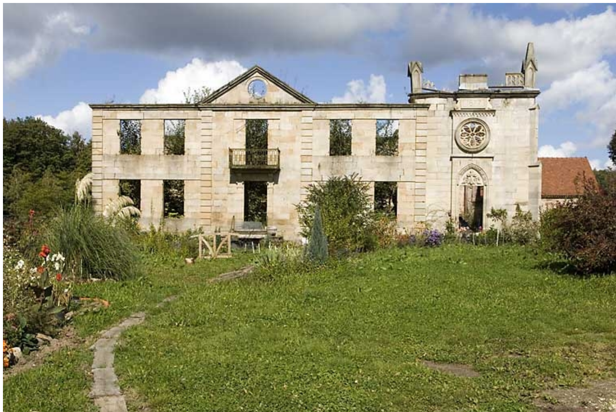
Logement patronal et chapelle. Façade antérieure.
