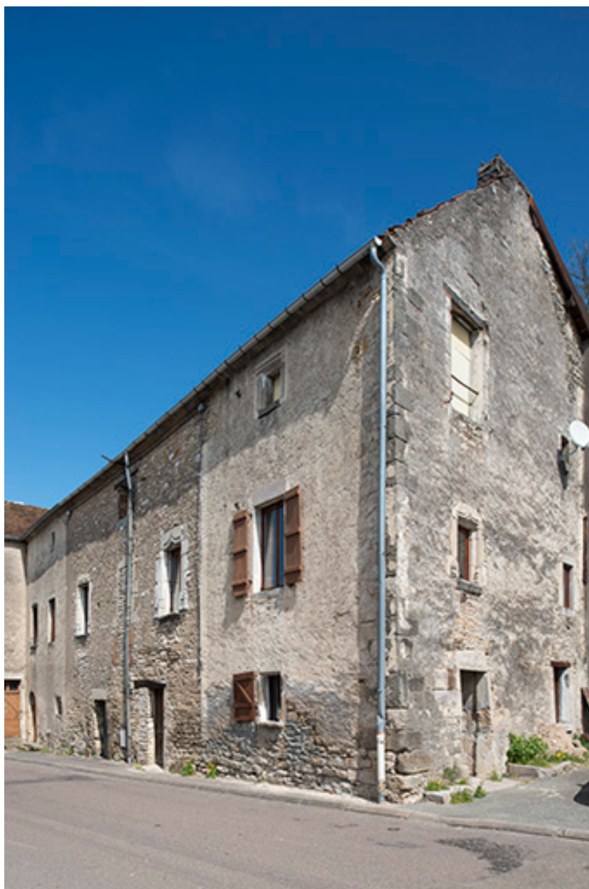
Vue de détail sur les ouvertures.
