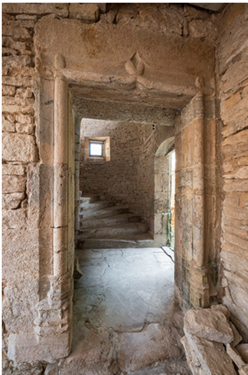
La porte d'accès à la tour, rez-de-chaussée.
