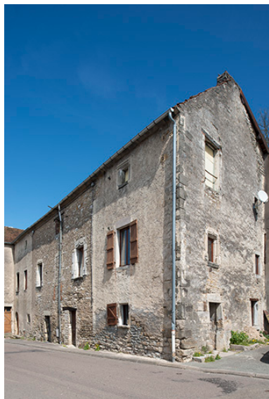
Vue de détail sur les ouvertures. Phot. Jérôme Mongreville IVR43_20177000716NUC4A
