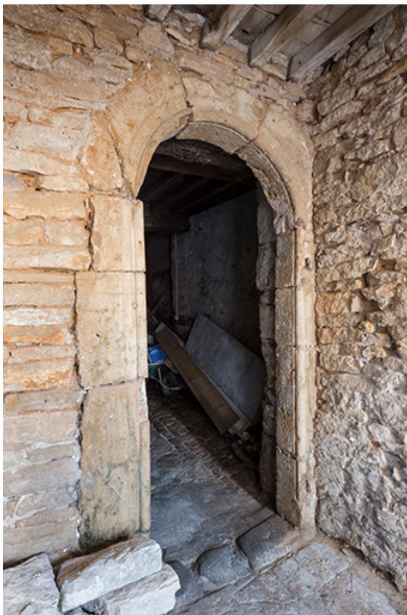
Porte d'accès à la grange, rez-de-chaussée.
