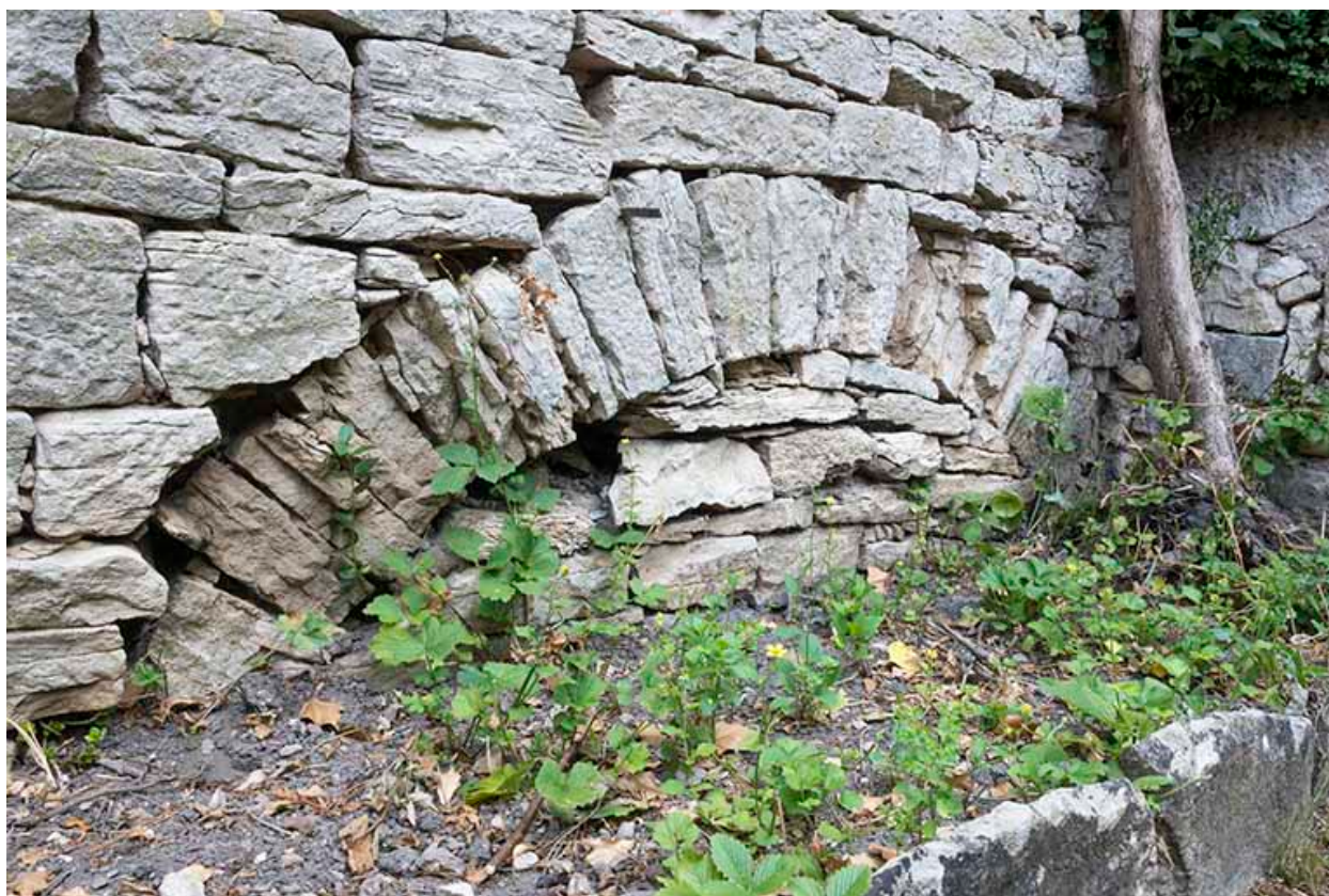
Détail de la maçonnerie d'une voûte.
