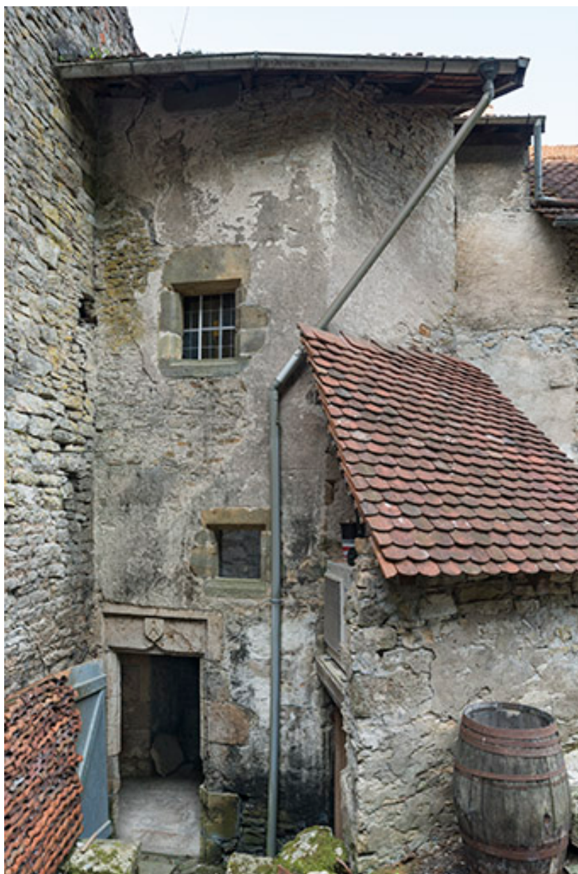
Tour comprenant l'escalier, côté cour.
