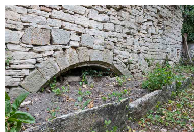
Voûte de l'ancienne galerie du cloître (?). Phot. Jérôme Mongreville IVR43_20177000835NUC4A
