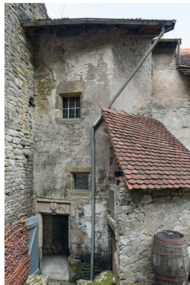
Tour comprenant l'escalier, côté cour. Phot. Jérôme Mongreville IVR43_20177000833NUC4A
