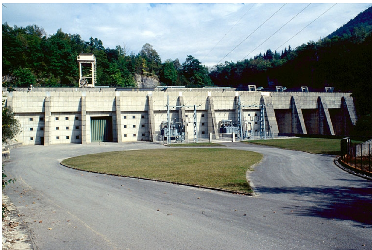
Centrale hydroélectrique du Saut-Mortier, Cernon.
