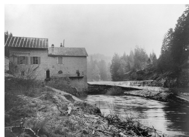
[Centrale hydroélectrique de la Roche] Vue générale, 1950-1951. Phot. Yves Sancey, Autr. R. Ponget IVR43_19883900720V
