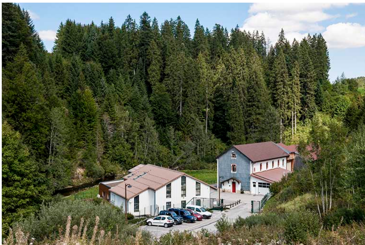
Centrale du Fourpéret, Labergement-Sainte-Marie.
