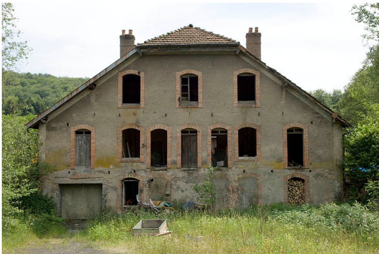
Mine de houille du puits du Magny, Magny-d'Anigon : bâtiment industriel.
