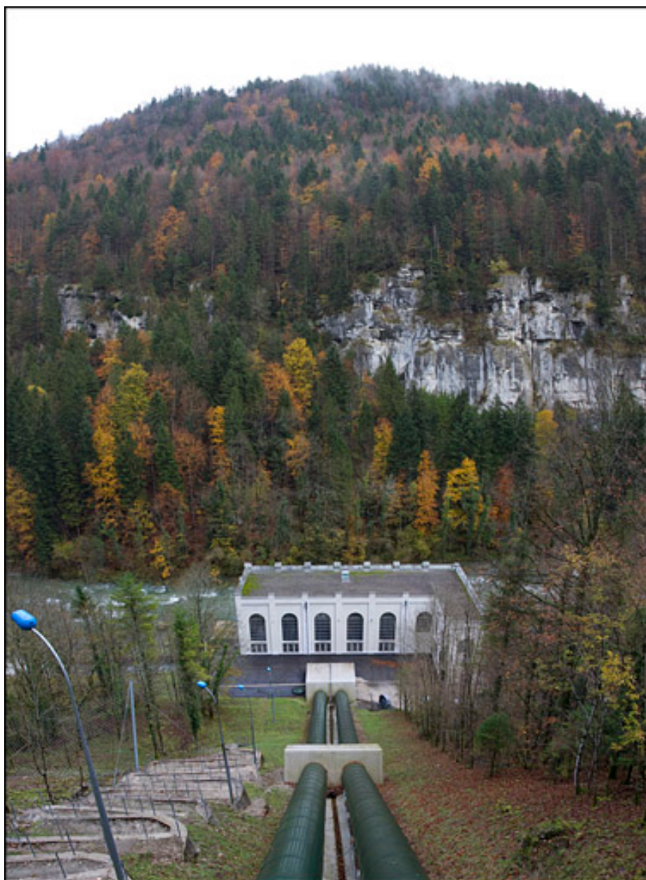
Centrale hydroélectrique du Refrain, Charquemont.
