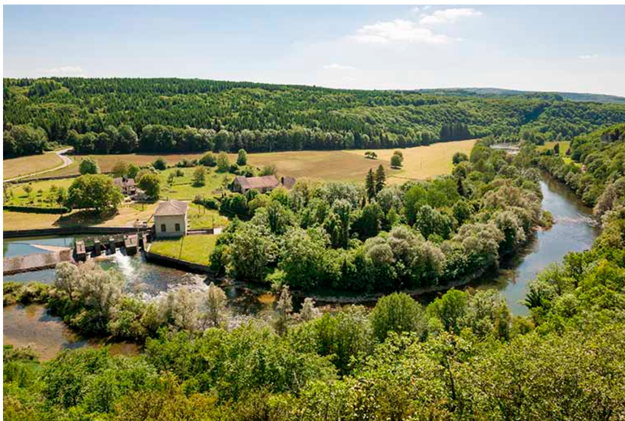
Forges de Châtillon-sur-Lison puis centrale hydroélectrique, Châtillon-sur-Lison.
