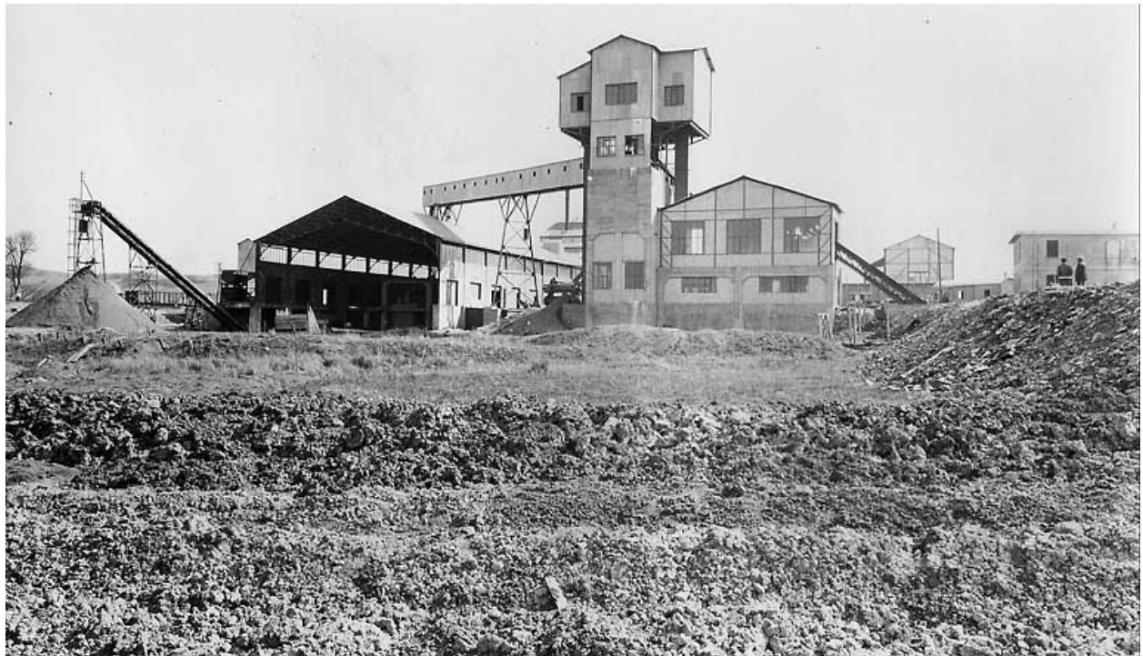
[Creveney] L'ensemble de concassage et la centrale électrique depuis l'ouest, 1933.
