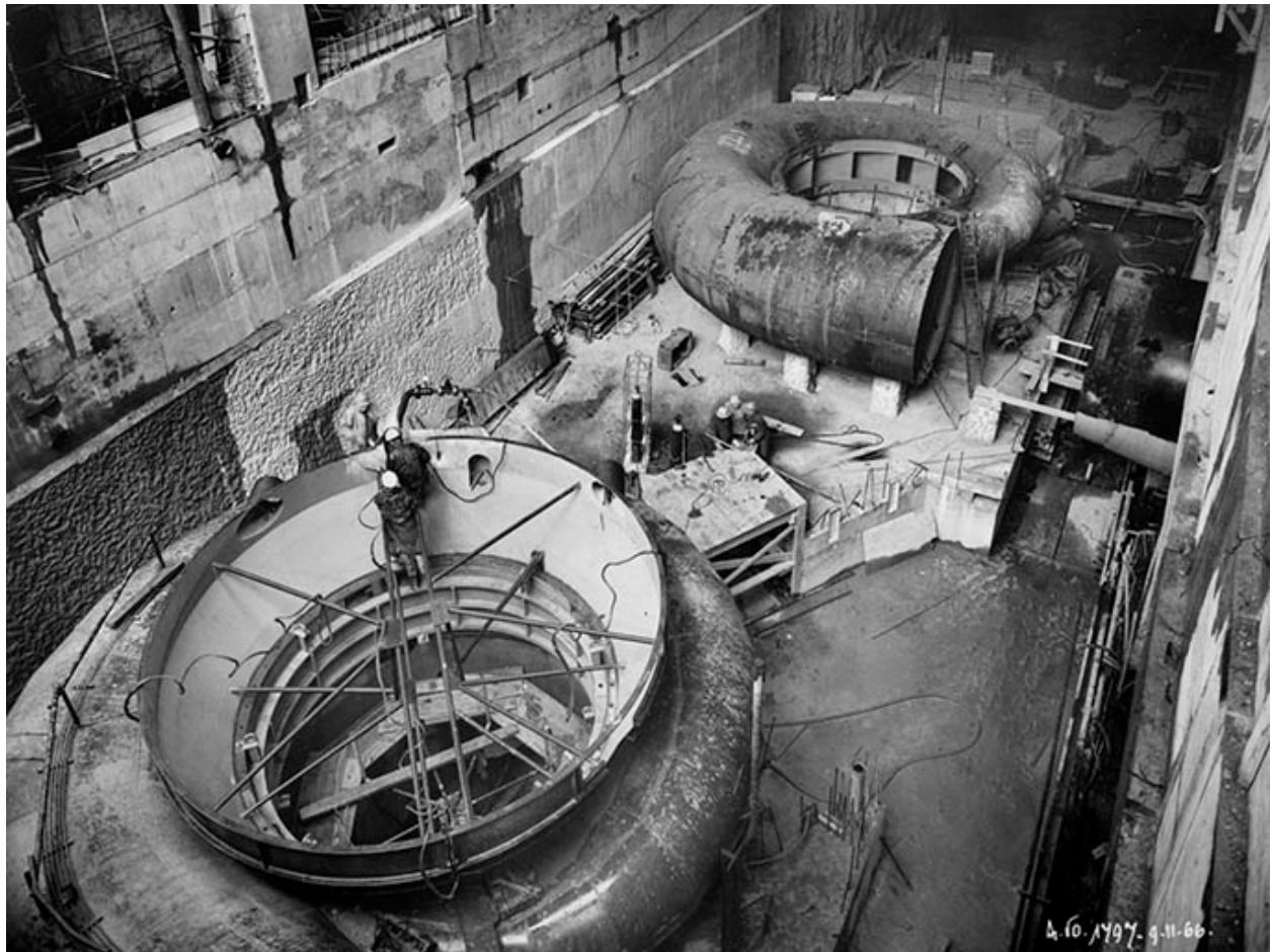
[Barrage de Vouglans] Centrale - Bâches groupe I et II, 9 novembre 1966.
