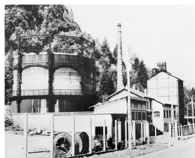
Vue d'ensemble de l'usine à gaz de Saint-Claude avec son gazomètre, [vers 1950]. Phot. Jérôme Mongreville IVR43_19923900016X
