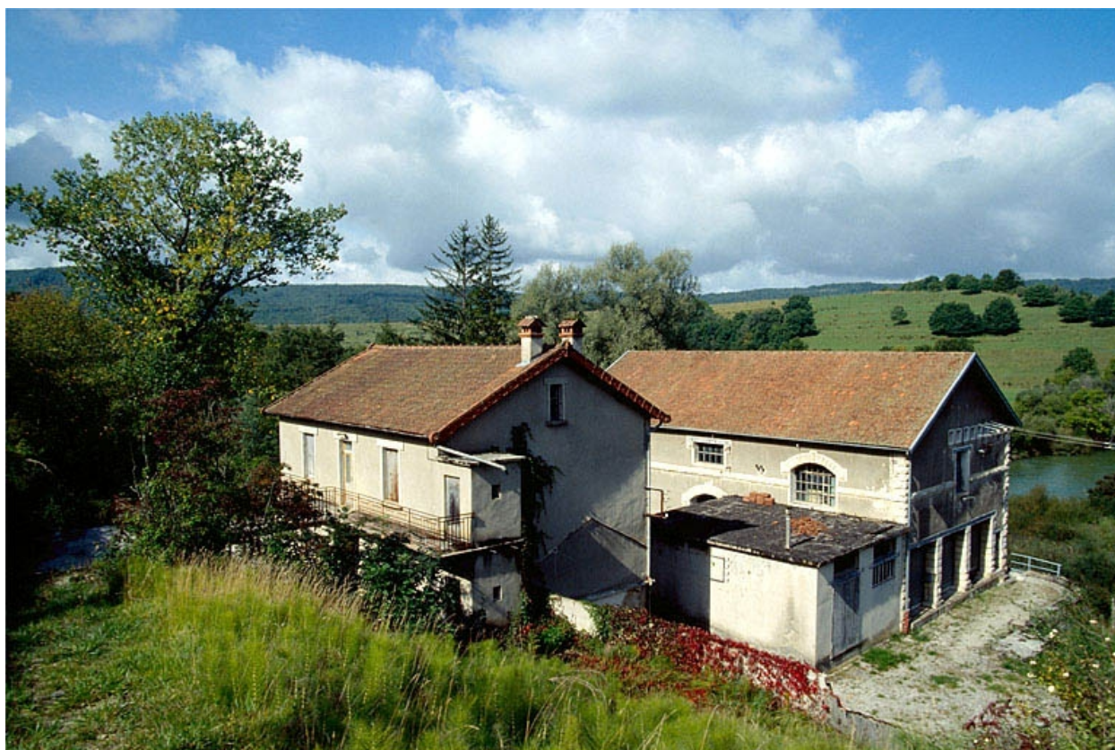
Centrale hydroélectrique de Chalain, Marigny.
