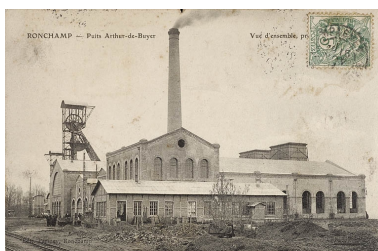
Ronchamp - Puits Arthur-de- Buyer - Vue d'ensemble [...], [fin 19e siècle ou début 20e siècle]. Phot. Jérôme Mongreville IVR43_20057000636NUCA
