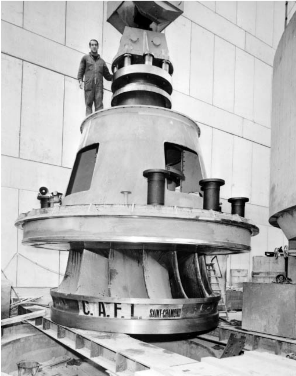
[Barrage de Vouglans] Roue turbine : support pivoterie en cours de montage, 26 mars 1969.
