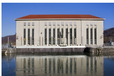
Centrale hydroélectrique de Dampjoux, Noirefontaine.
