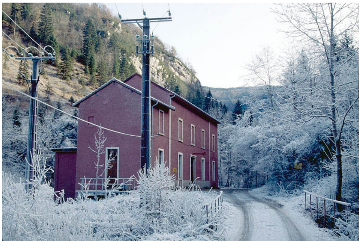
Centrale hydroélectrique de la Mutuelle électrique du Haut-Jura, Septmoncel.
