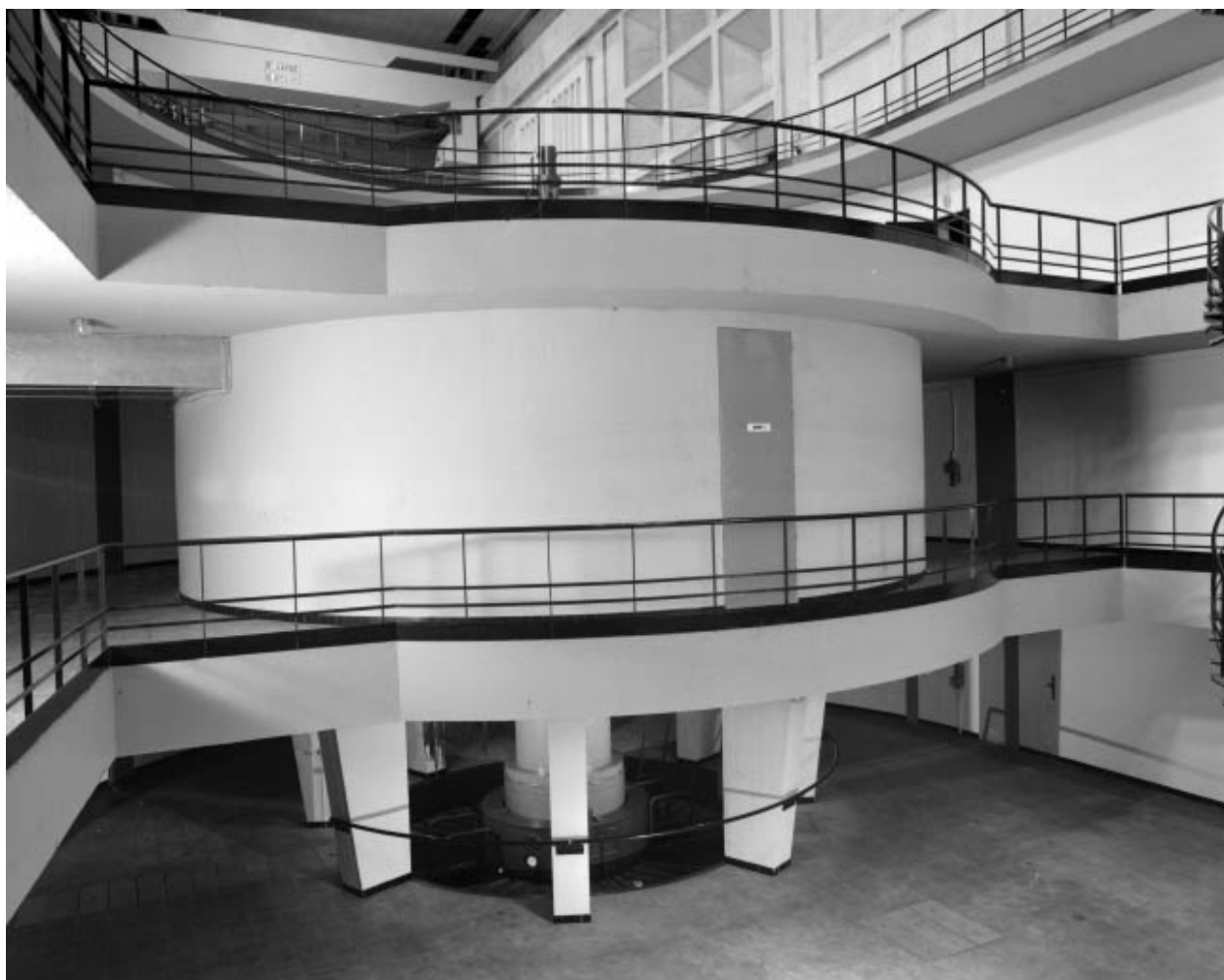
Centrale hydroélectrique du Saut-Mortier, Cernon : pivoterie et alternateur du 2e groupe.
