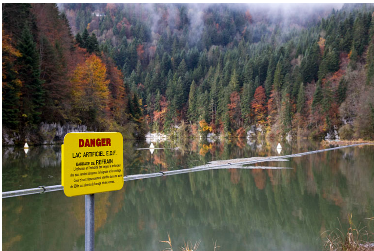
Barrage du Refrain, Fournet-Blancheroche : bassin de retenue et drome.
