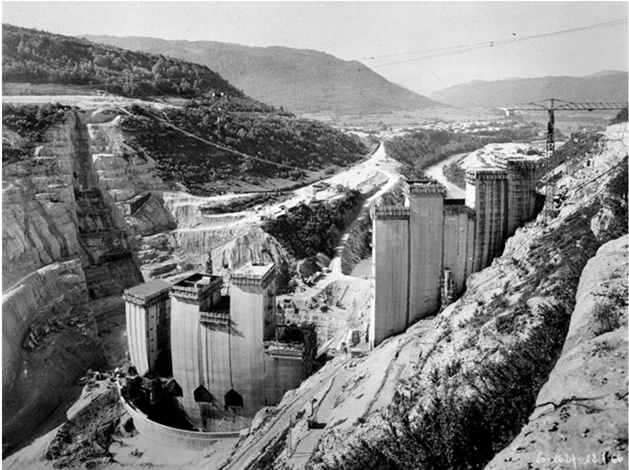
Barrage de Vougls - Vue d'ensemble depuis amont rive gauche, 12 juillet 1966.
