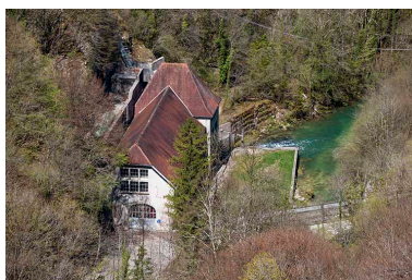
Centrale hydroélectrique de Mouthier, Mouthier-Haute-Pierre. Phot. Jérôme Mongreville IVR43_20152501133NUC4A
