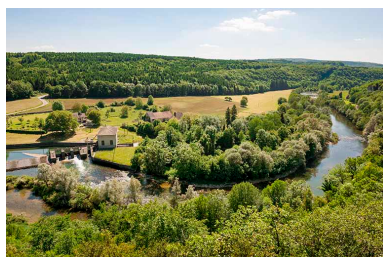
Forges de Châtillon-sur-Lison puis centrale hydroélectrique, Châtillon-sur-Lison. Phot. Jérôme Mongreville IVR43_20152501225NUC4A
