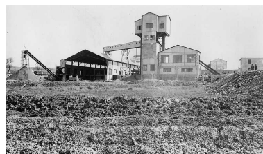
[Creveney] L'ensemble de concassage et la centrale électrique depuis l'ouest, 1933. Phot. Emile Hérissé IVR43_20077000465NUCA
