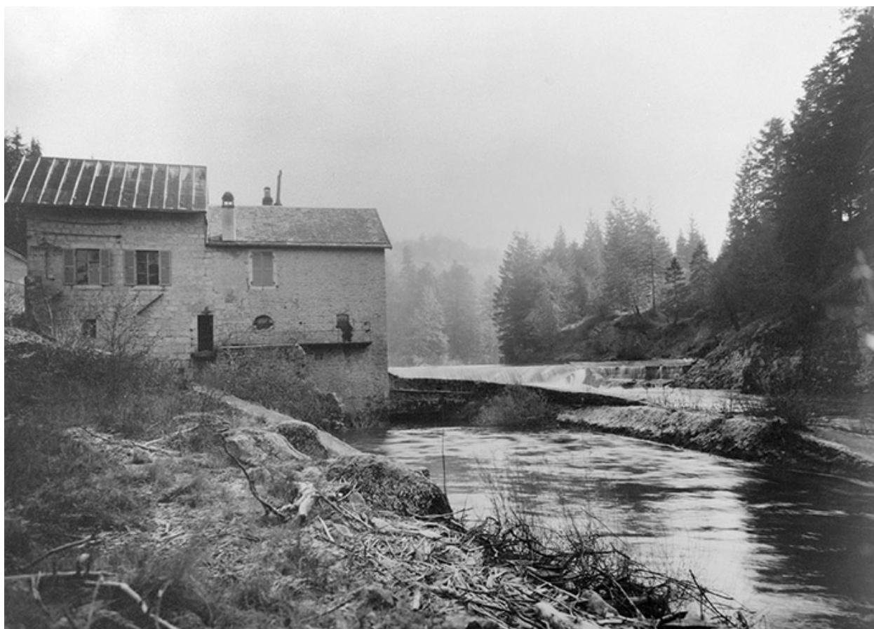
[Centrale hydroélectrique de la Roche] Vue générale, 1950-1951.
