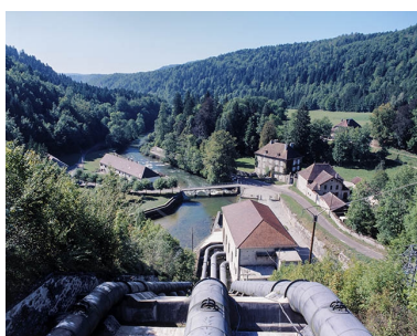
Usine métallurgique dite forges de Châteaivilain puis centrale hydroélectrique, Bourg-de-Sirod. Phot. Jérôme Mongreville IVR43_19913900569XA
