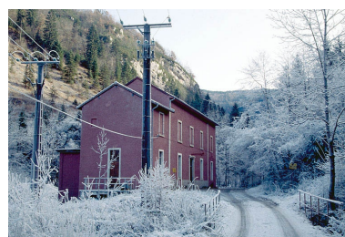
Centrale hydroélectrique de la Mutuelle électrique du Haut-Jura, Septmoncel. Phot. Laurent Poupard IVR43_19913901043ZA
