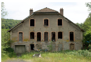
Mine de houille du puits du Magny, Magny-d'Anigon : bâtiment industriel. Phot. Jérôme Mongreville IVR43_20067000571NUCA
