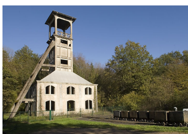
Mine de houille du puits Sainte- Marie, Ronchamp : le chvalement. Phot. Jérôme Mongreville IVR43_20067000969NUCA
