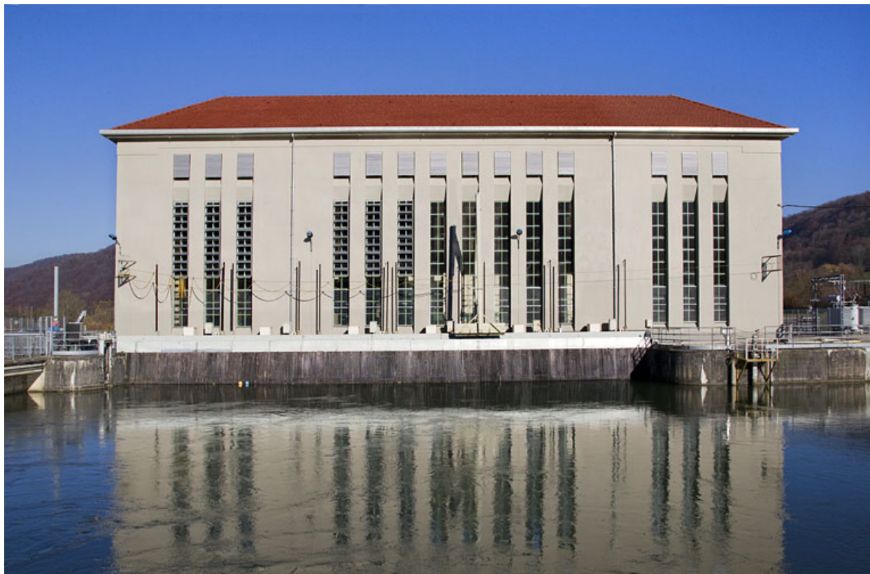
Centrale hydroélectrique de Dampjoux, Noirefontaine.
