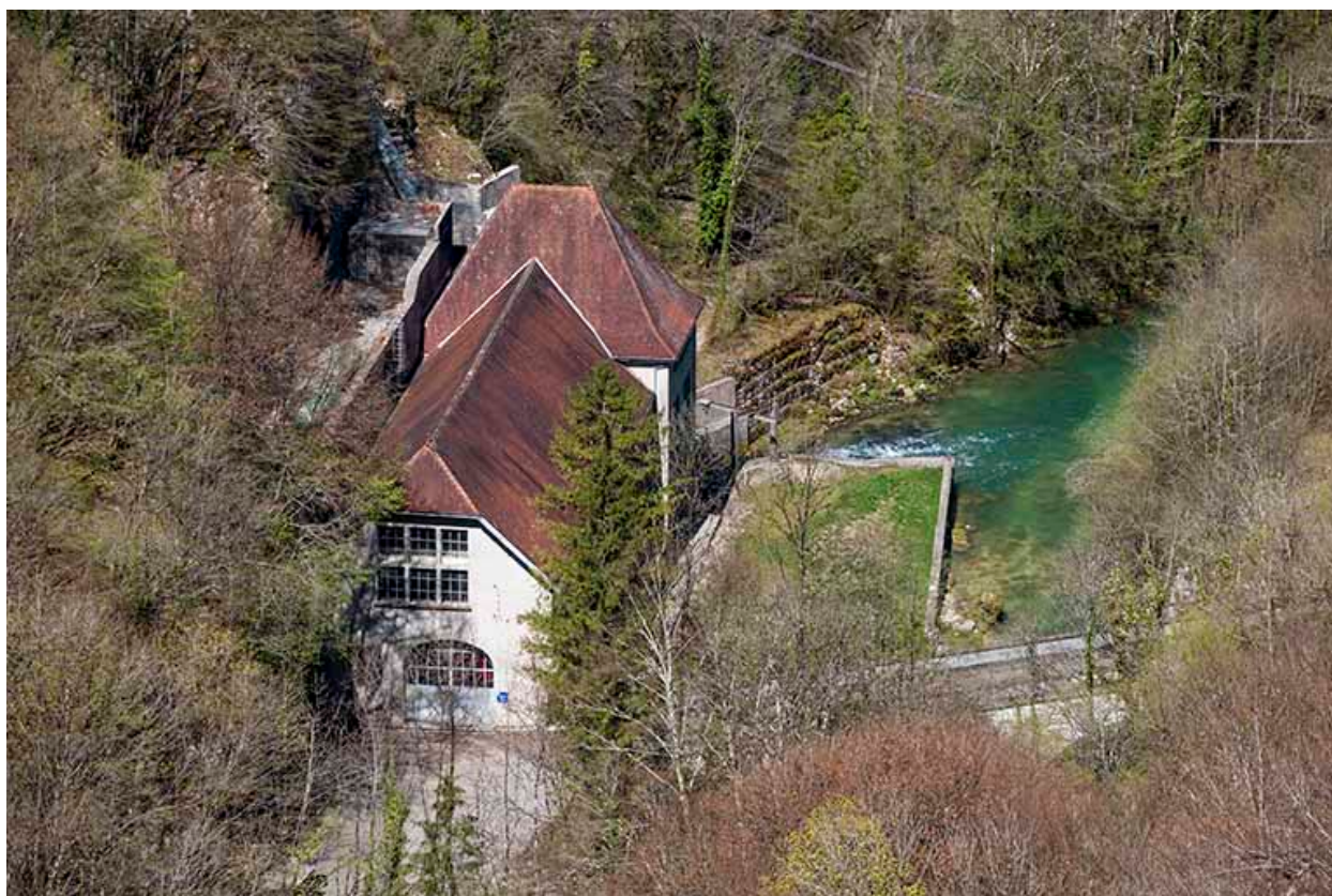
Centrale hydroélectrique de Mouthier, Mouthier-Haute-Pierre.
