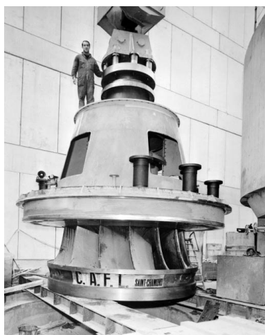
[Barrage de Vouglans] Roue turbine : support pivoterie en cours de montage, 26 mars 1969. Phot. Jérôme Mongreville, Autr. Studios Villeurbannais Monchanin et Périchon IVR43_19913900320X
