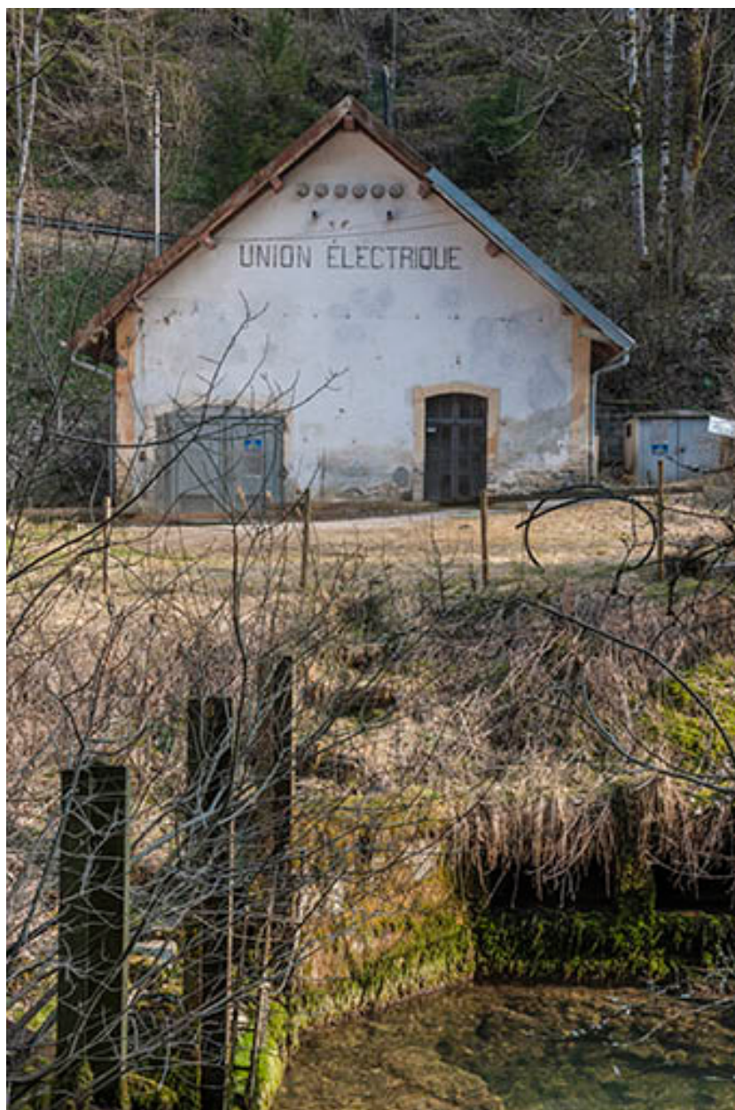
Centrale hydroélectrique du val de Consolation, Consolation-Maisonnettes.
