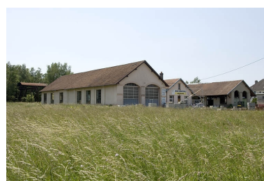
Mine de houille du puits Saint- Joseph, Ronchamp : vue d'ensemble. Phot. Jérôme Mongreville IVR43_20067000504NUCA
