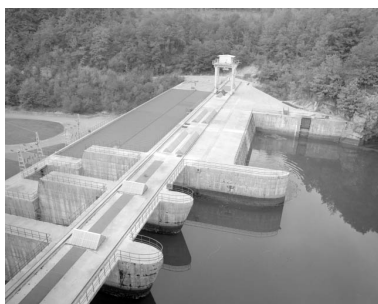
Centrale hydroélectrique du Saut-Mortier, Cernon : évacuateur de crue et toiture de l'usine. Phot. Jérôme Mongreville IVR43_19913900647X
