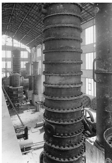
[Creveney] Intérieur de la raffinerie [de la Société des Schistes et Pétroles de Franche-Comté]. Colonnes de distillation, 1933. Phot. Emile Hérissey, Phot. Emile Hérissey IVR43_20077000477NUCA
