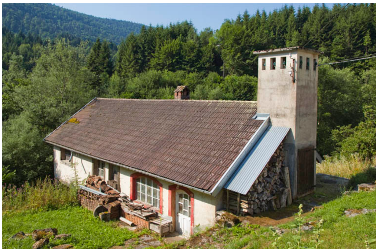
Scierie Renaud puis centrale hydroélectrique Huot-Marchand, Battenans-Varin.
