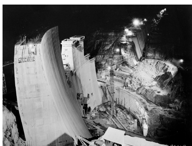
Barrage [de Vouglans] - Vue générale depuis R.D. aval des plots en cours de bétonnage (de nuit), 8 février 1967.
