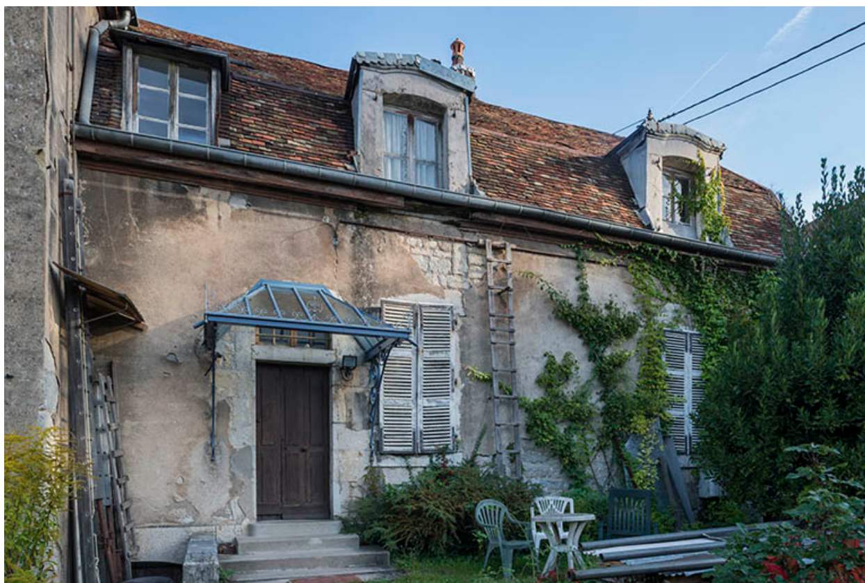
Façade sud de la maison.
