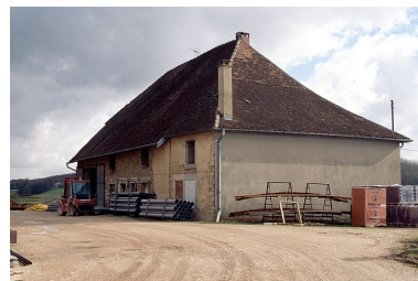
Logement, écurie et remise. Phot. Yves Sancey IVR43_19973900418ZA
