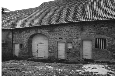
Façade antérieure. Phot. F. Pernin IVR43_19743900091Z
