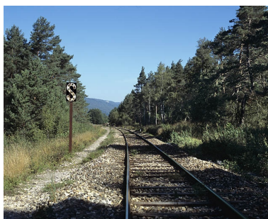
Panneau S annonçant le passage à niveau. Le panneau S impose au mécanicien de siffler (en général avant un passage à niveau non gardé).
