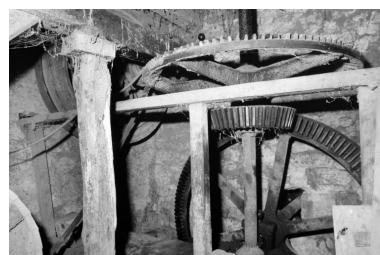
Transmission de la roue en dessus. Phot. Laurent Poupard IVR43_19923901243Z
