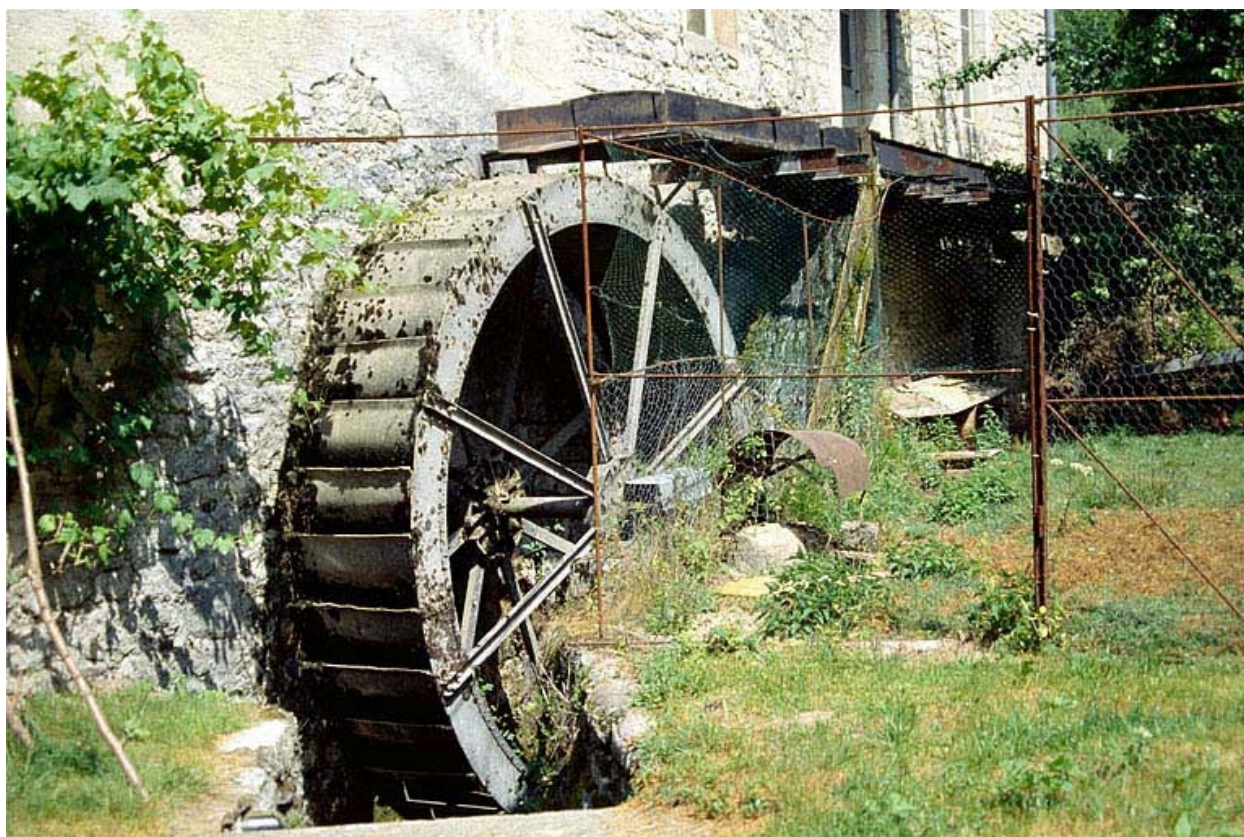
Roue en dessus et conduite d'amenée.
