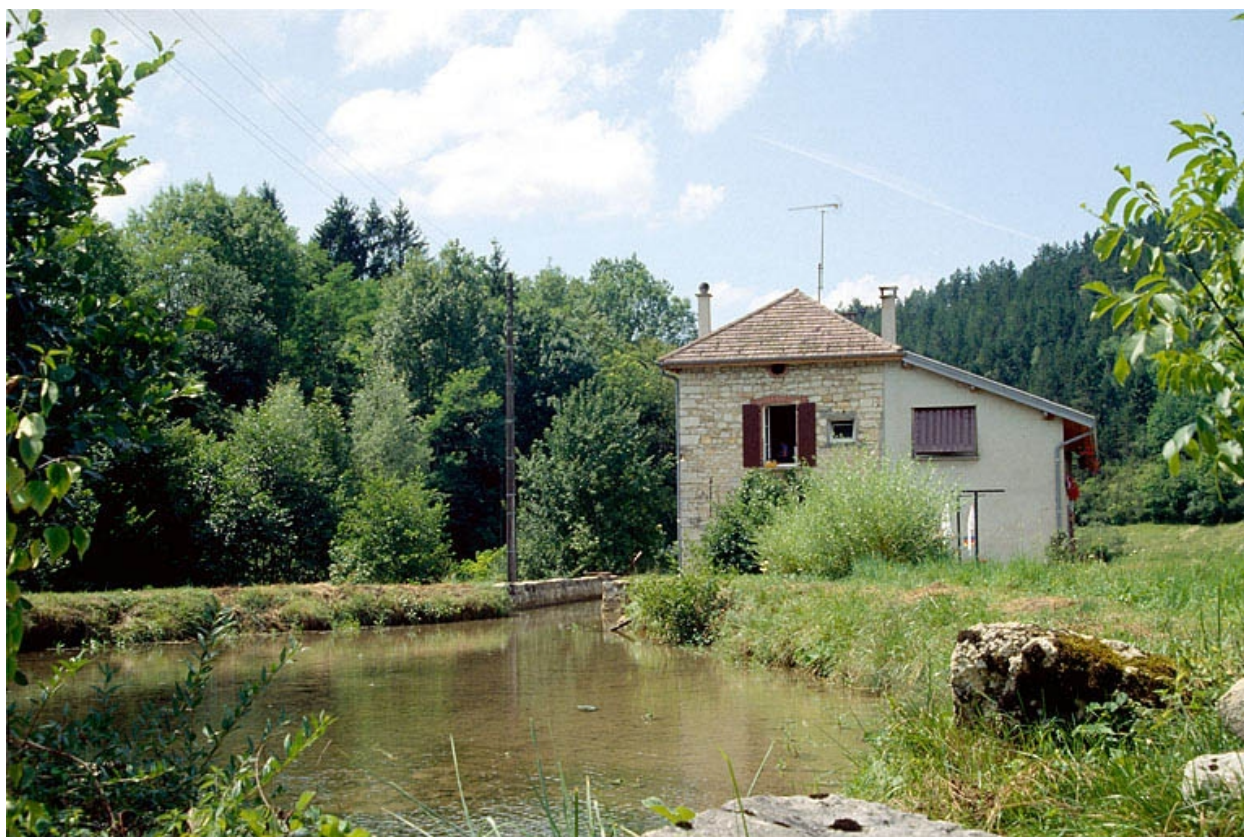
Bassin de retenue et façade latérale gauche.
