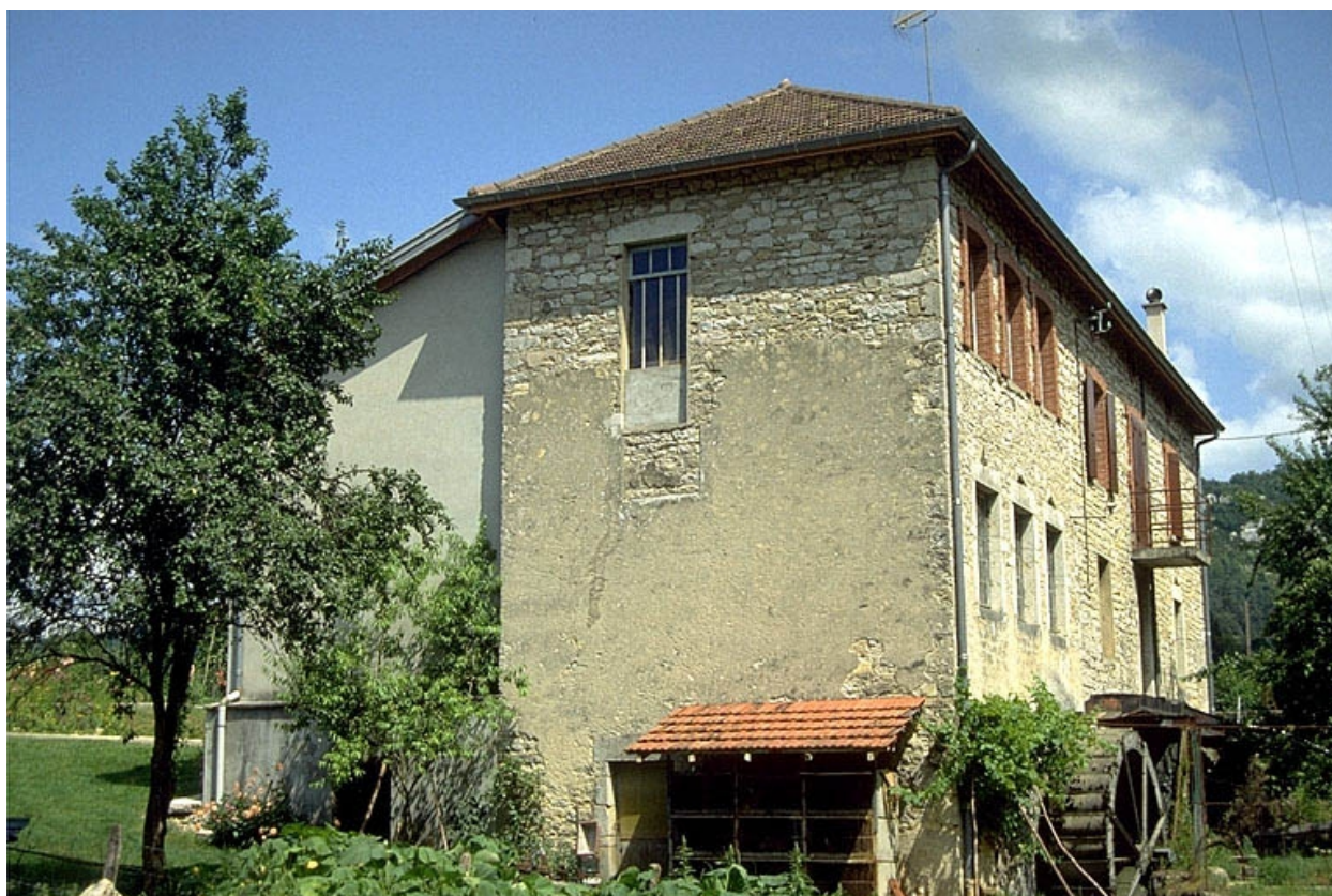
Façades postérieure et latérale droite.
