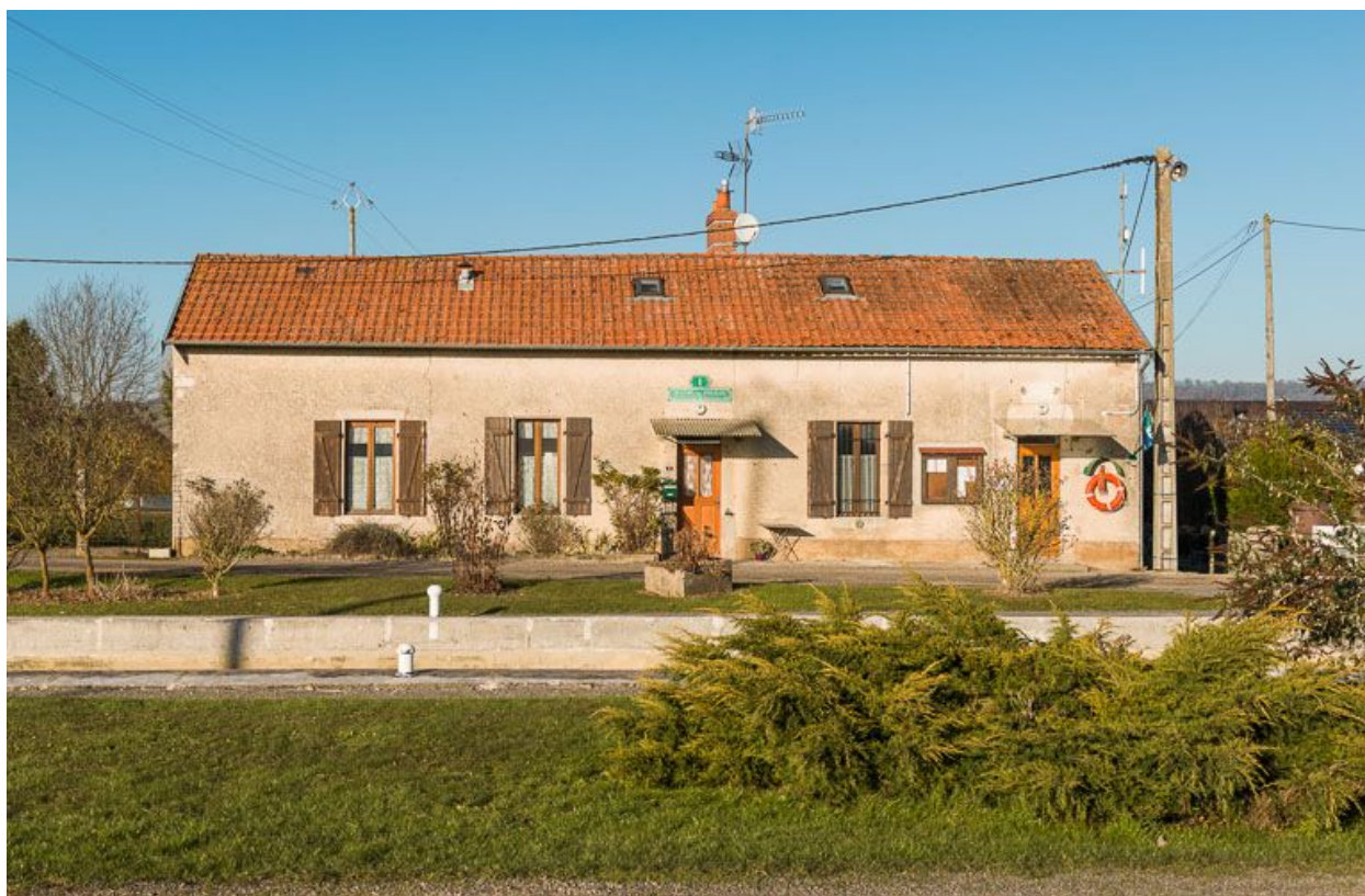
Vue de face de la maison éclusière.
