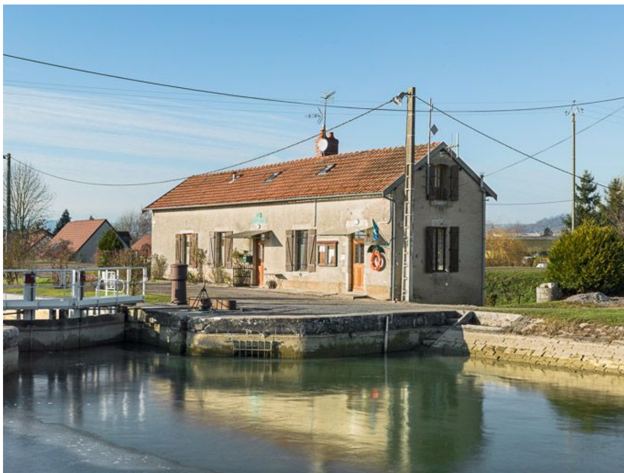
Vue de 3/4 de la maison éclusière.
