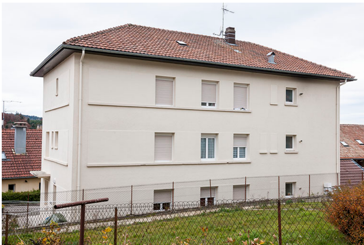
Usine : façades postérieure et latérale droite.
