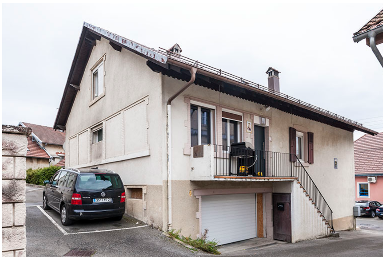
Maison : façades postérieure et latérale gauche.
