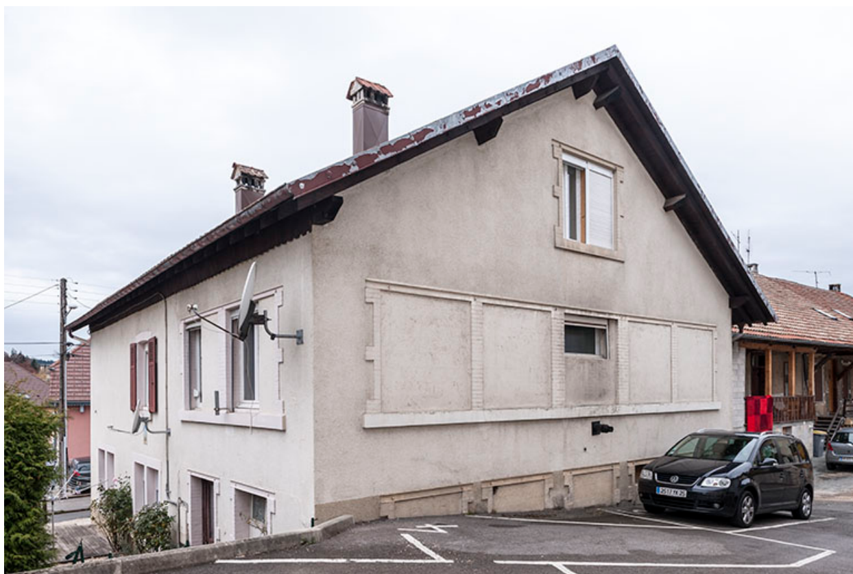
Maison : façades postérieure et latérale droite.
