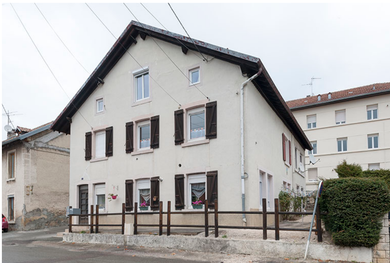
Maison : façades antérieure et latérale droite.
