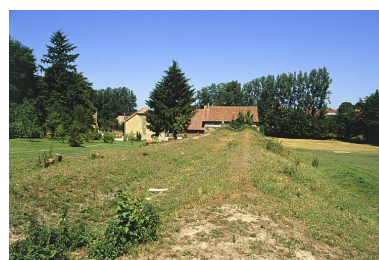
Le canal d'amenée du moulin (comblé). Phot. Yves Sancey IVR43_20009000528ZA
