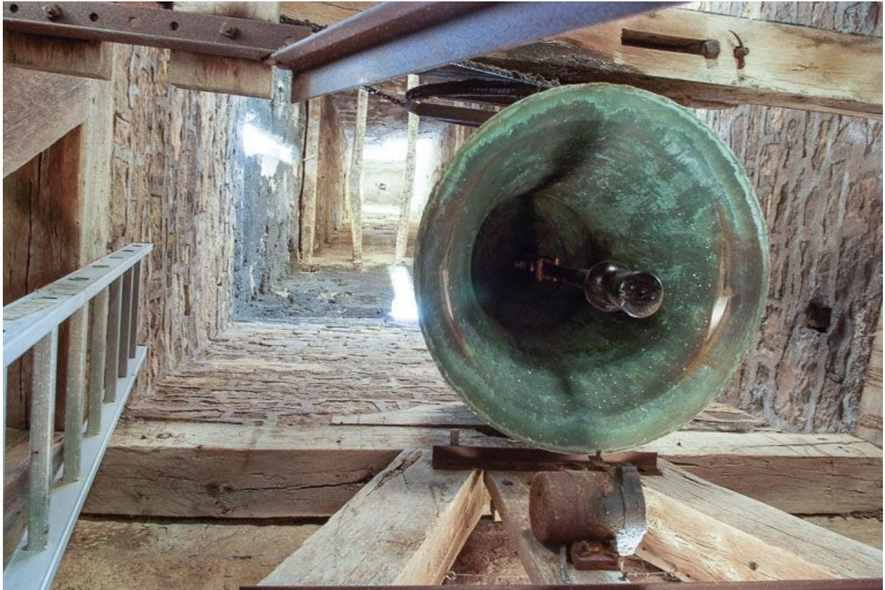
Vue depuis le plancher du beffroi.
