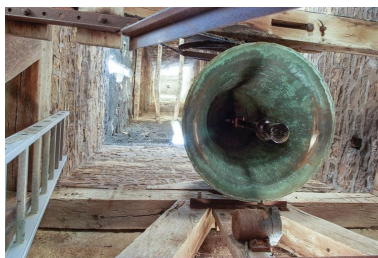
Vue depuis le plancher du beffroi. Phot. Pierre-Marie Barbe-Richaud IVR26_20152100462NUC2A
