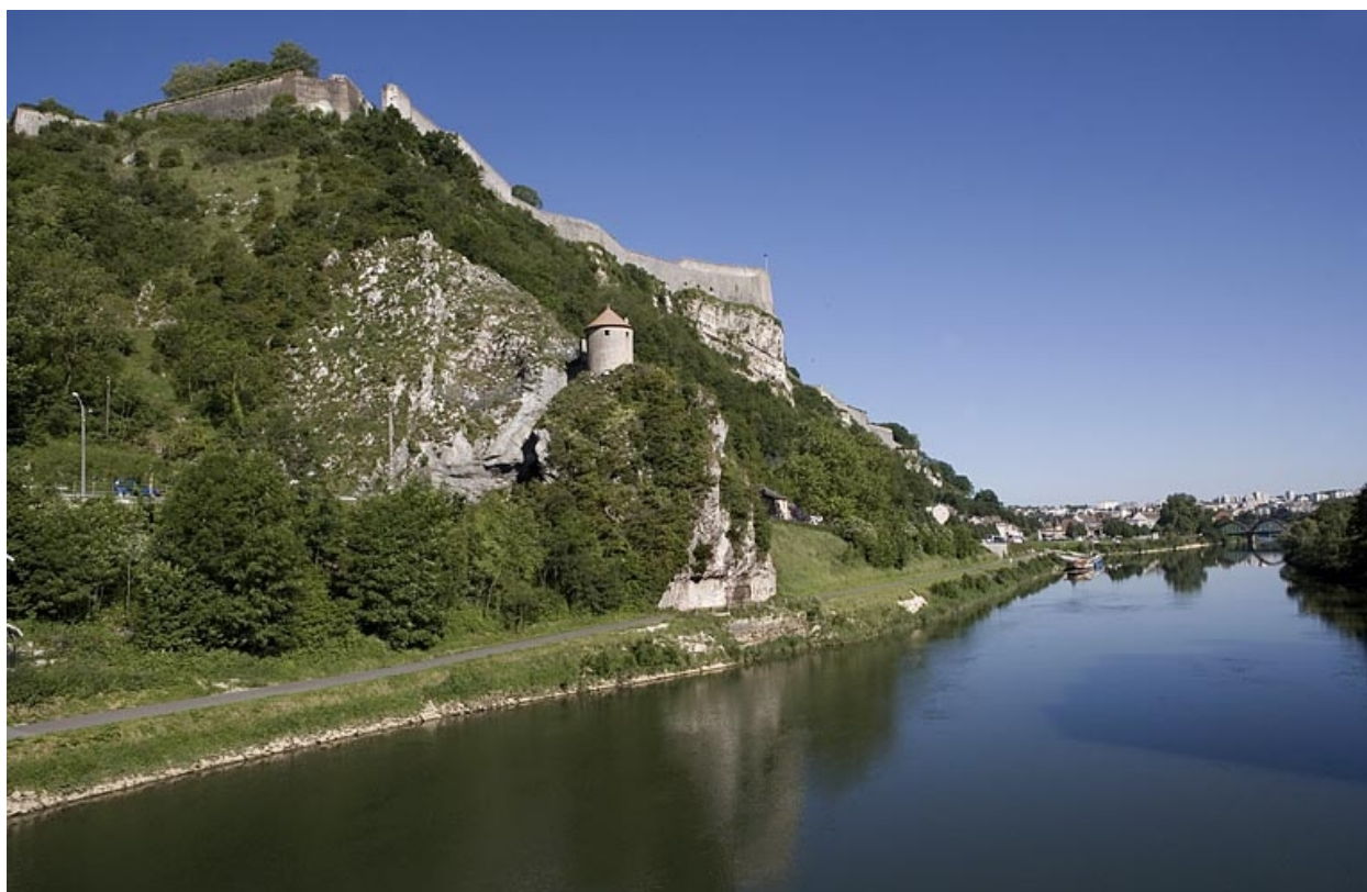
Vue d'ensemble du quai depuis l'amont.
