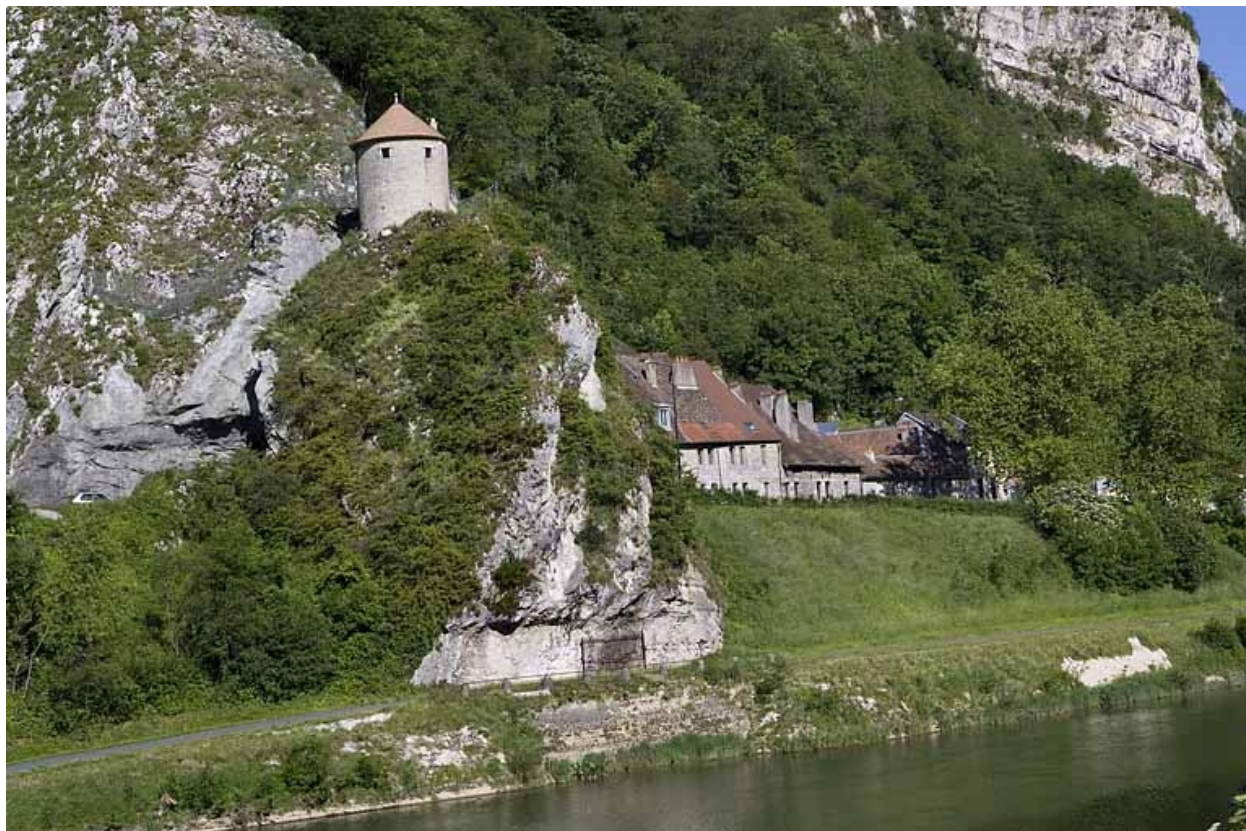
Vue d'ensemble rapprochée du quai.
