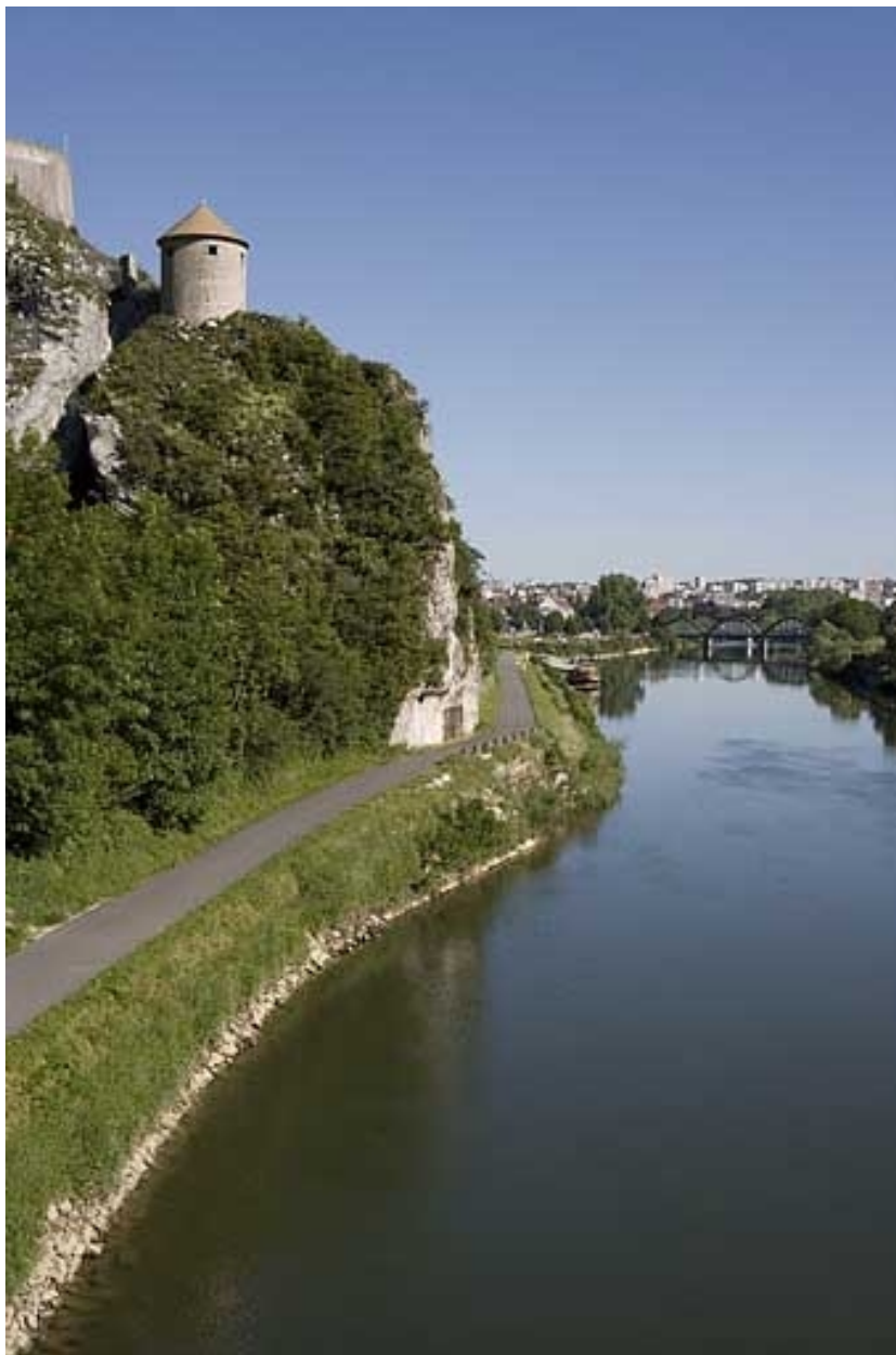
Vue d'ensemble du site depuis l'amont.
