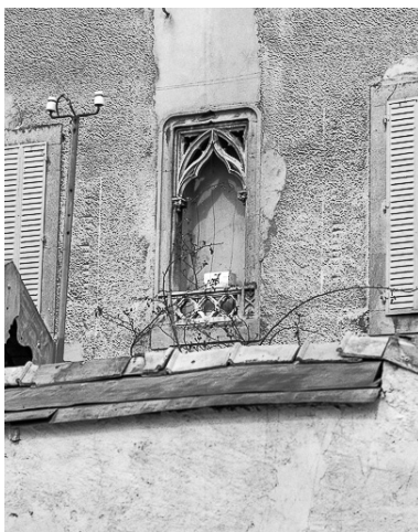
Fenêtre du pignon gauche. Phot. Yves Sancey IVR43_19802500248X
