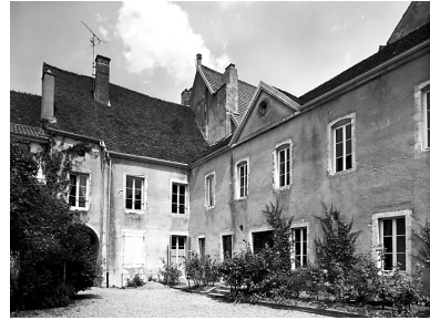
Façades sur cour intérieure. Phot. Yves Sancey IVR43_19817000839V
