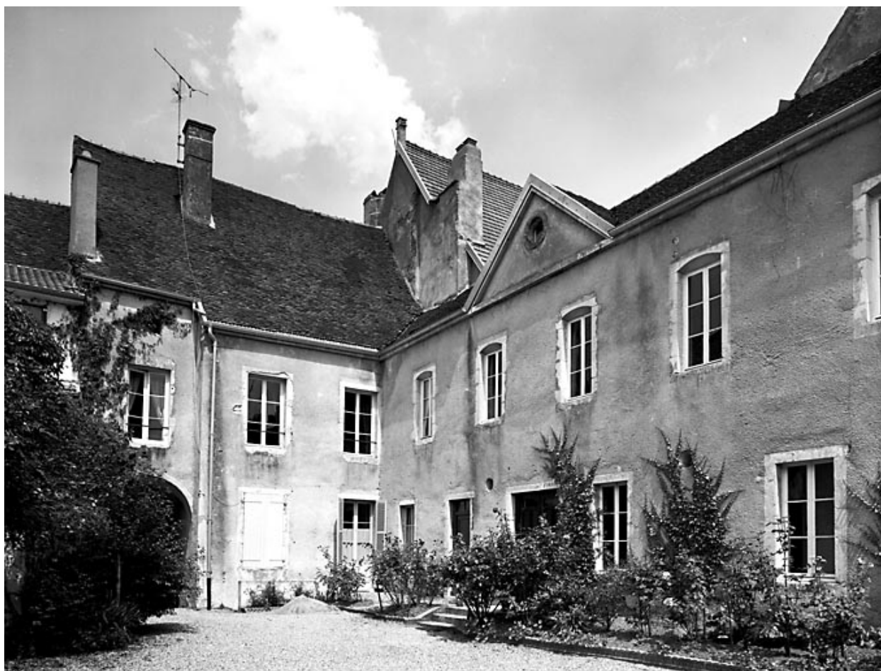
Façades sur cour intérieure.
