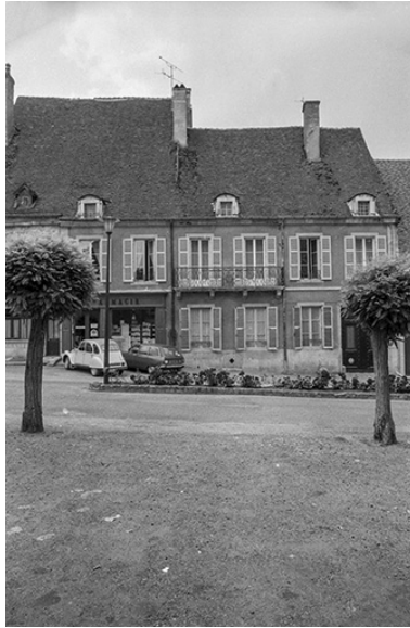
Façade sur rue. Phot. Yves Sancey IVR43_19817000838Z
