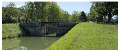
Vue du pont depuis l'aval. Phot. Pierre-Marie Barbe-Richaud IVR26_20112103879NUC4AQ
