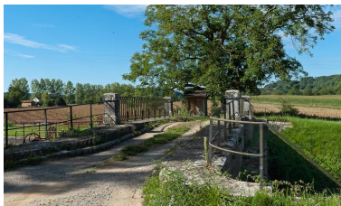
Vue du pont. Phot. Pierre-Marie Barbe-Richaud IVR26_20112103878NUC4AQ
