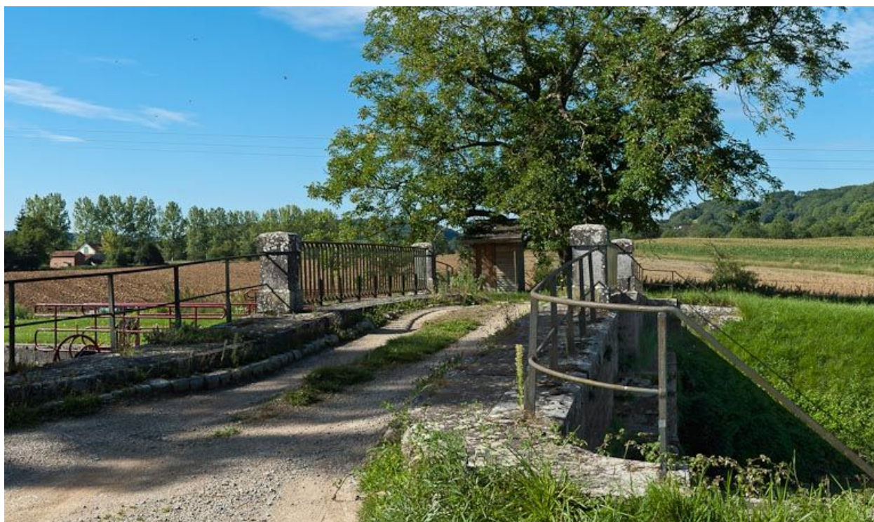
Vue du pont.
