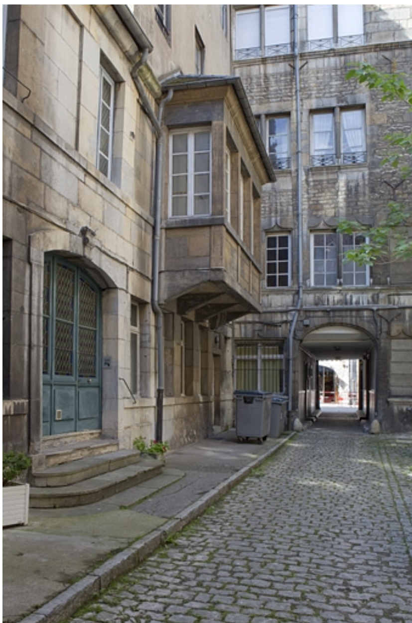
Immeuble sur rue : détail de la fenêtre centrale du premier étage.
