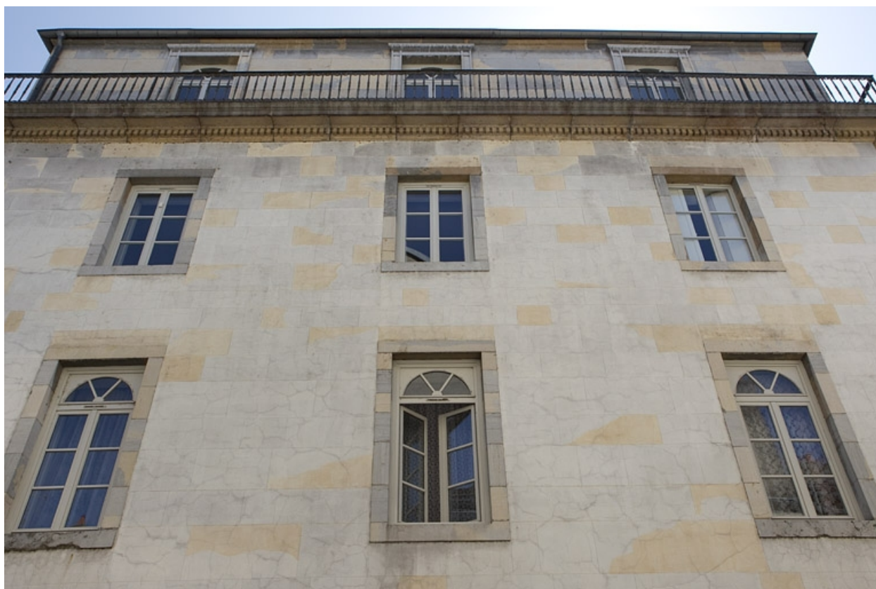
Immeuble sur rue : façade latérale droite.
