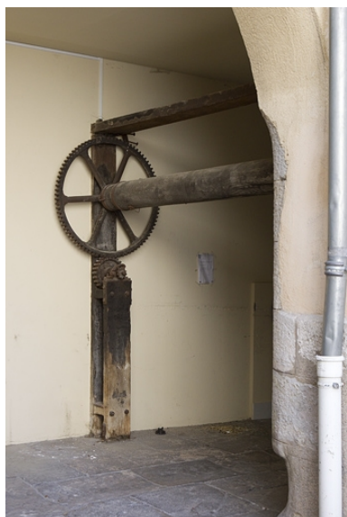
Détail du treuil pour monter et descendre les tonneaux dans la cave de l'immeuble. Phot. Yves Sancey
