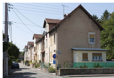
Alignement depuis l'entrée de la rue. Phot. Jérôme Mongreville IVR43_20112502061NUC4A
