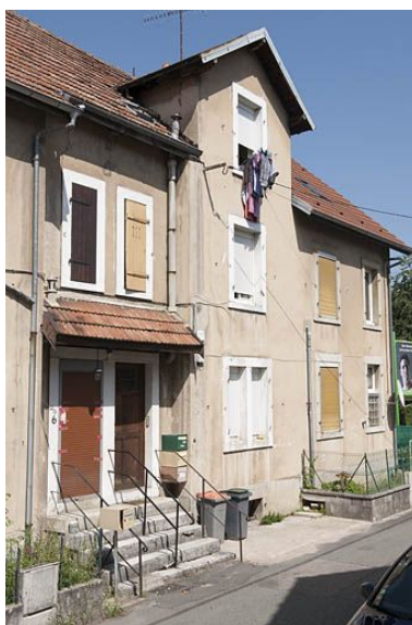
Détail d'une façade. Phot. Jérôme Mongreville IVR43_20112502065NUC4A
