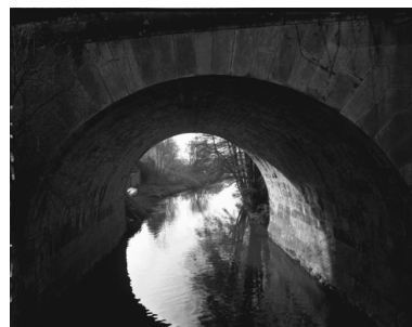
Passage voûté du canal de fuite sous la rue en 1989. Phot. Yves Sancey IVR43_19897000951X
