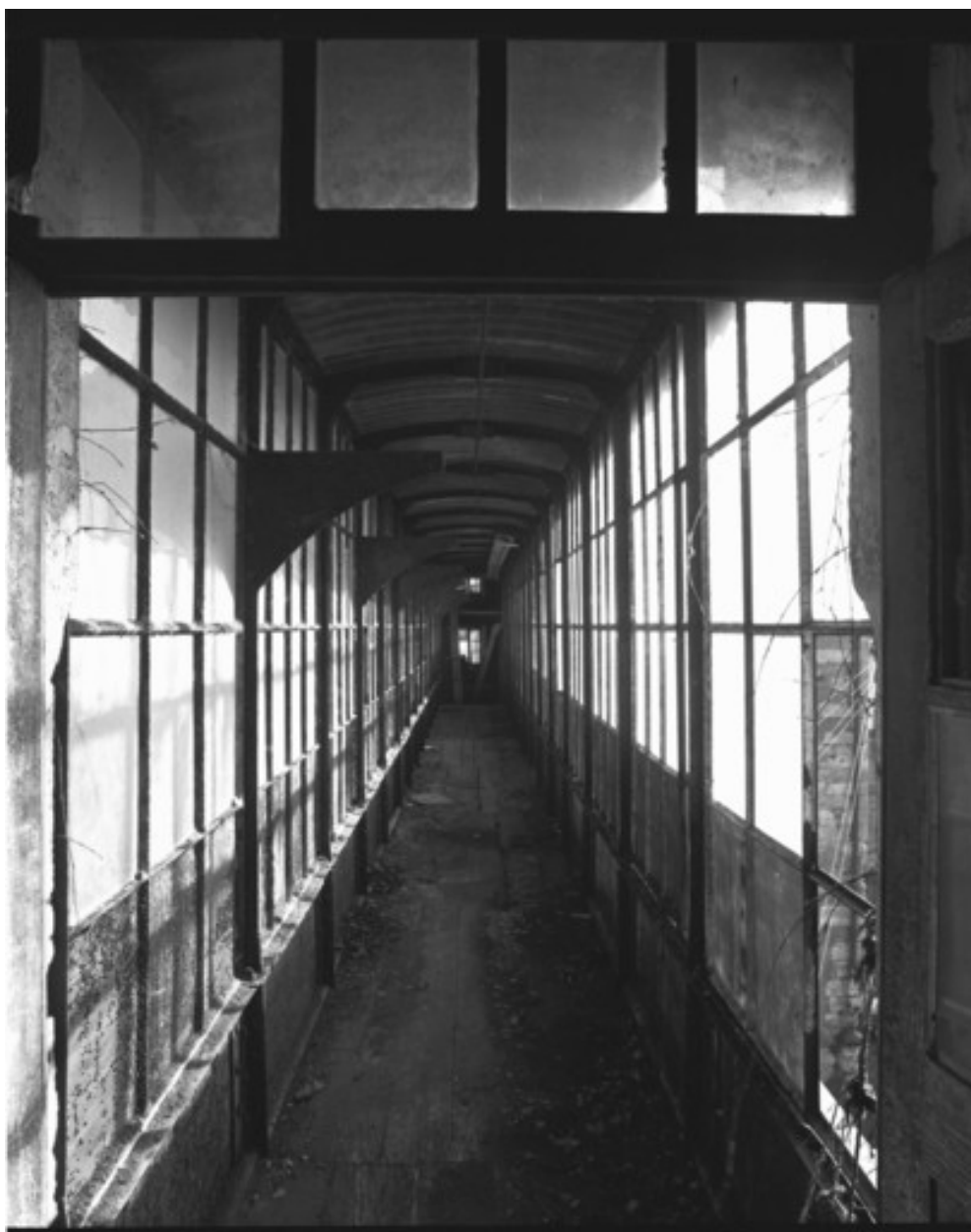
Intérieur de la passerelle en 1989.
