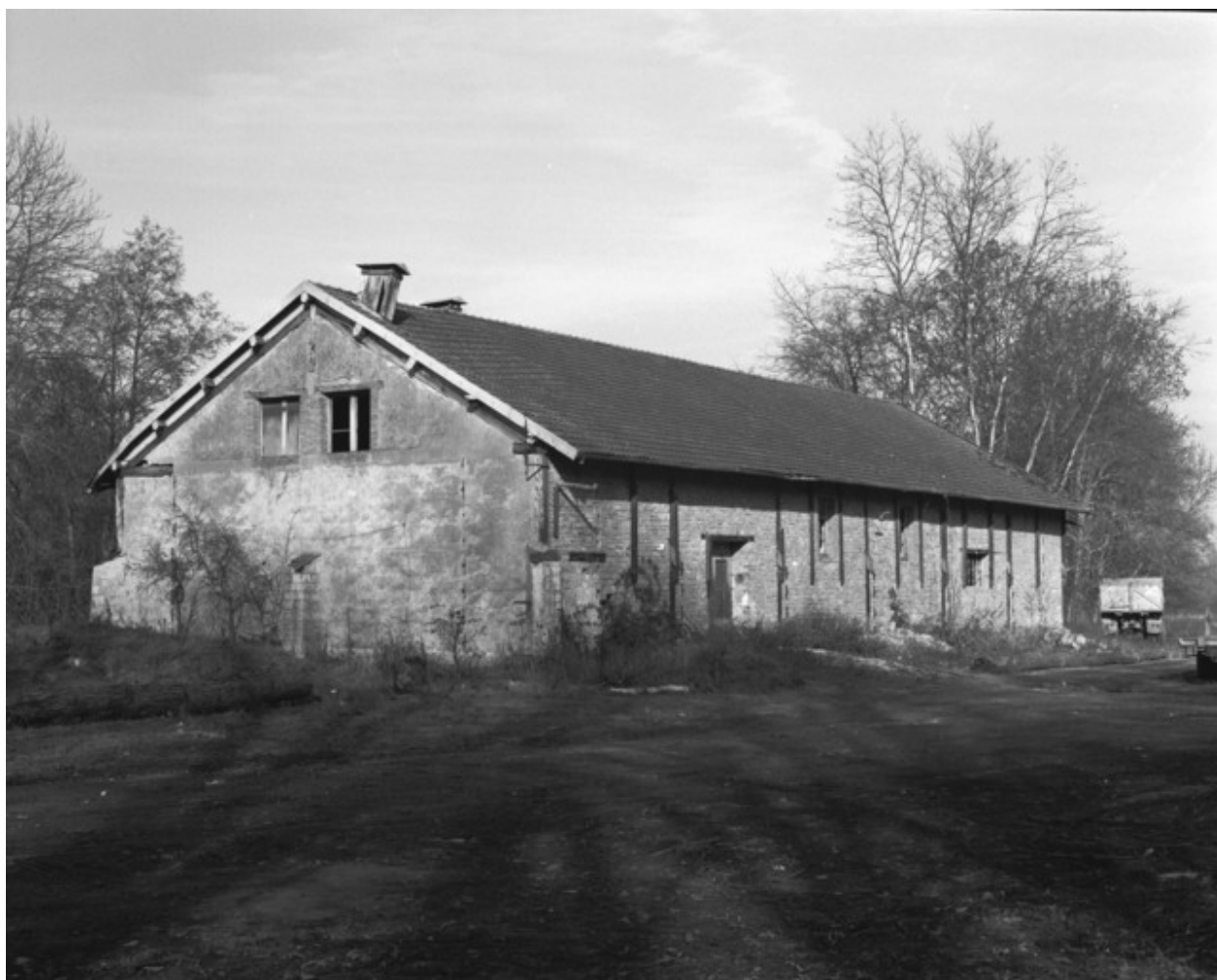
Vue rapprochée de l'entrepôt industriel en 1989.
