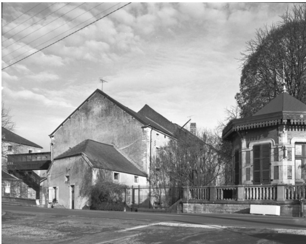
Vue générale de trois quarts droite en 1989.
