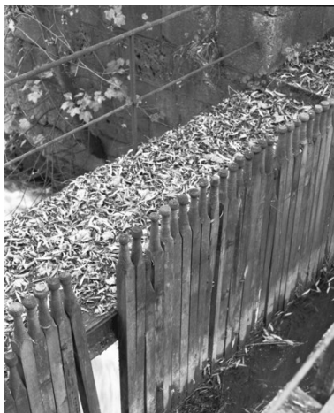
Détail des aiguilles du barrage en 1989. Phot. Yves Sancey IVR43_19897000954X
