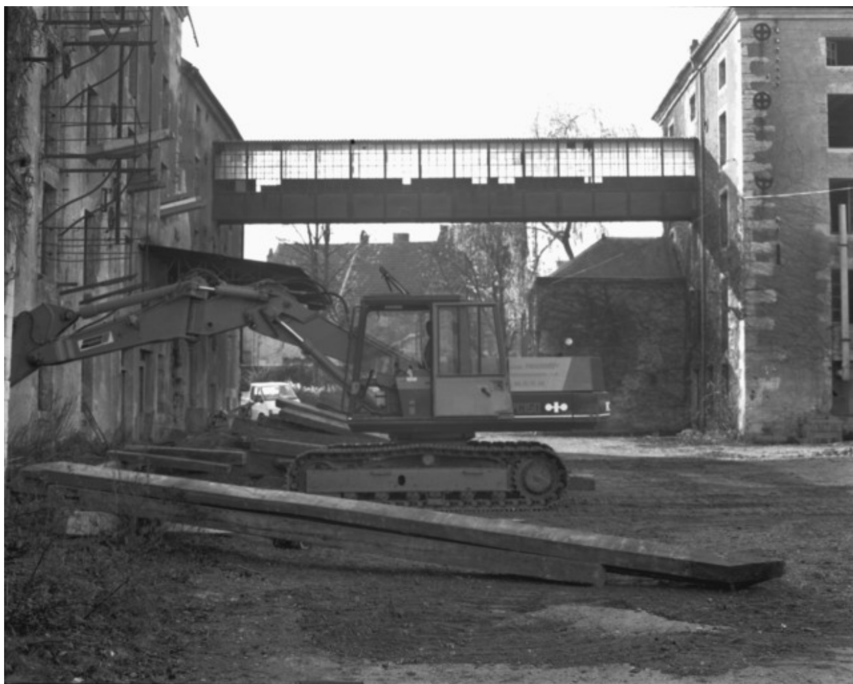
Vue rapprochée de la passerelle en 1989.
