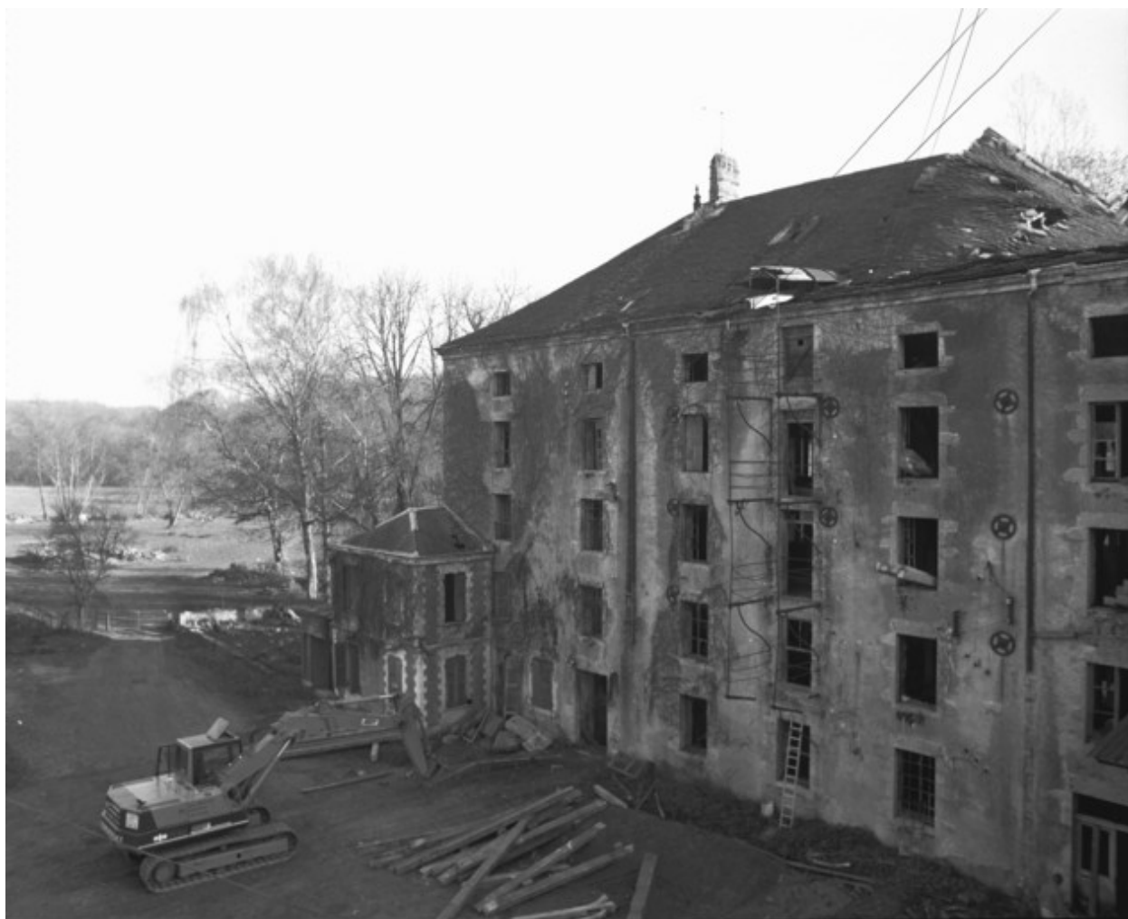
Façade antérieure du moulin public en 1989.
