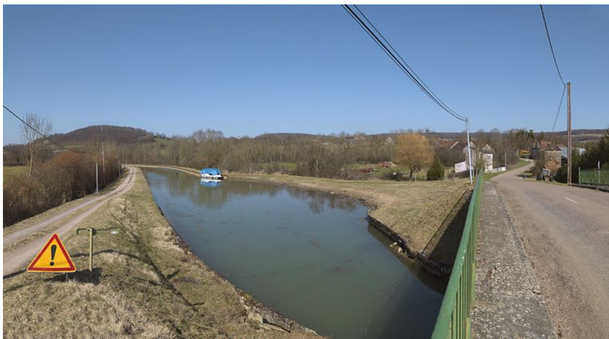
Vue d'ensemble du bassin de port.
