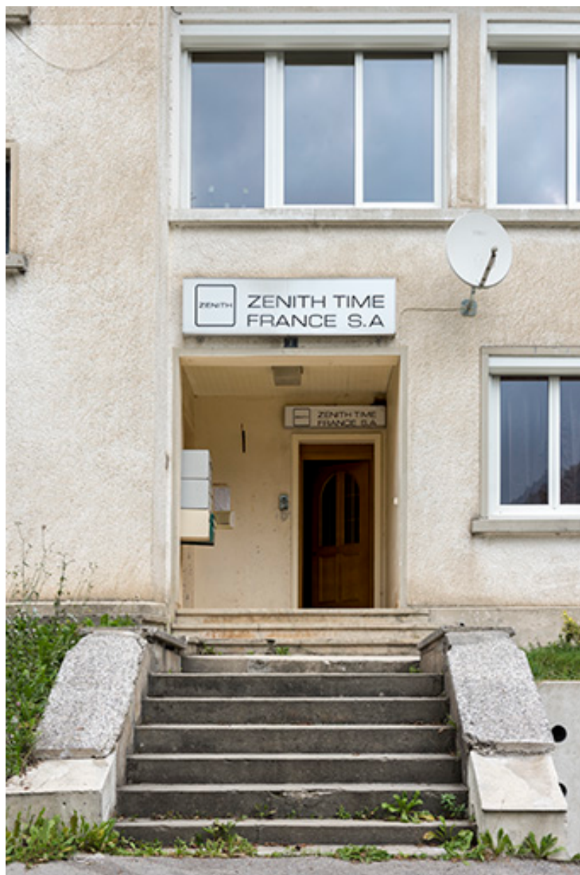
Façade antérieure : entrée de l'atelier de fabrication.
