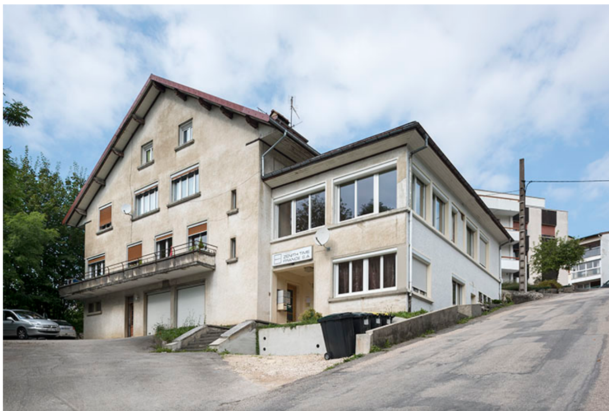
Façades antérieure et latérale droite.
