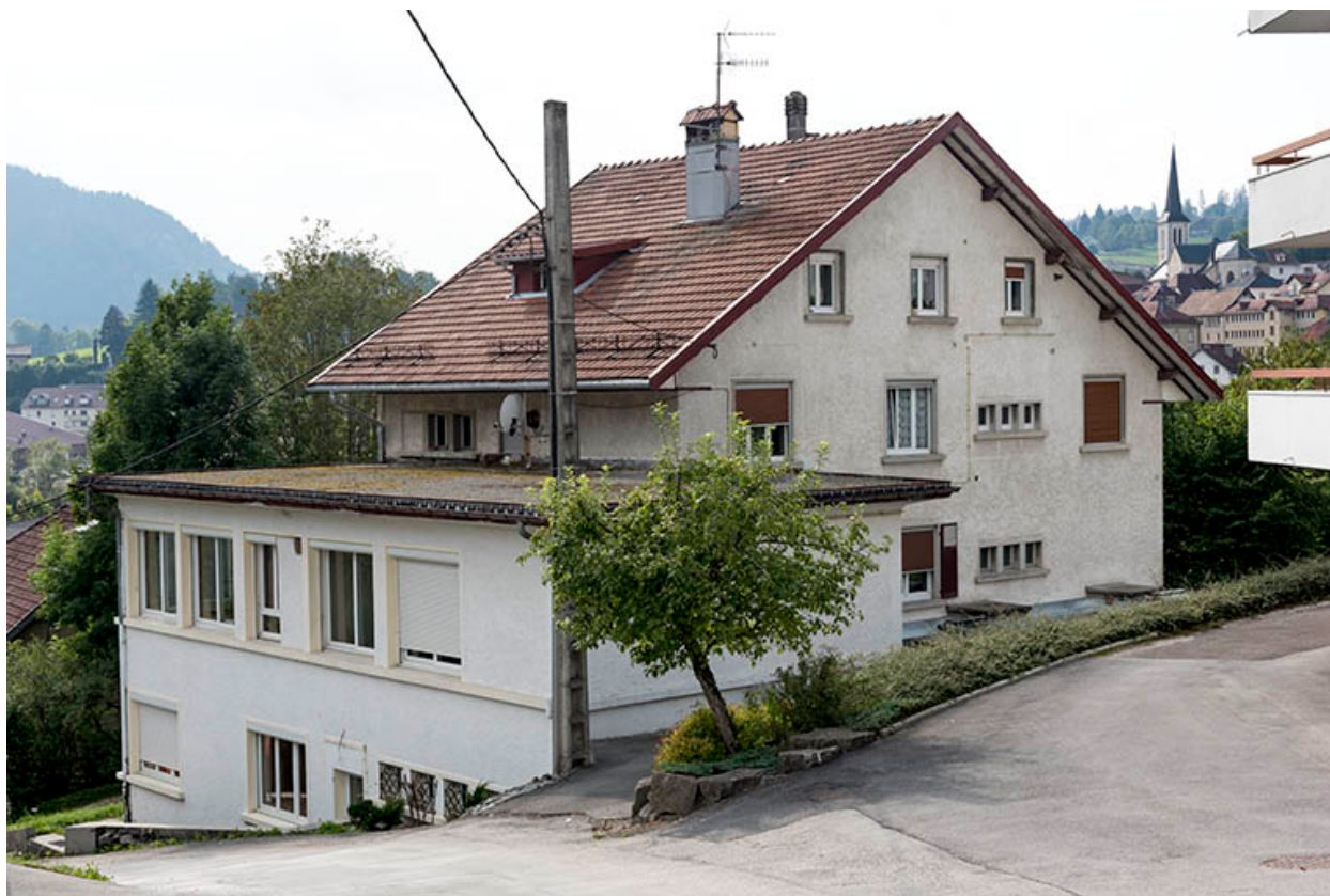
Façades postérieure et latérale droite.
