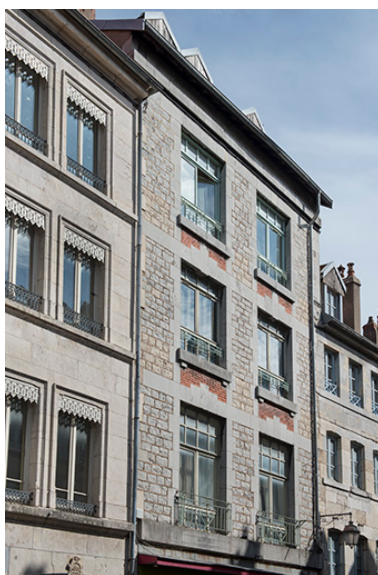
Façade vue de trois quarts gauche. Phot. Jérôme Mongreville IVR43_20172501124NUC4A
