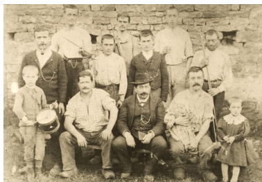
Groupe d'ouvriers. Phot. Jérôme Mongreville IVR43_20077000082NUCA
