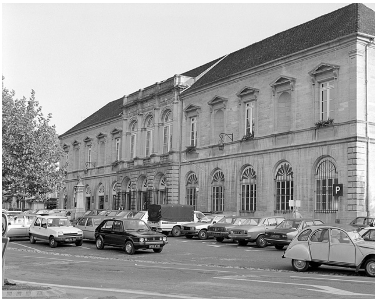
Façade nord vue de trois-quarts.
