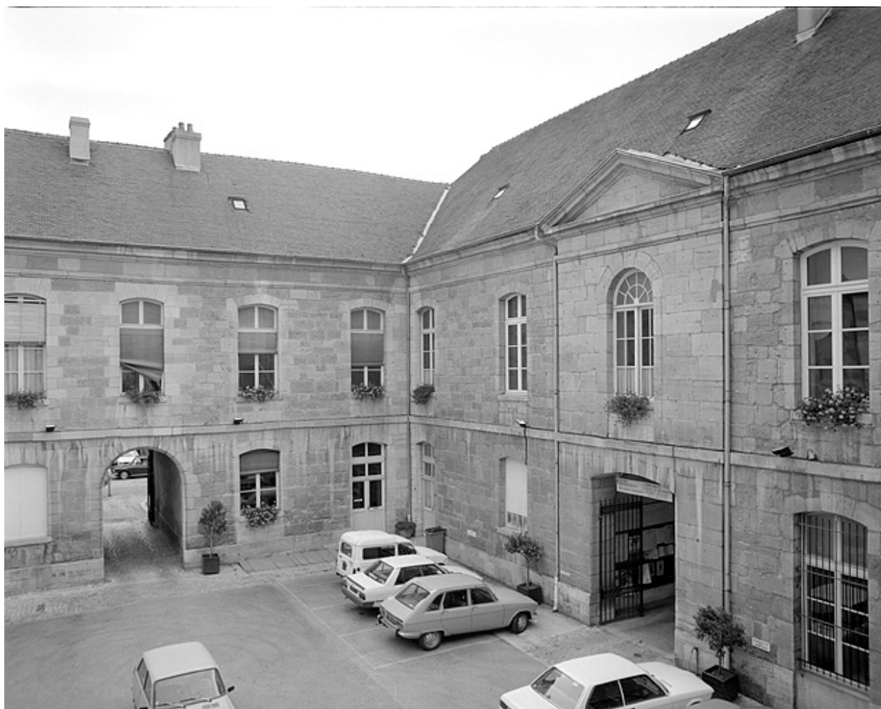
Cour intérieure : côtés est et sud.
