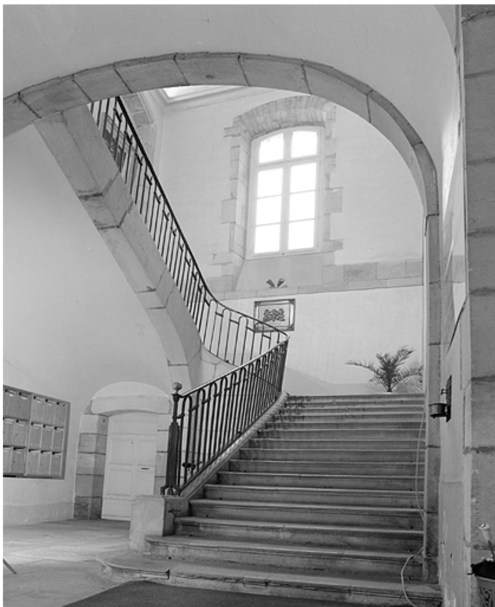
Grand escalier : vue générale.
