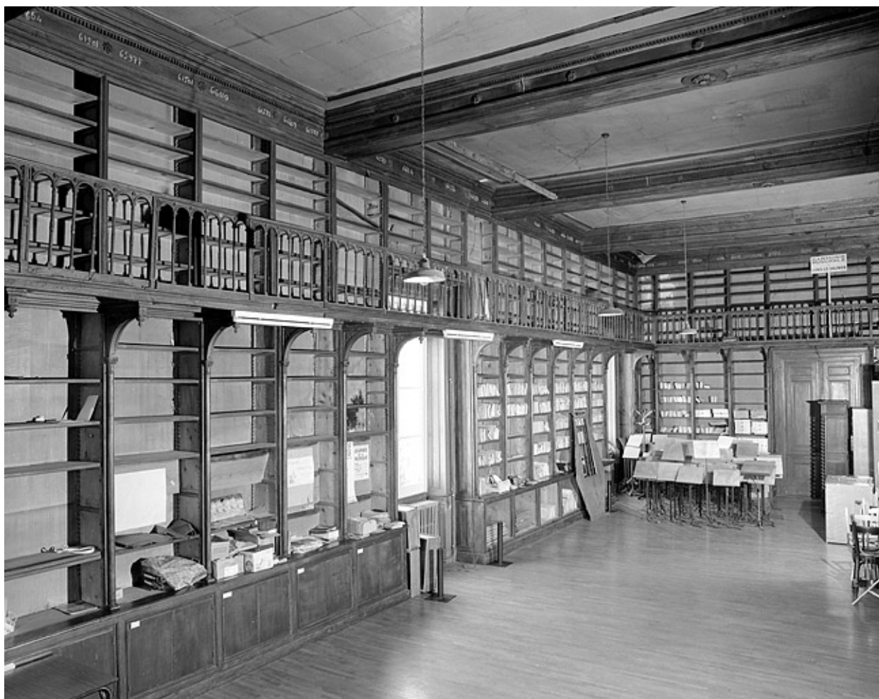
Ancienne salle de la Bibliothèque municipale, détail.
