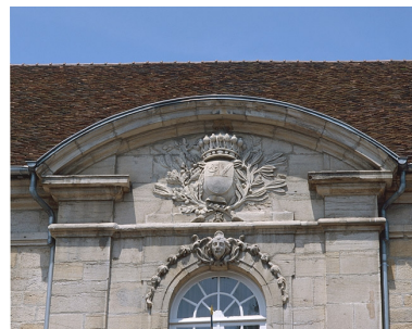
Détail du fronton de la façade sud.
