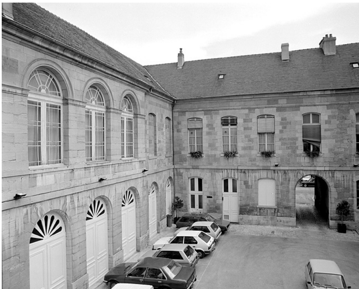
Cour intérieure : côtés nord et est.
