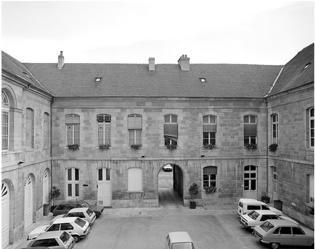
Cour intérieure, côté est.
