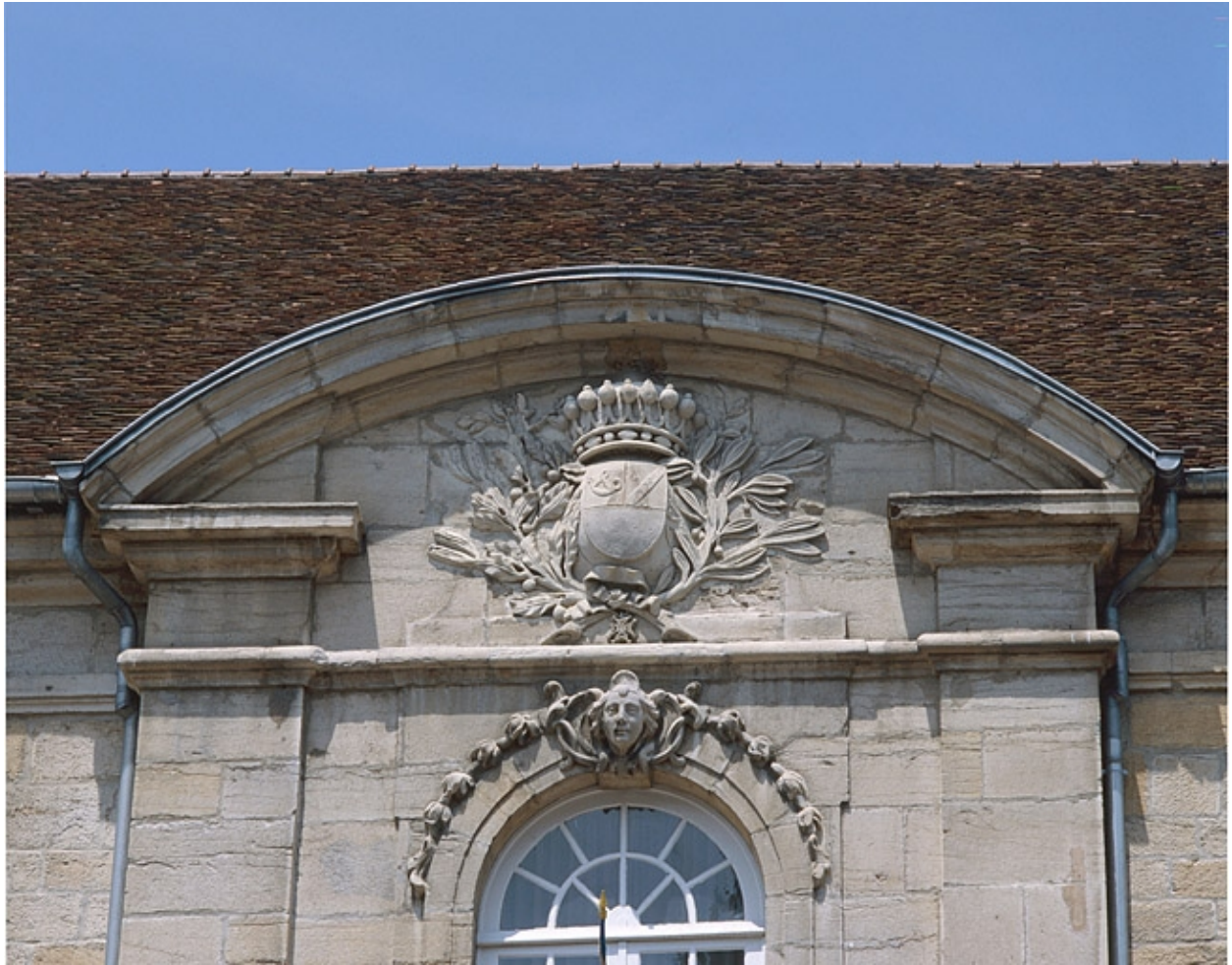
Détail du fronton de la façade sud.
