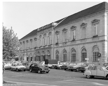
Façade nord vue de trois-quarts.
